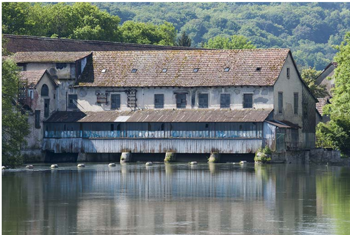
Vue rapprochée du bâtiment d'eau (centrale hydroélectrique). 25, Colombier-Fontaine rue de la Filature, lieudit : la Champagnole
