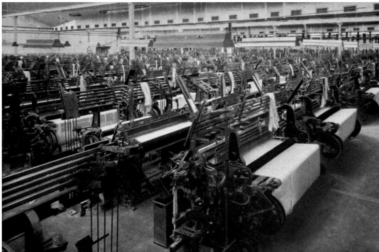
Batteries de métiers à tisser. Photogr., s.d. [vers 1950].
