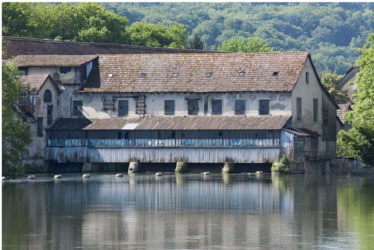
Vue rapprochée du bâtiment d'eau (centrale hydroélectrique). 25, Colombier-Fontaine rue de la Filature, lieudit : la Champagnole
