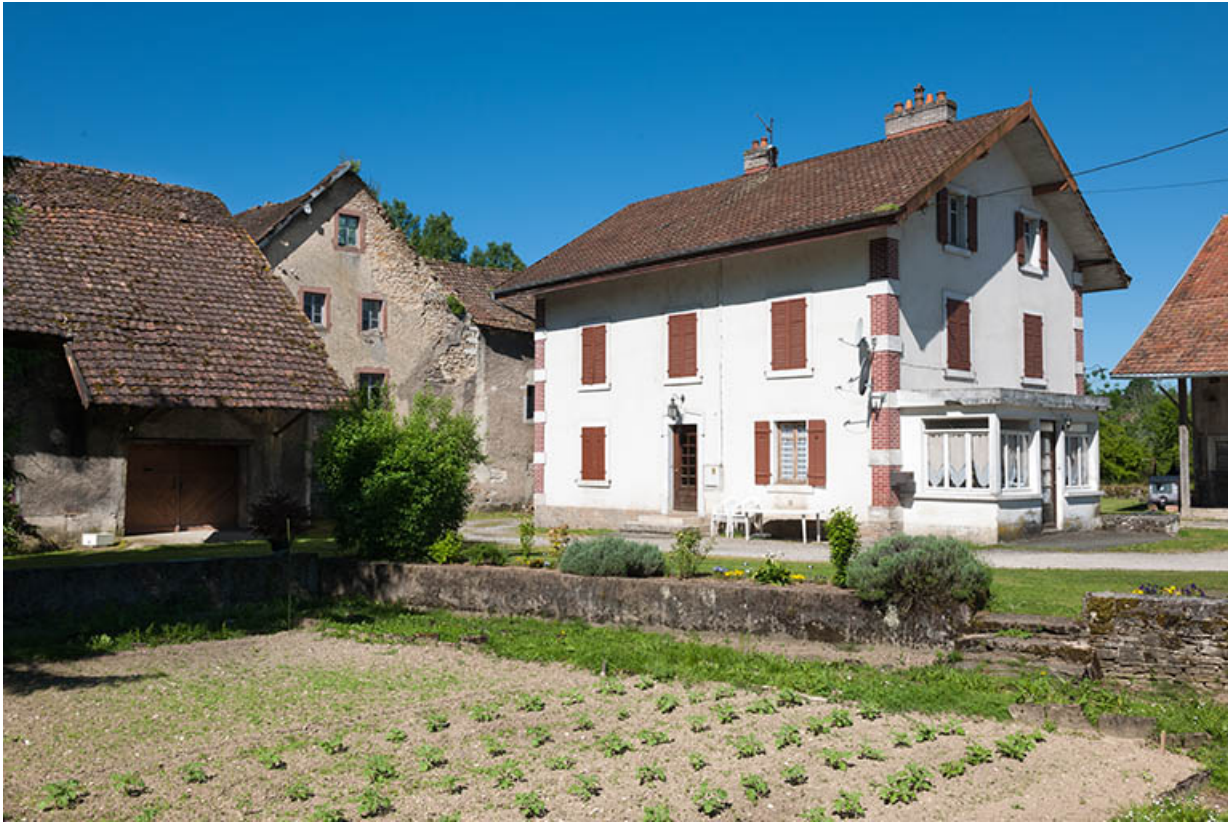
Moulin et logement vus depuis l'est.
