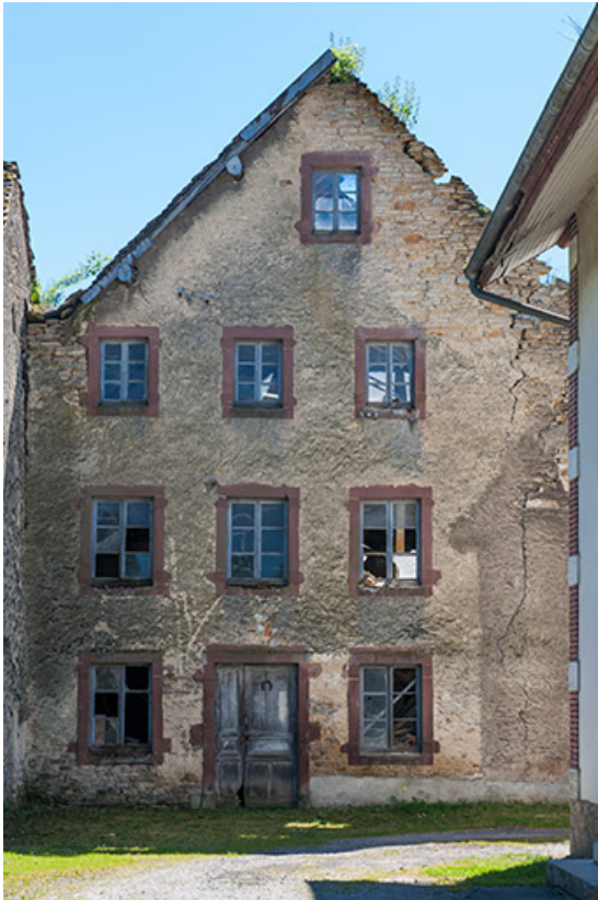
Pignon nord du moulin.
