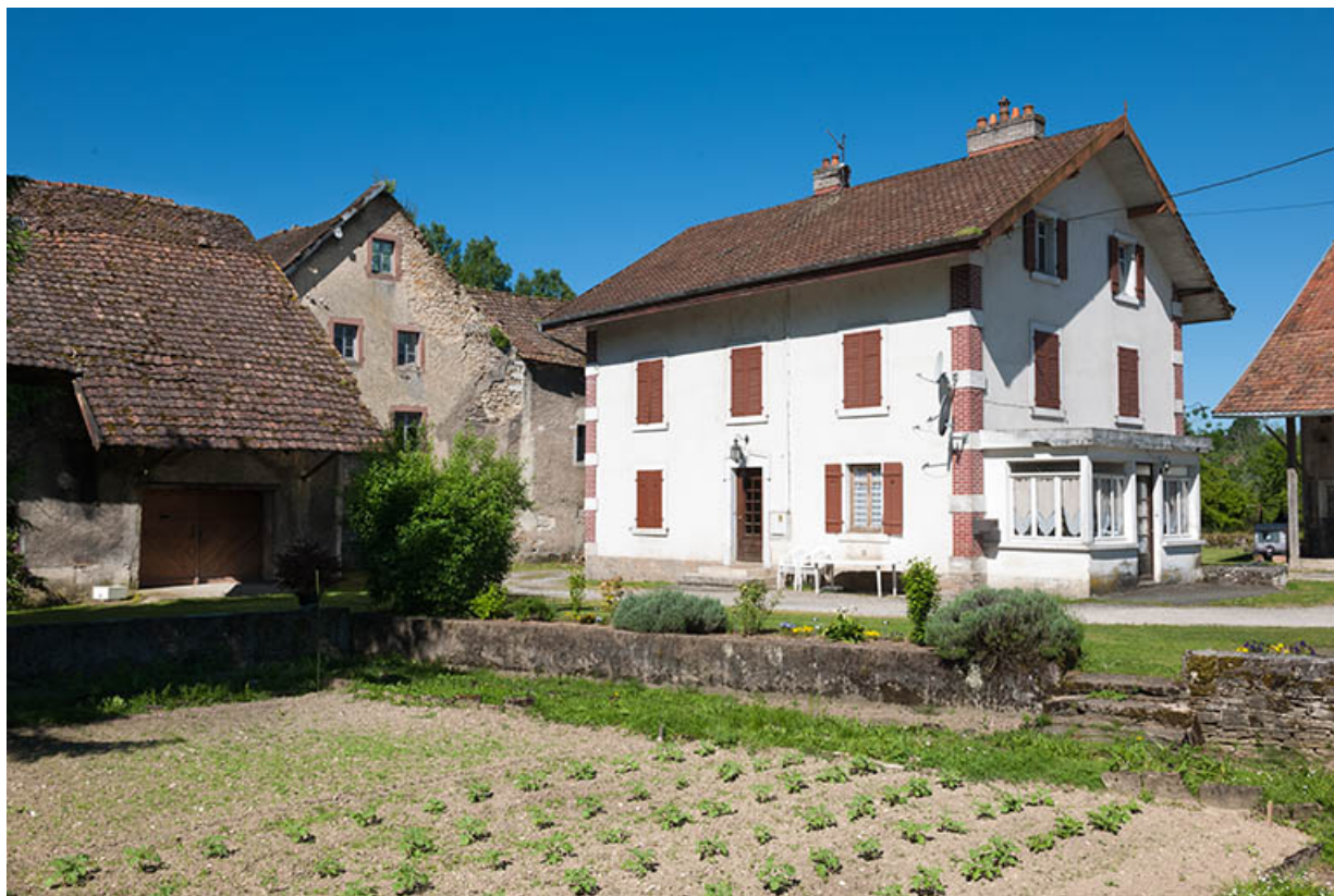
Moulin et logement vus depuis l'est.
