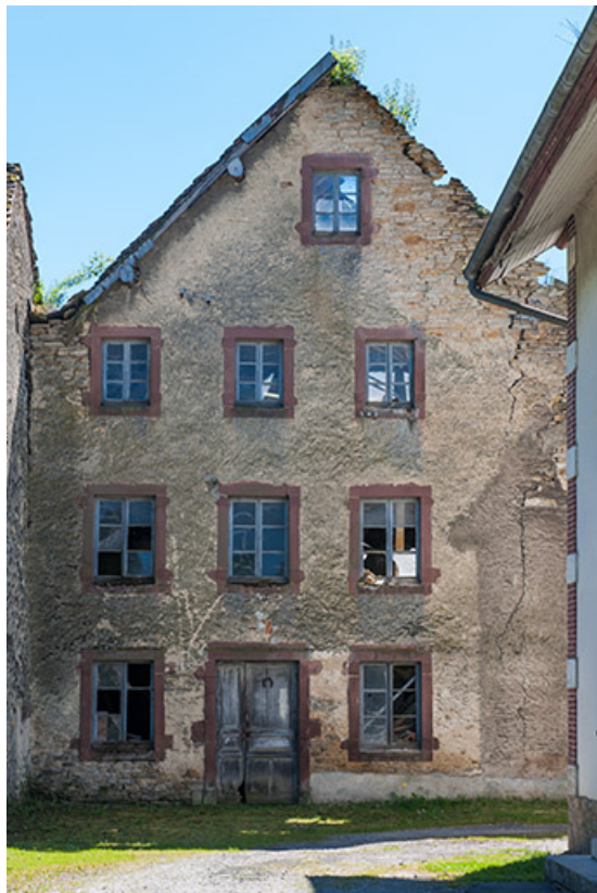
Pignon nord du moulin.
