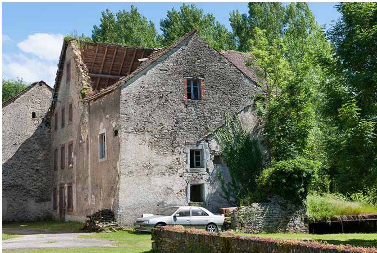
Le moulin depuis le nord-ouest.
