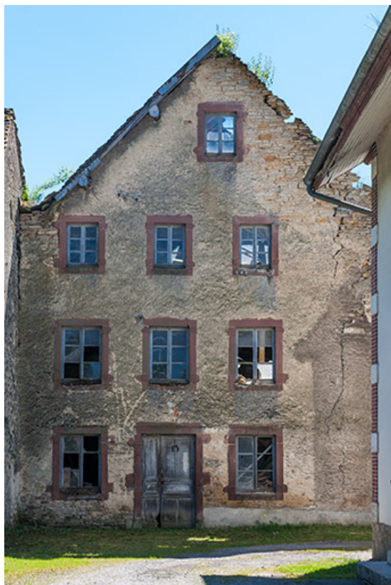
Pignon nord du moulin.
