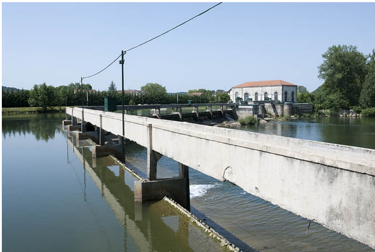
Vue éloignée depuis l'amont du barrage.
