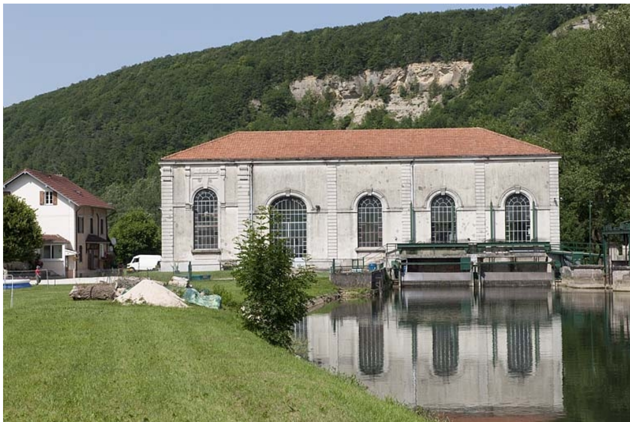
Façade sud de la centrale.
