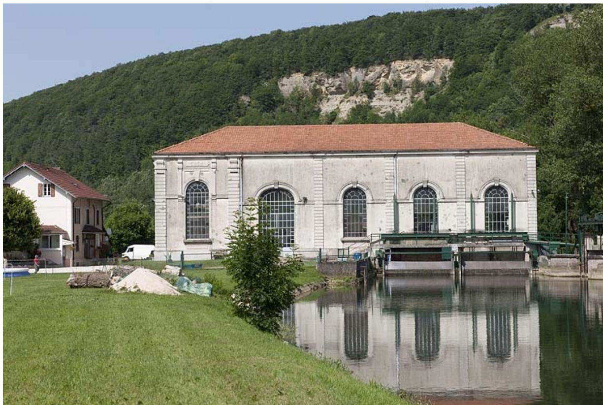
Façade sud de la centrale.
