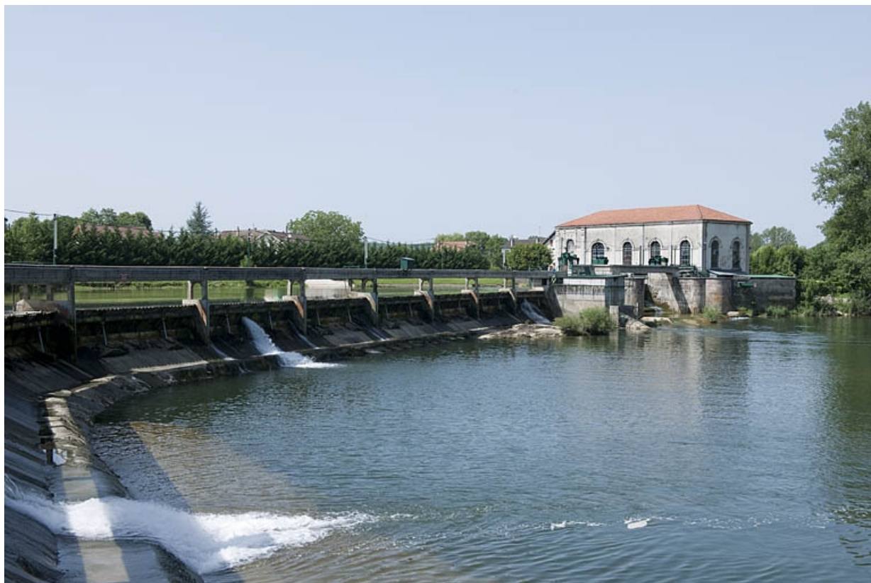
Le barrage et la centrale depuis le sud.
