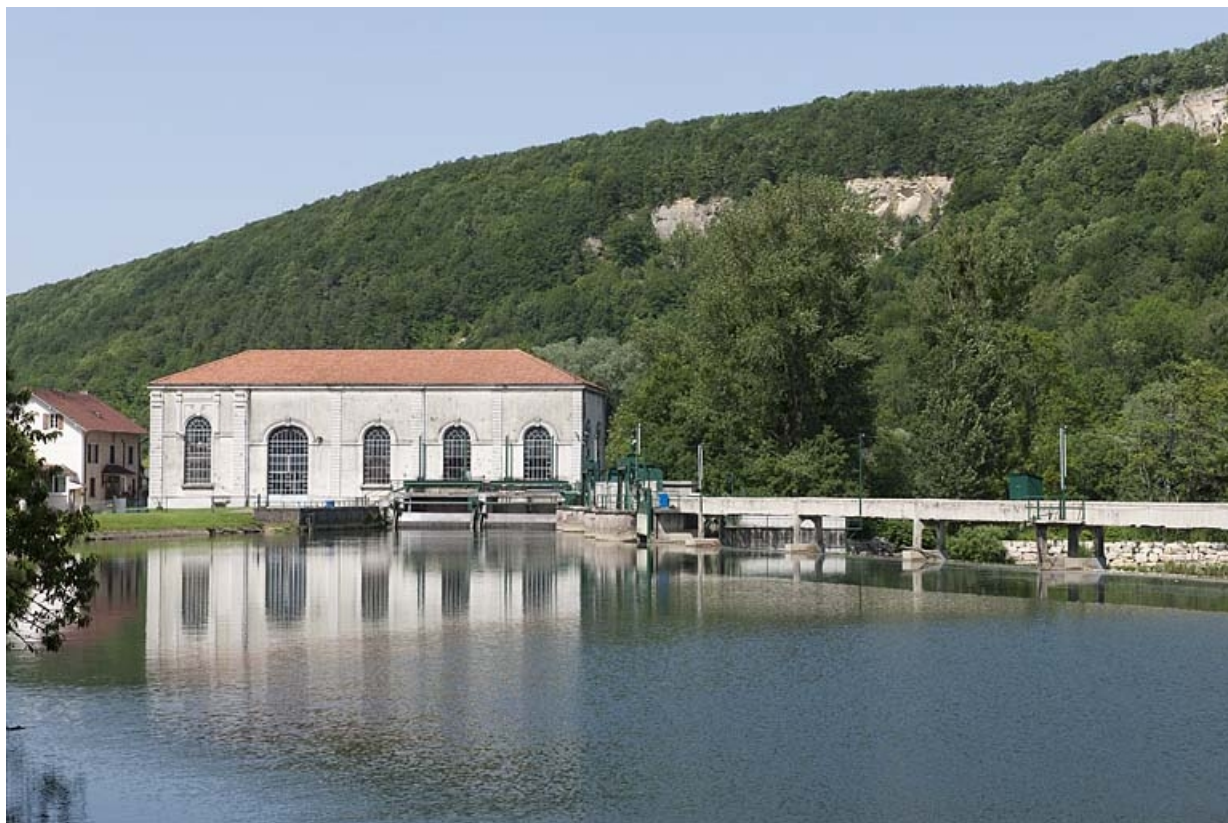
La centrale et le barrage depuis le sud.
