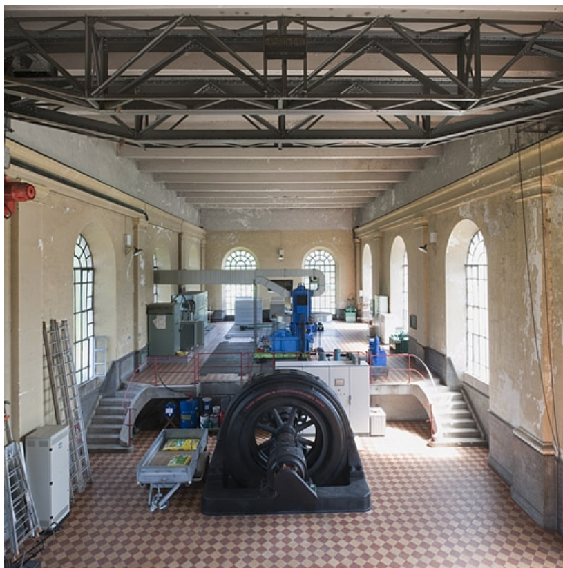
Vue intérieure, depuis le nord-ouest.
