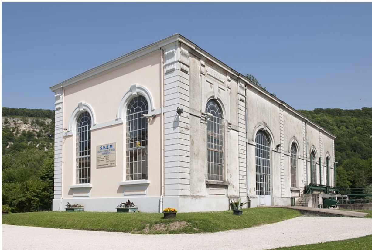
Centrale vue de trois quarts, depuis l'entrée. 25, Mathay, lieudit : rue du Barrage
