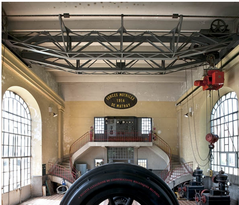
Vue intérieure, depuis le sud-est. 25, Mathay, lieudit : rue du Barrage
