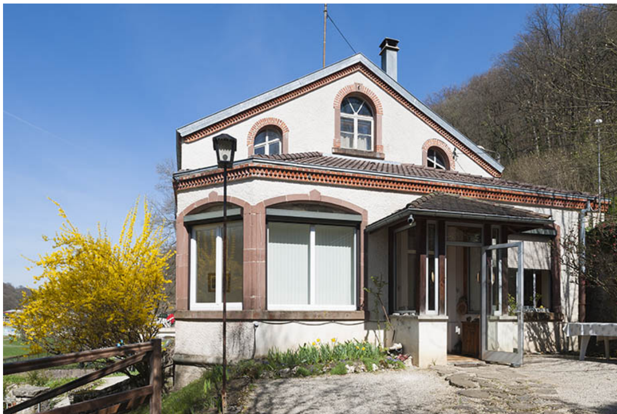
Pignon sud. Vestibule.
