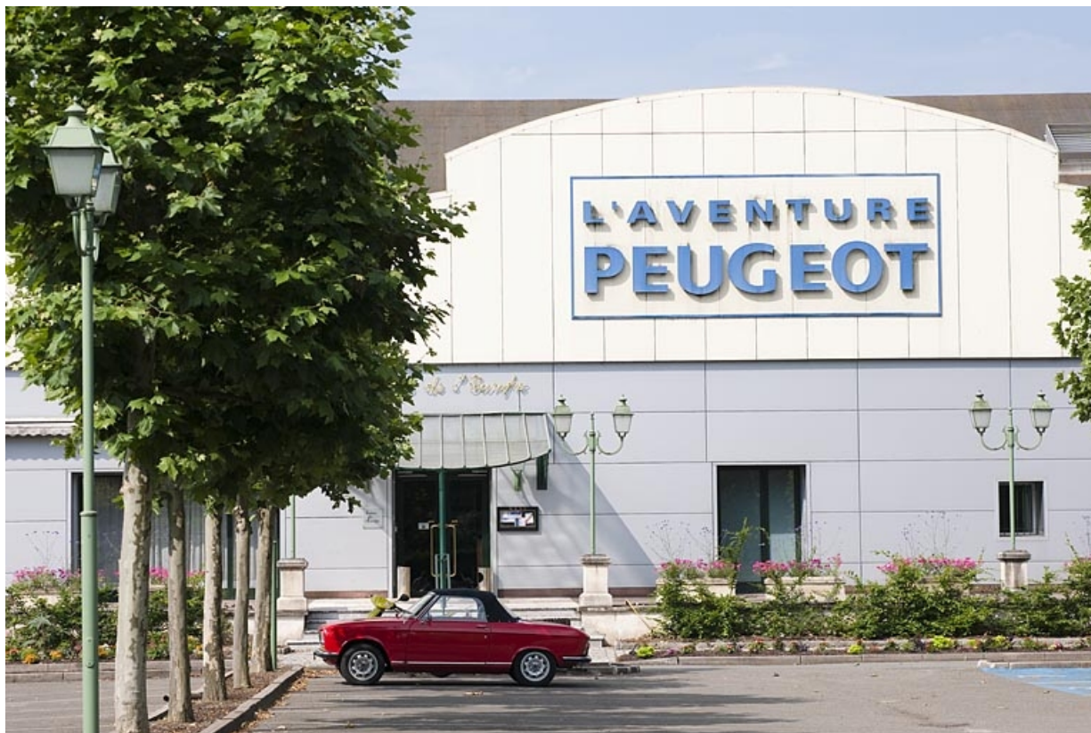
Détail de la façade est du musée.
