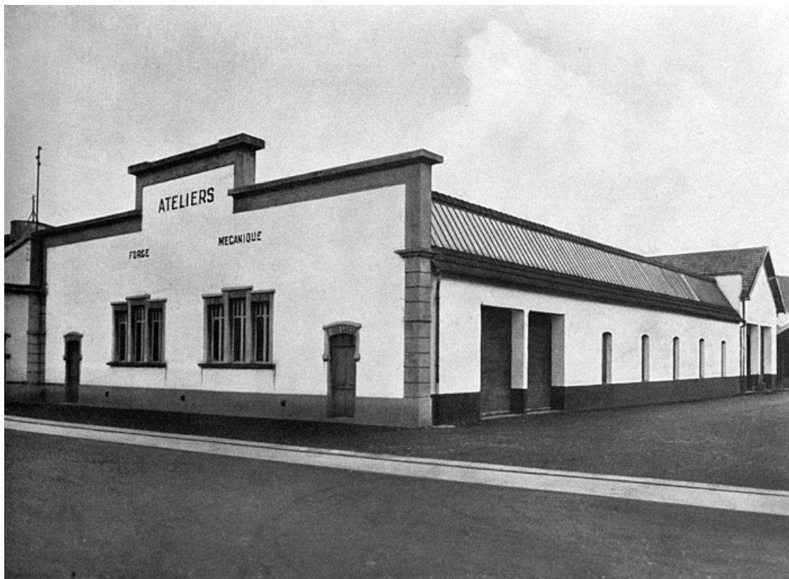
Ateliers de mécanique.
