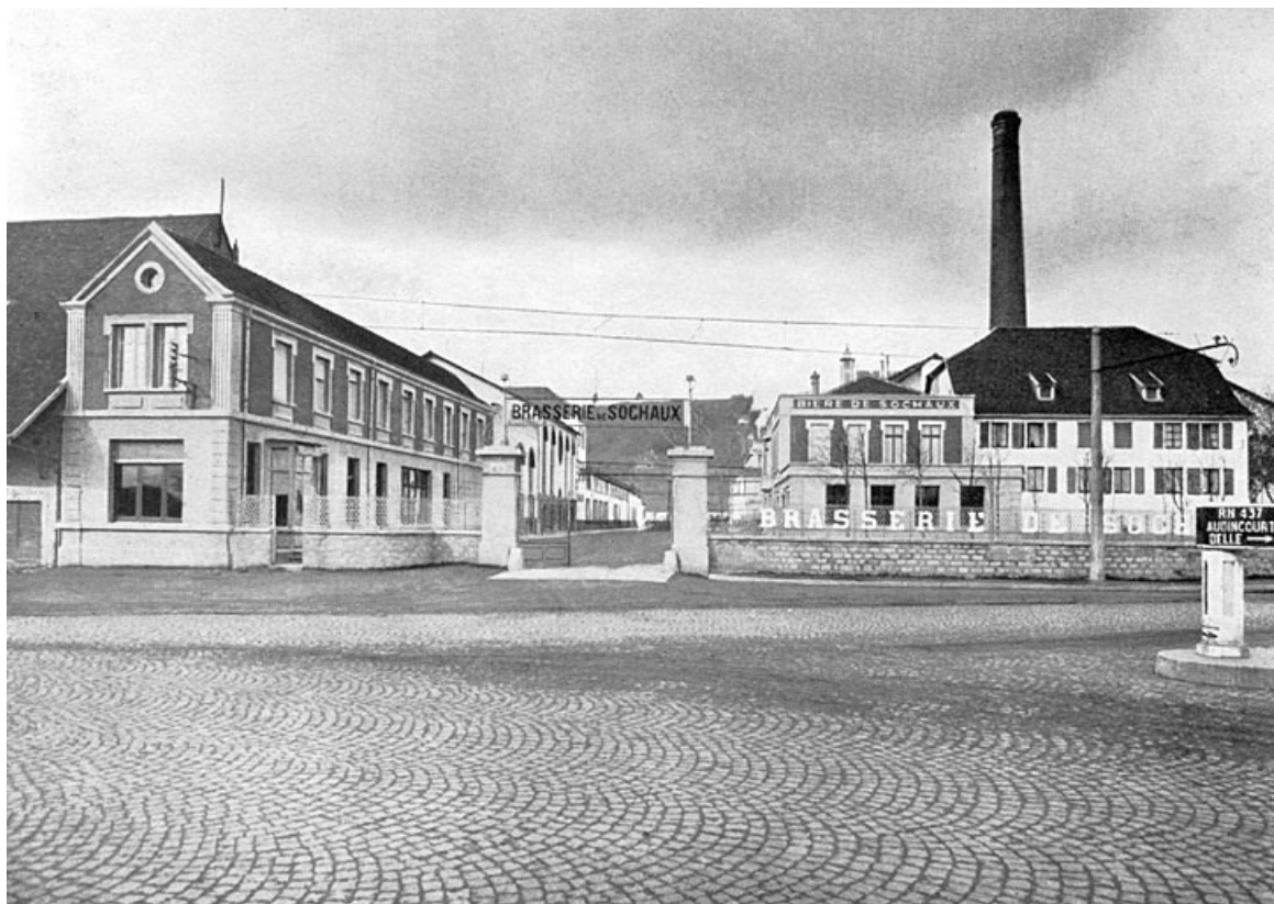
Vue d'ensemble de l'entrée.
