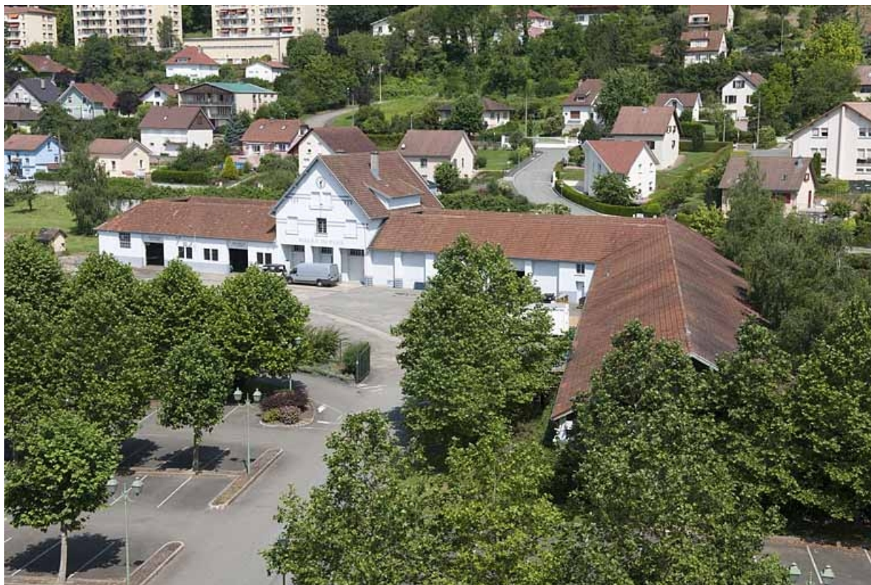
Vue plongeante sur les ateliers de réparation et les garages.
