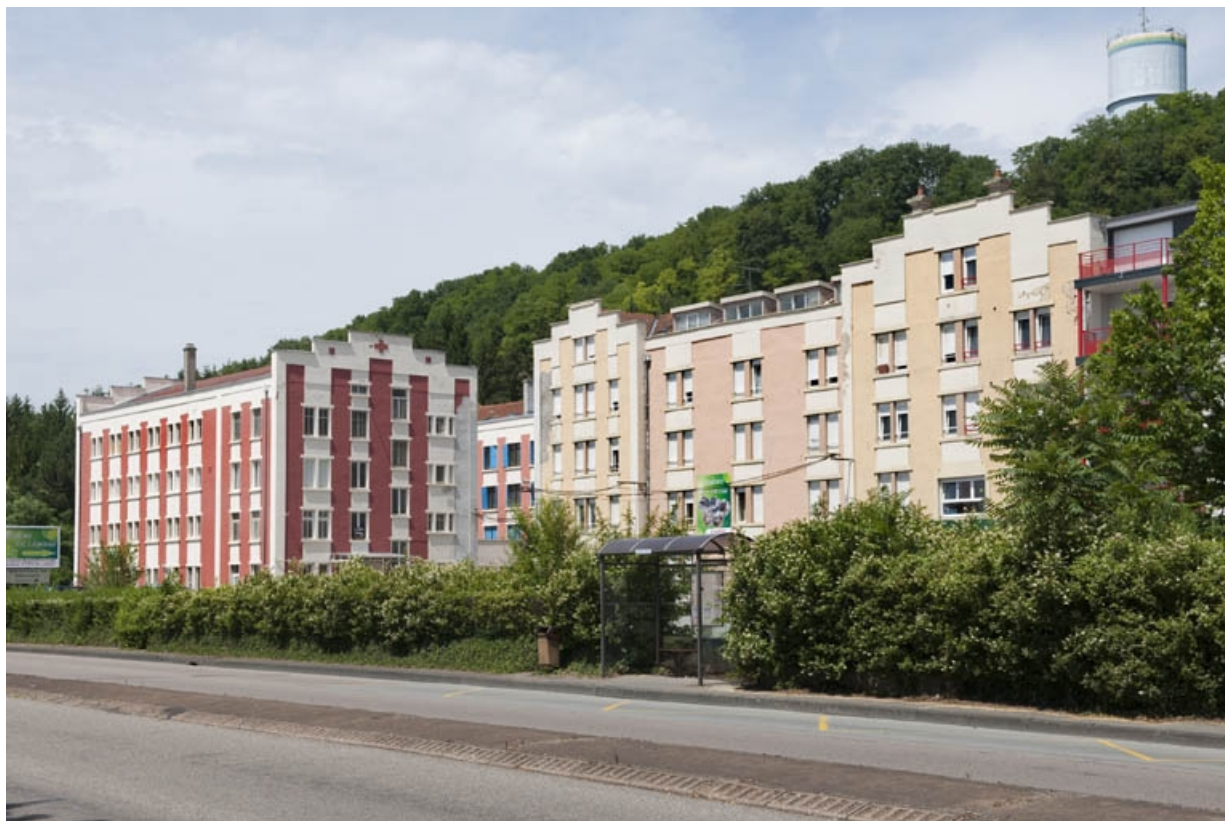
Vue d'ensemble depuis le sud-est.
