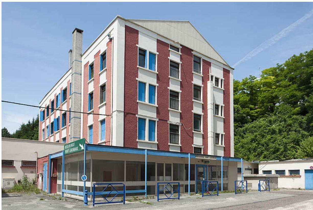
Immeuble de dortoirs (nord). Vue de trois quarts gauche. 25, Sochaux rue sous la Côte
