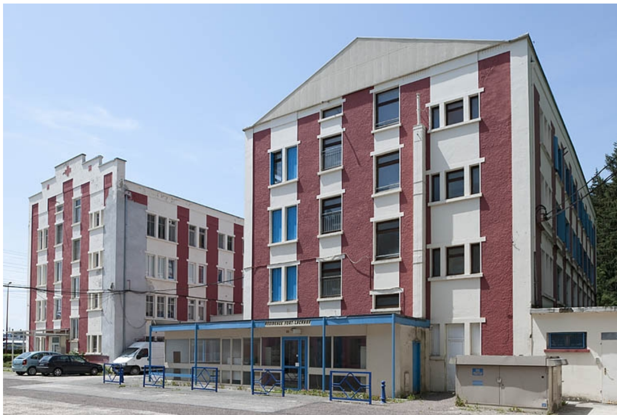
Pignons des immeubles de dortoirs. Vue de trois quarts droite.
