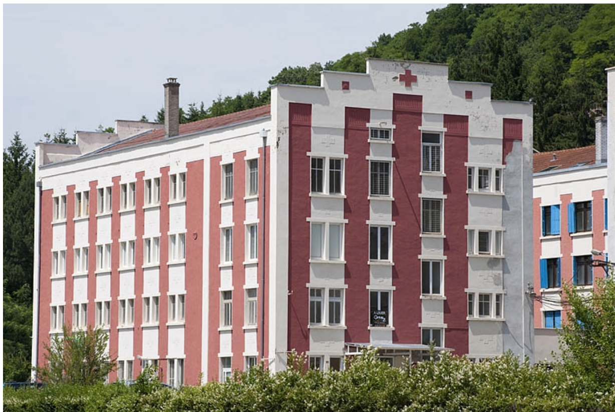
Immeuble de dortoirs (sud). Vue depuis le sud-est. 25, Sochaux rue sous la Côte
