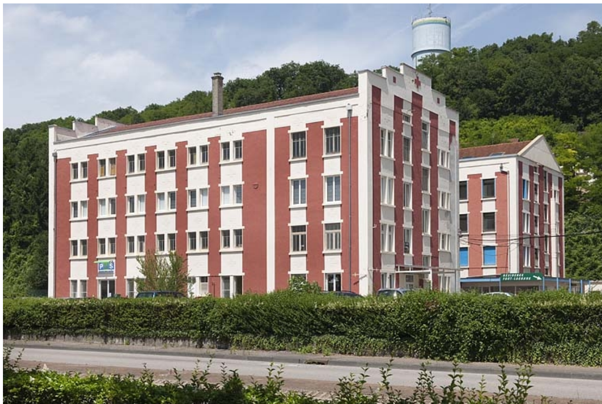
Immeuble de dortoirs. Vue depuis la route. 25, Sochaux rue sous la Côte
