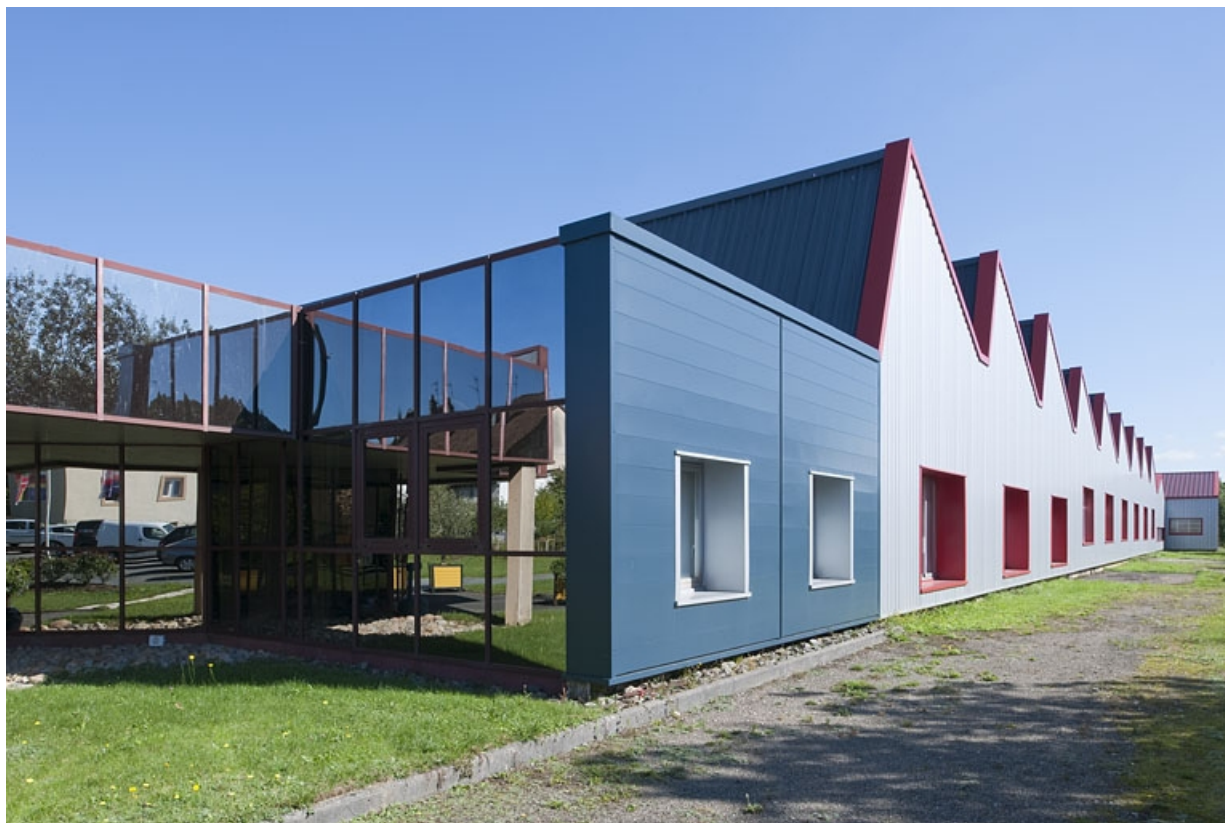
Façade sud de l'atelier de fabrication.
