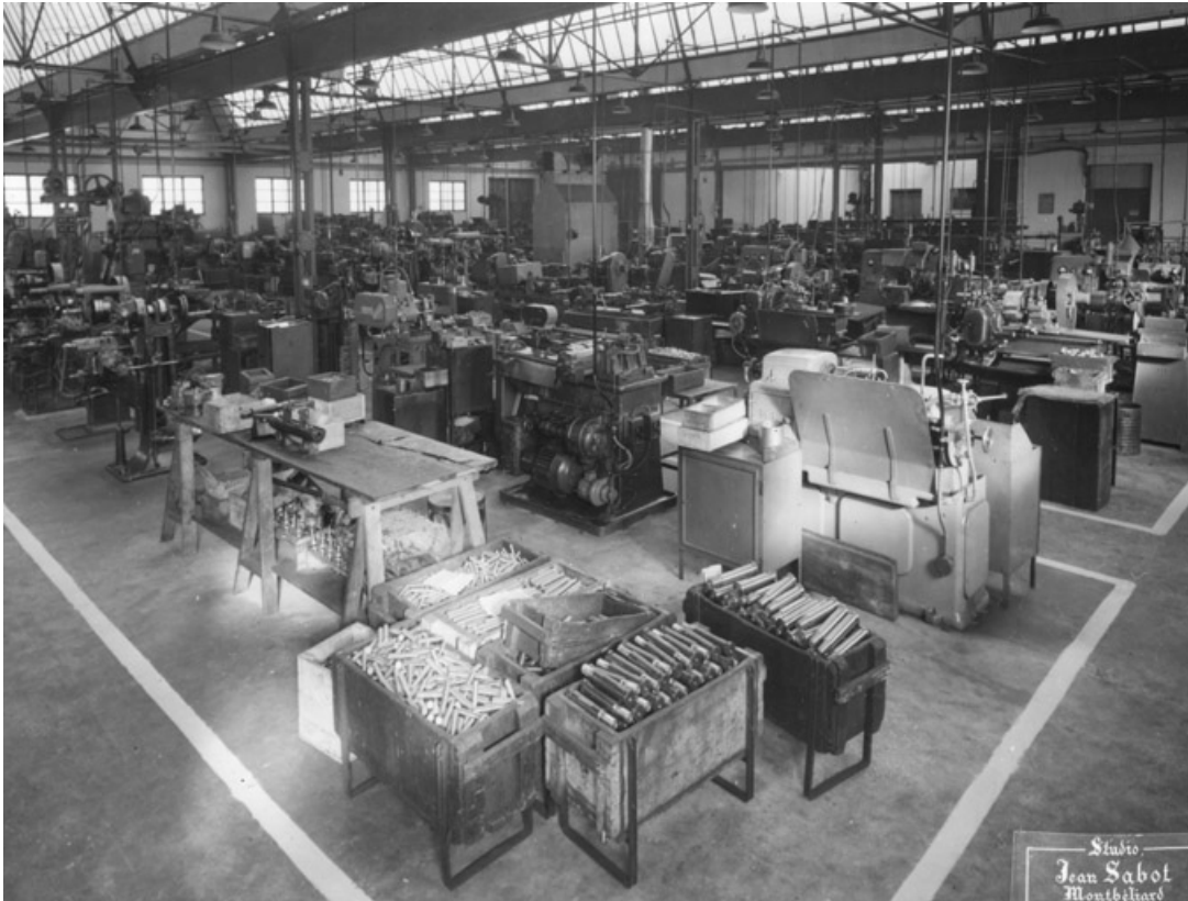
Vue d'ensemble de l'atelier.
