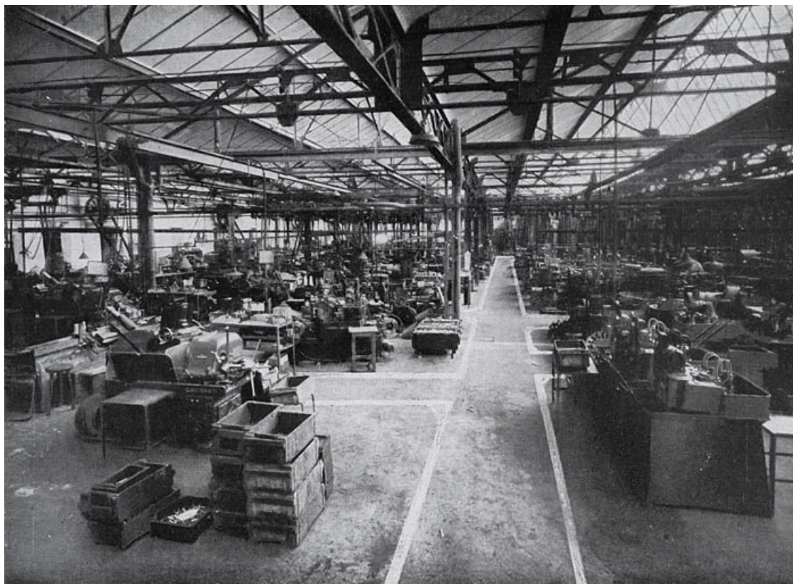
Vue d'ensemble de l'atelier principal.
