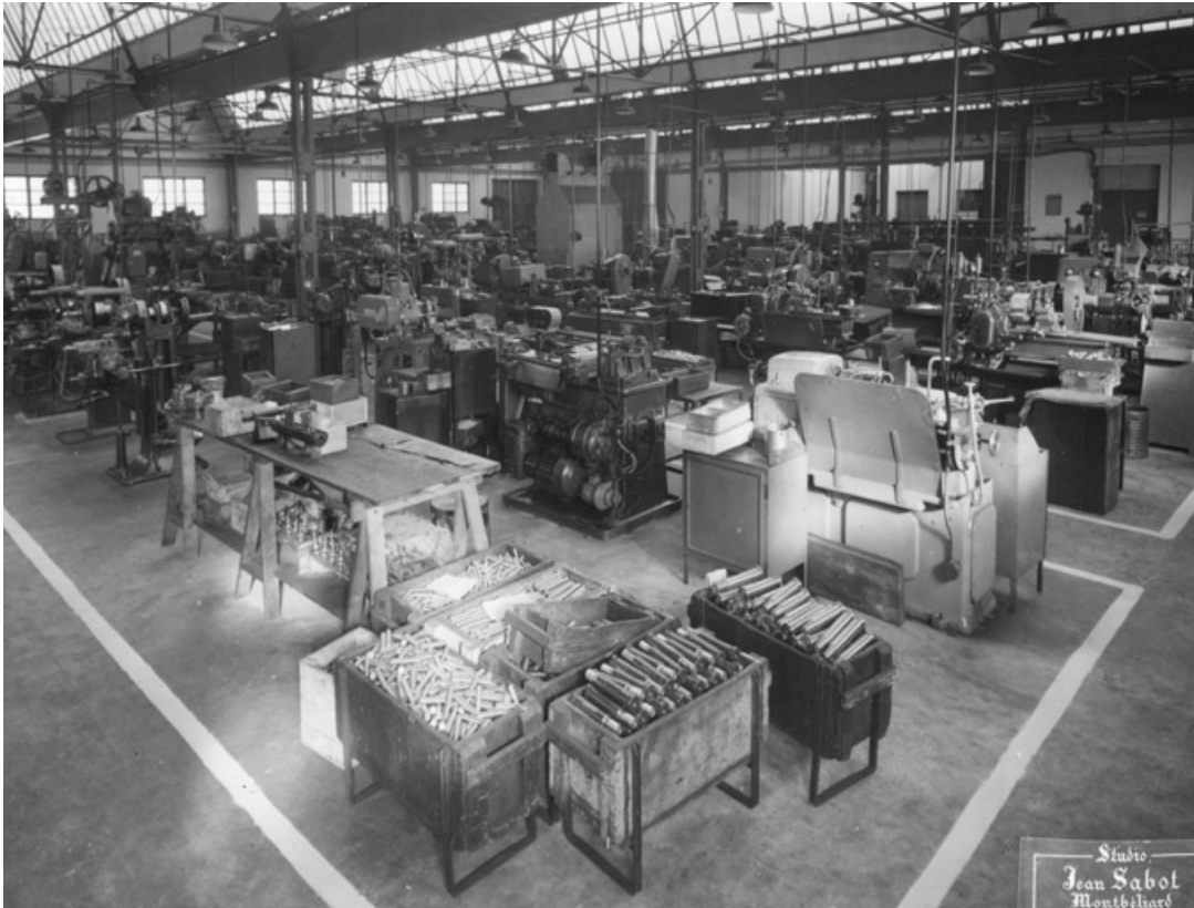
Vue d'ensemble de l'atelier.
