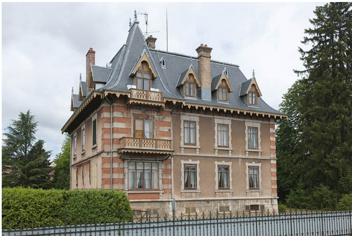
Logement patronal. Façade orientale. 25, Vieux-Charmont, 10 route de Belfort
