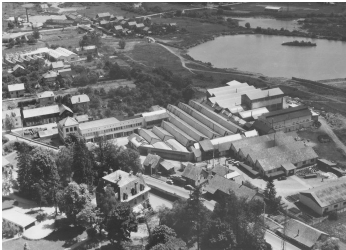
Vue aérienne de l'usine depuis le sud-ouest.
