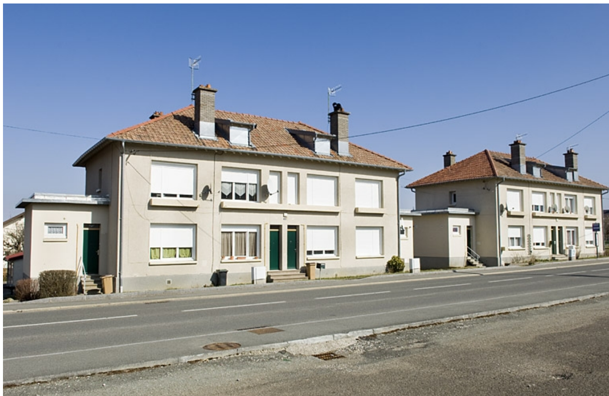
Ensemble d'habitations des années 1950. Vue depuis le nord-ouest. 25, Vieux-Charmont rue du Crepon
