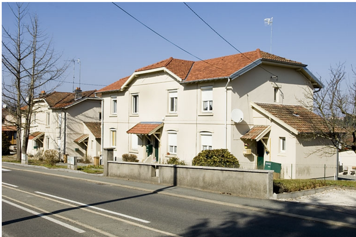
Habitations à quatre logements des années 1930.
