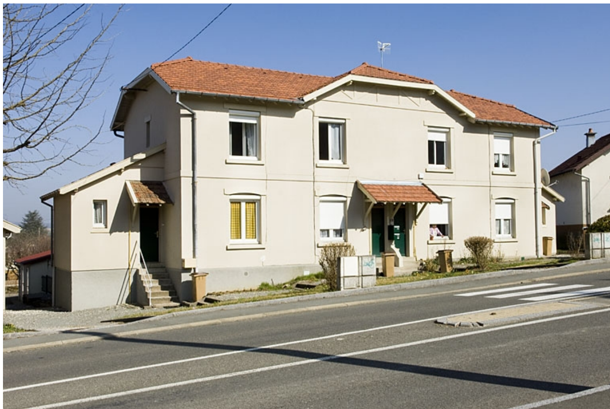
Habitations à quatre logements des années 1930. Vue de trois quarts. 25, Vieux-Charmont rue du Crepon
