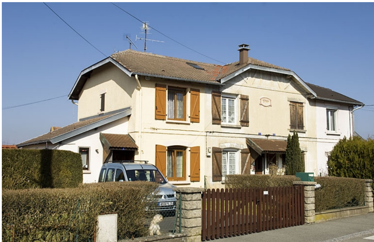
Habitation à 4 logements. Vue de trois quarts. 25, Grand-Charmont rue de Montbéliard
