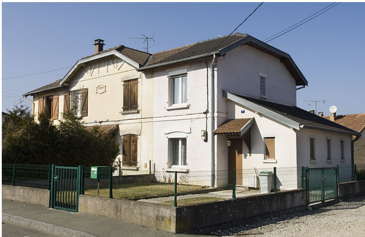
Habitation à 4 logements. Vue de trois quarts droite. 25, Grand-Charmont rue de Montbéliard
