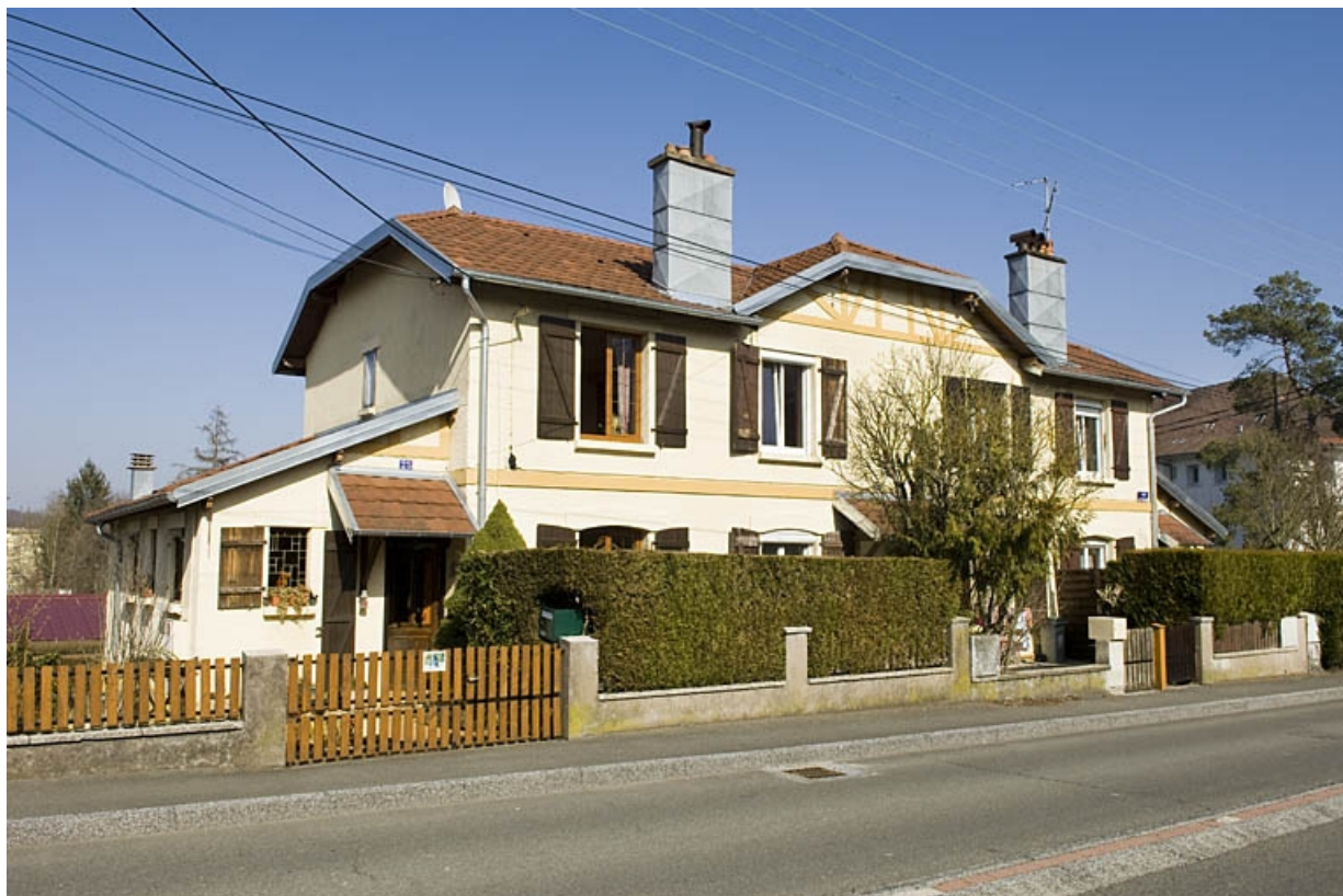
Habitation à 4 logements. Vue de trois quarts gauche. 25, Grand-Charmont rue de Montbéliard
