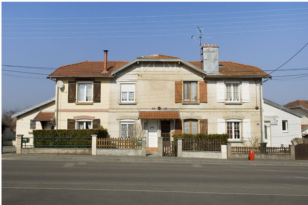
Habitation à 4 logements. Vue de face. 25, Grand-Charmont rue de Montbéliard
