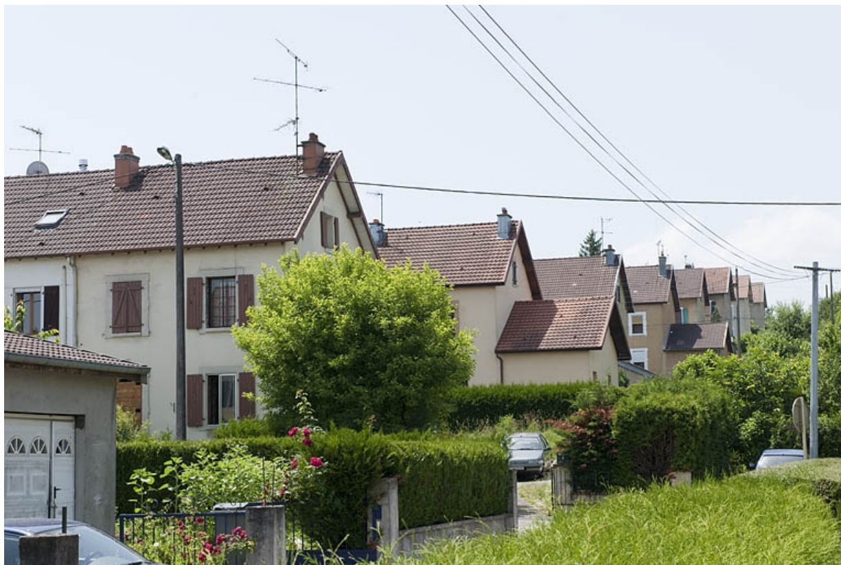
Pignons de maisons jumelées depuis le nord-est.
