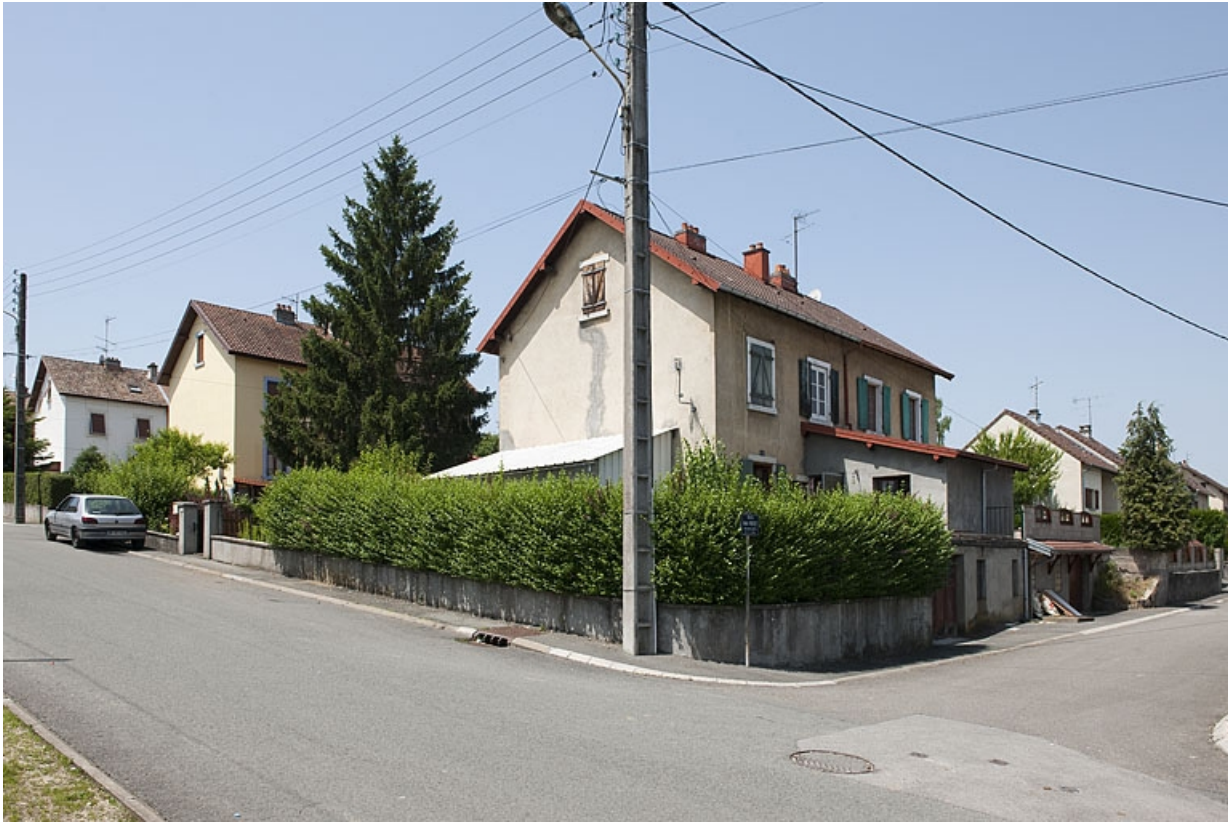
Maisons jumelées rue Robert Aubert. Vue depuis l'est.
