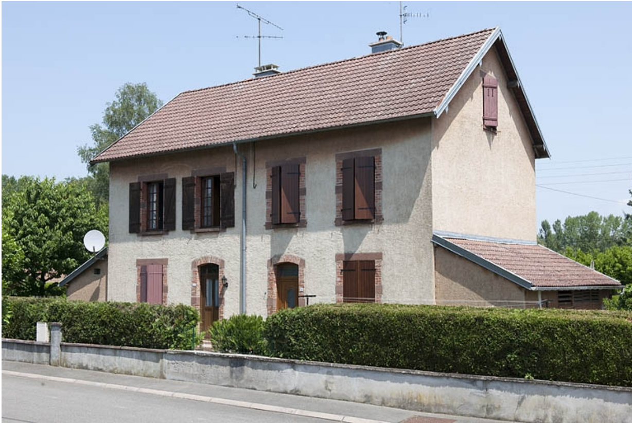
Maison jumelée à entrées contiguës. Vue de trois quarts.
