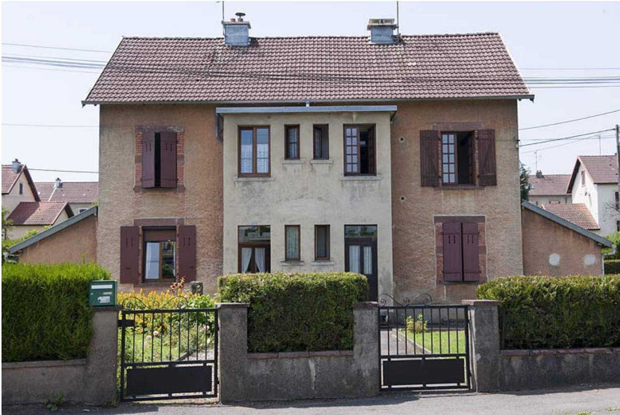
Maison jumelée à entrées saillantes rue d'Héricourt. Vue de face.
