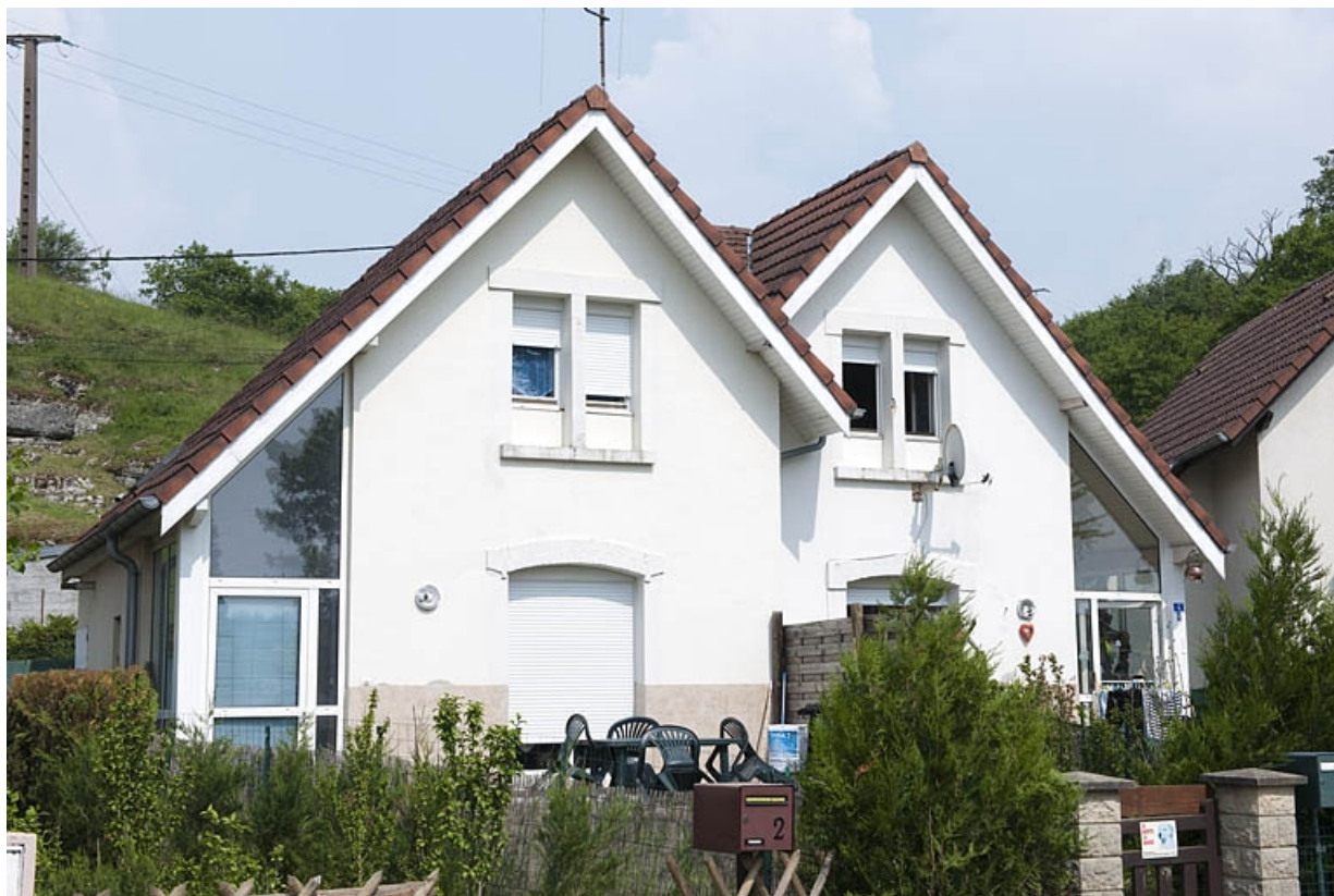
Cité du parc : façade antérieure d'une maison individuelle.
