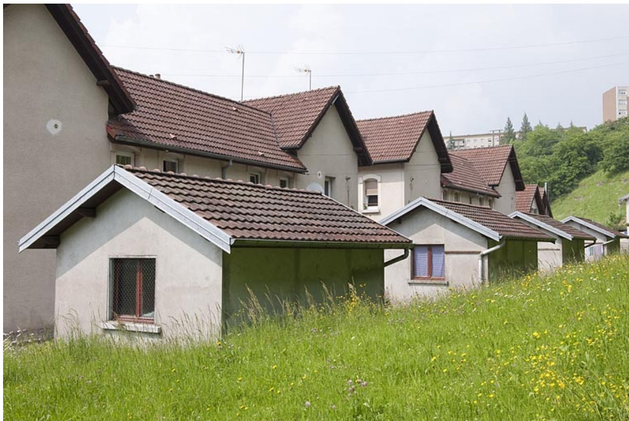
Cité du parc : façades postérieures des habitations de 4 logements. 25, Bethoncourt impasse de la Lizaine
