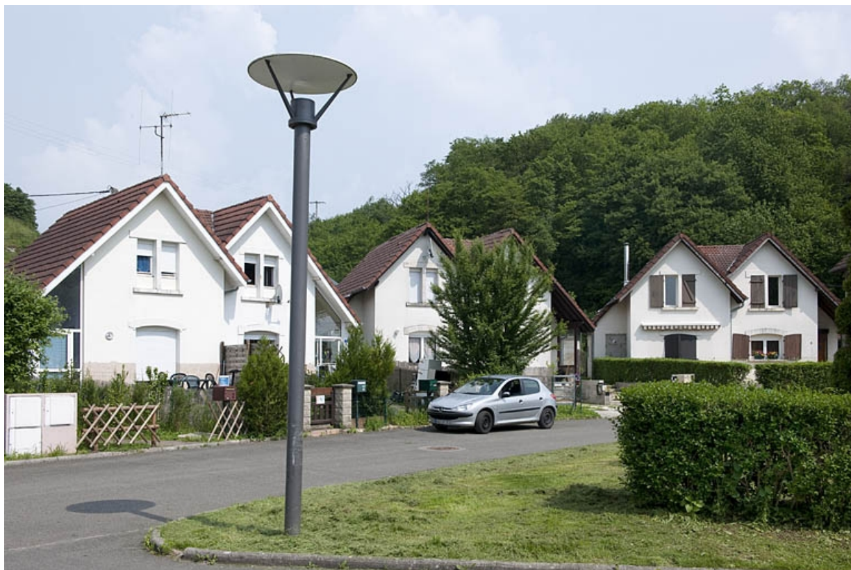
Cité du parc : maisons individuelles depuis l'ouest.
