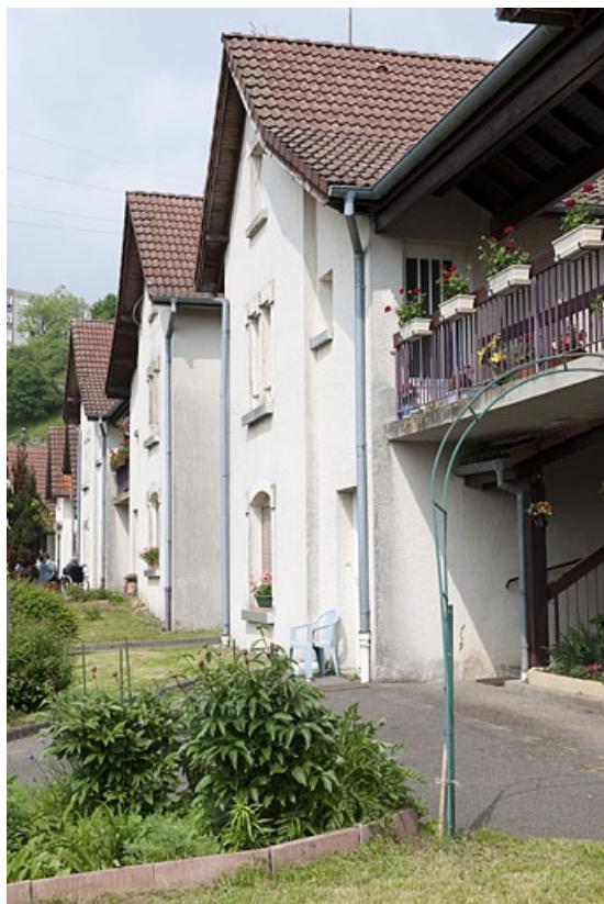
Cité du parc : habitations de 4 logements vues de trois quarts. 25, Bethoncourt impasse de la Lizaine
