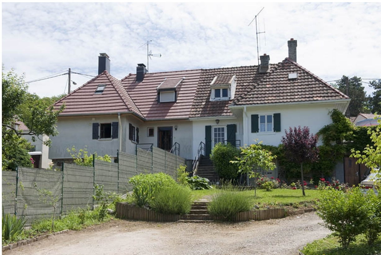
Maisons jumelles rue Raoul Delattre. Façades ouest.
