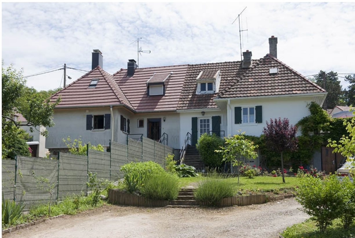
Maisons jumelles rue Raoul Delattre. Façades ouest.
