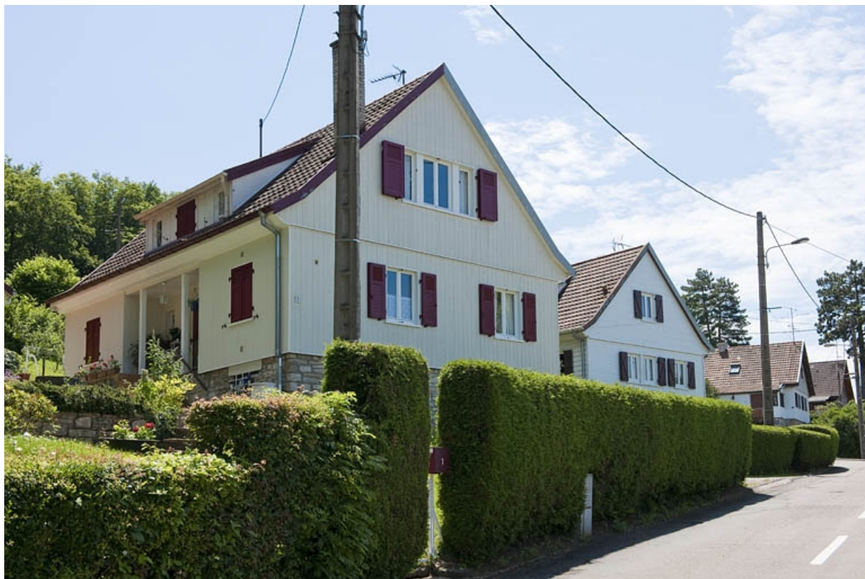
Pignons ouest des maisons rue Raoul Delattre.
