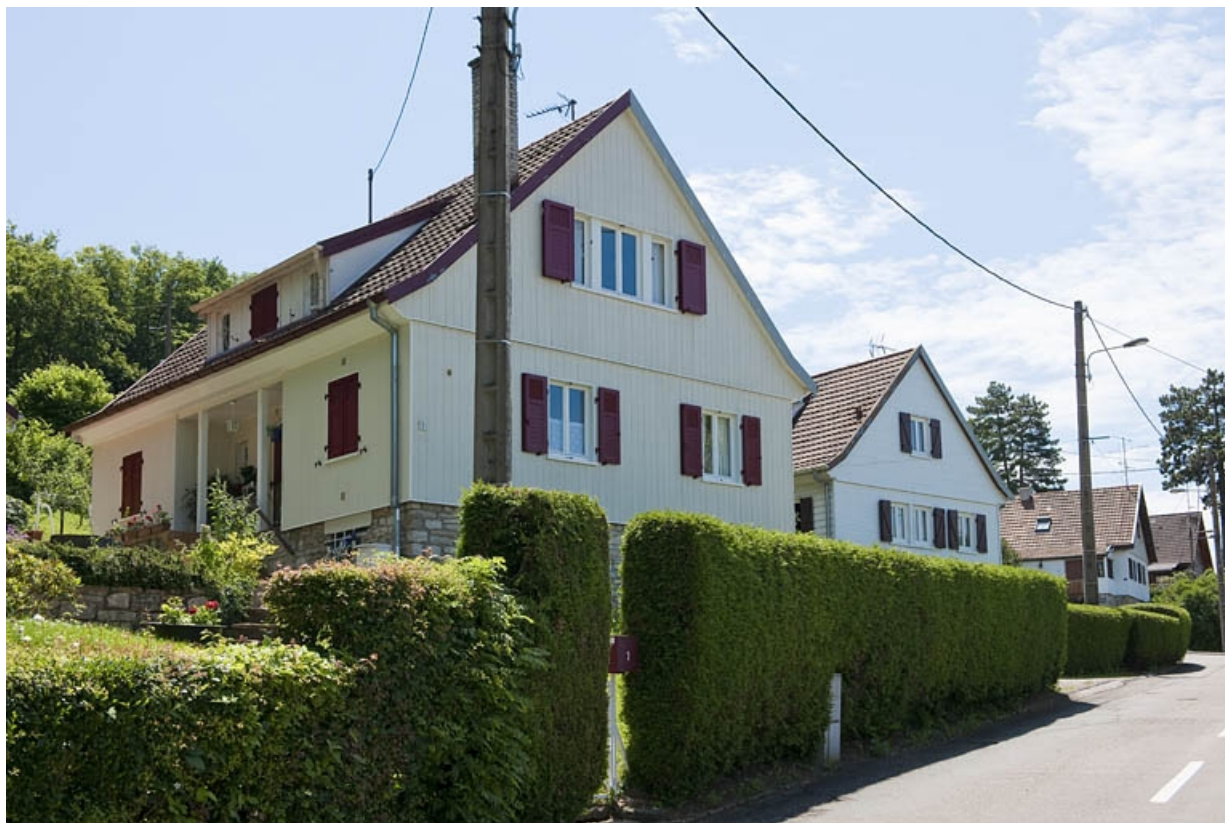
Pignons ouest des maisons rue Raoul Delattre.
