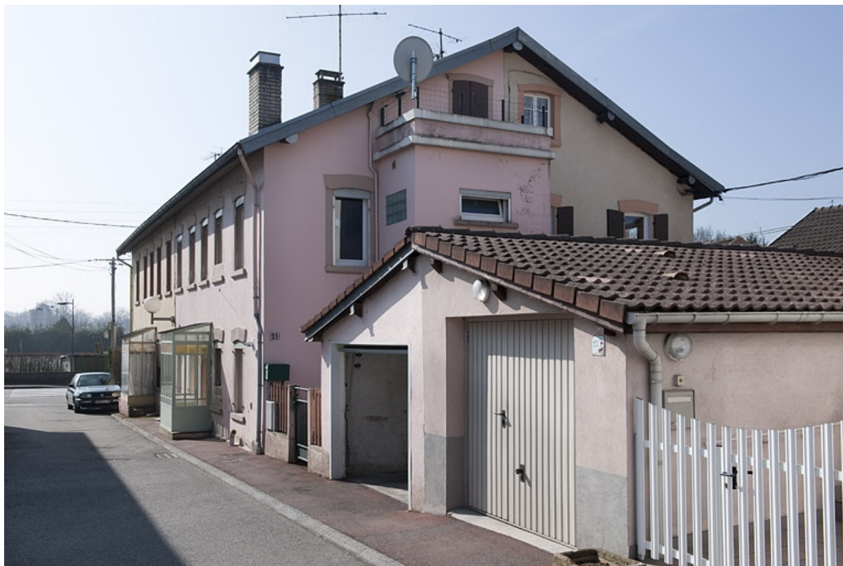
Habitation à 8 logements vue de trois quarts. 25, Sainte-Suzanne rue des Lilas
