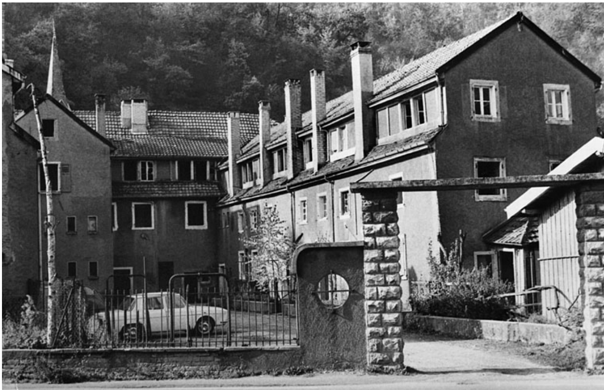
Bâtiments industriels situés à l'ouest de la route nationale.
