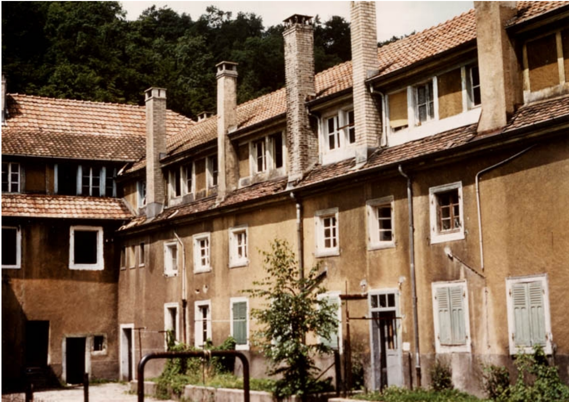
Façade sur cour de l'aile nord.
