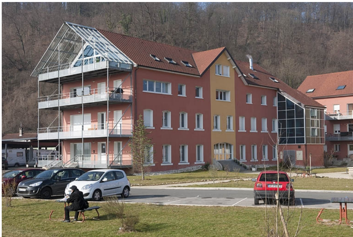
Atelier de fabrication vu de trois quarts. 25, Sainte-Suzanne, 61 rue de Besançon
