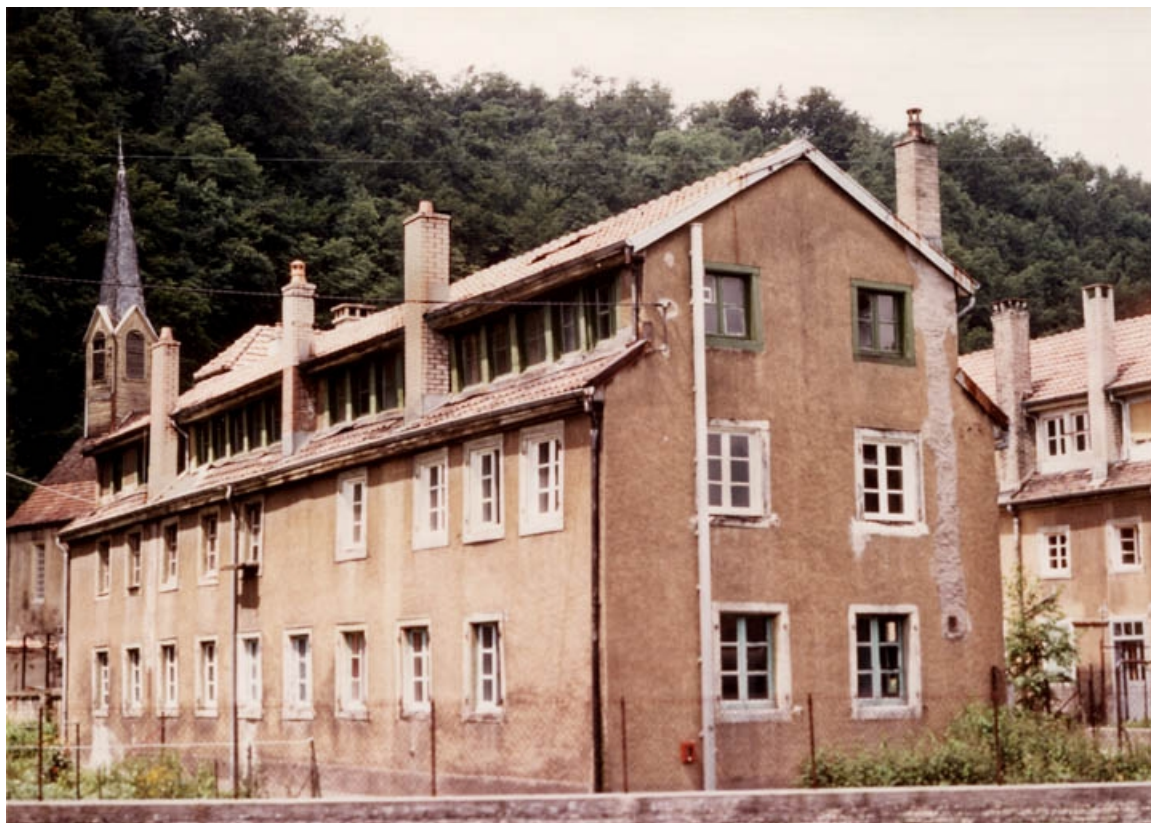
Vue d'ensemble des ateliers d'origine, depuis le sud-est.
