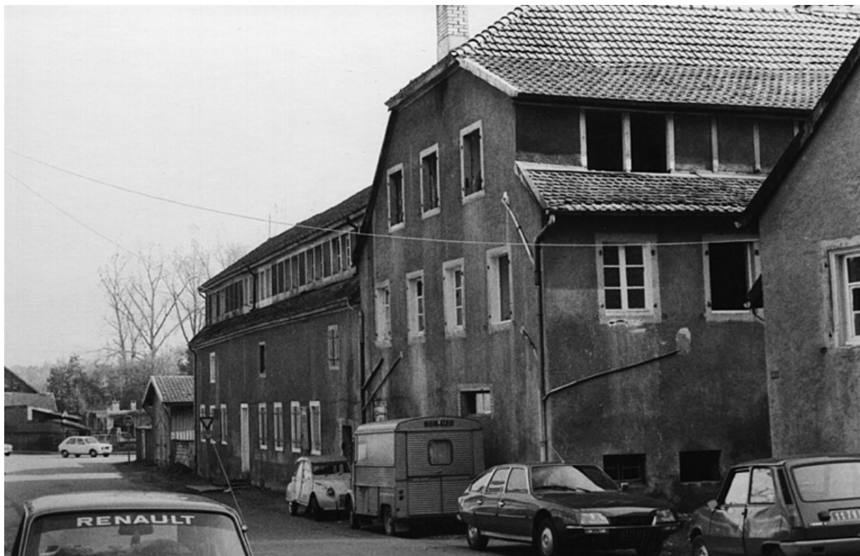
Vue des bâtiments depuis l'ouest.
