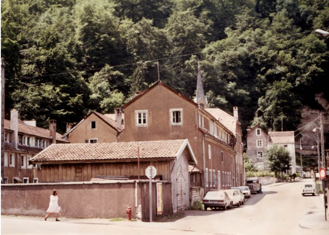
Vue d'ensemble des ateliers d'origine, depuis l'est.
