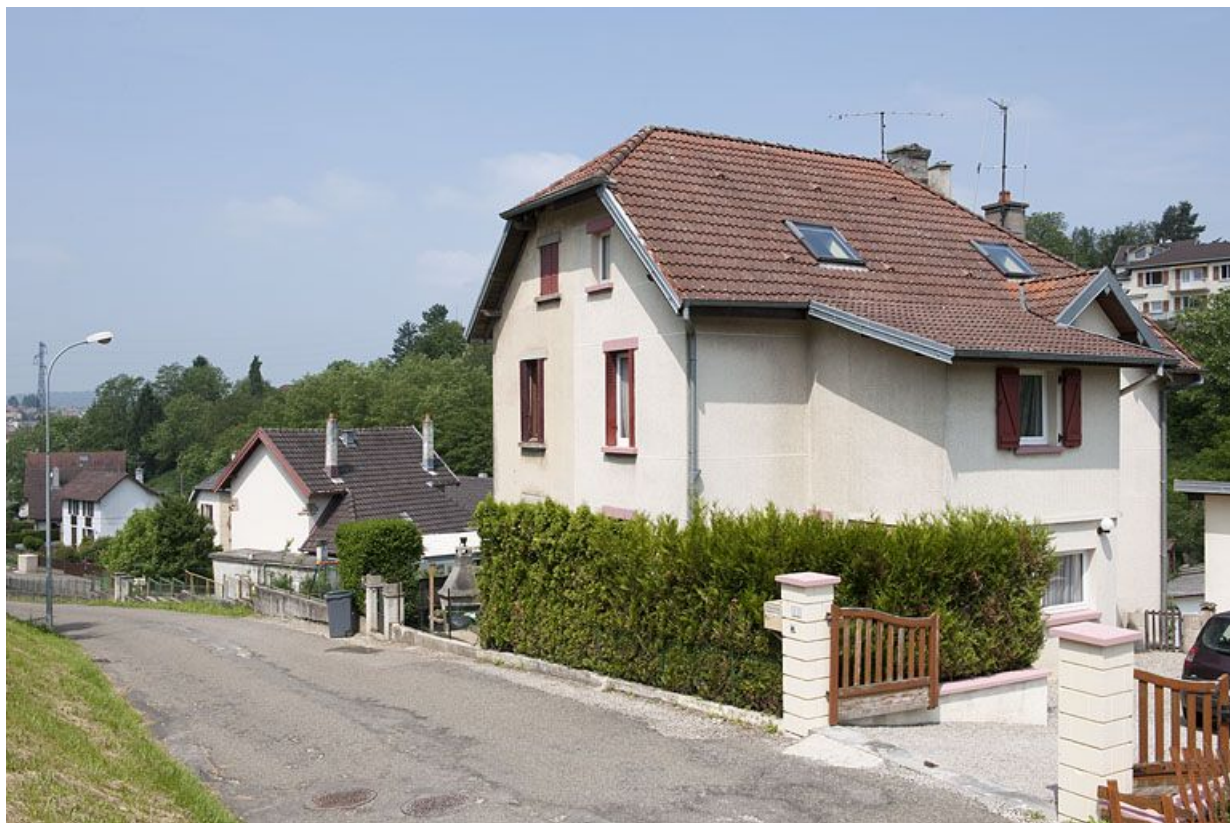
Maison jumelée. Vue de trois quarts droite.
