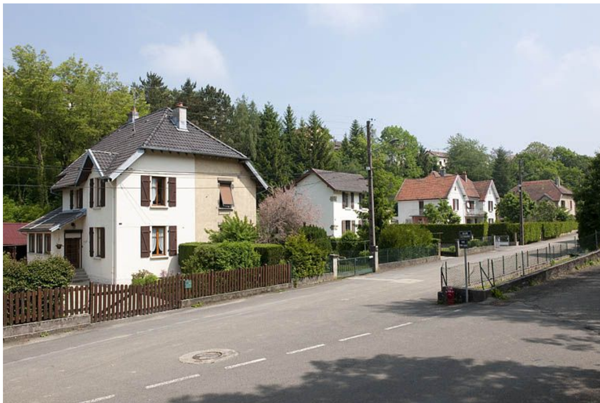
Vue d'ensemble de la rue la Combe Guenot. 25, Seloncourt, 5 à 13 rue de la Combe Guenot
