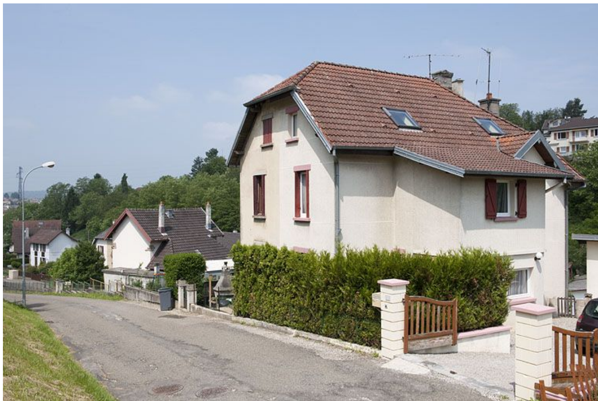
Maison jumelée. Vue de trois quarts droite.
