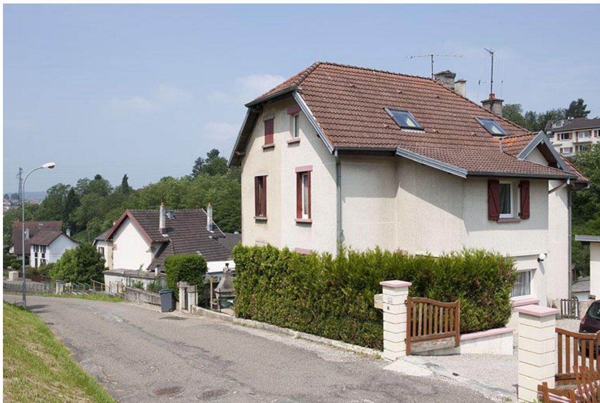
Maison jumelée. Vue de trois quarts droite.
