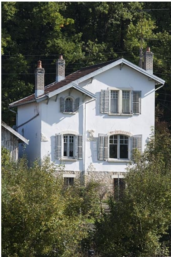
Pignon d'une maison individuelle.
