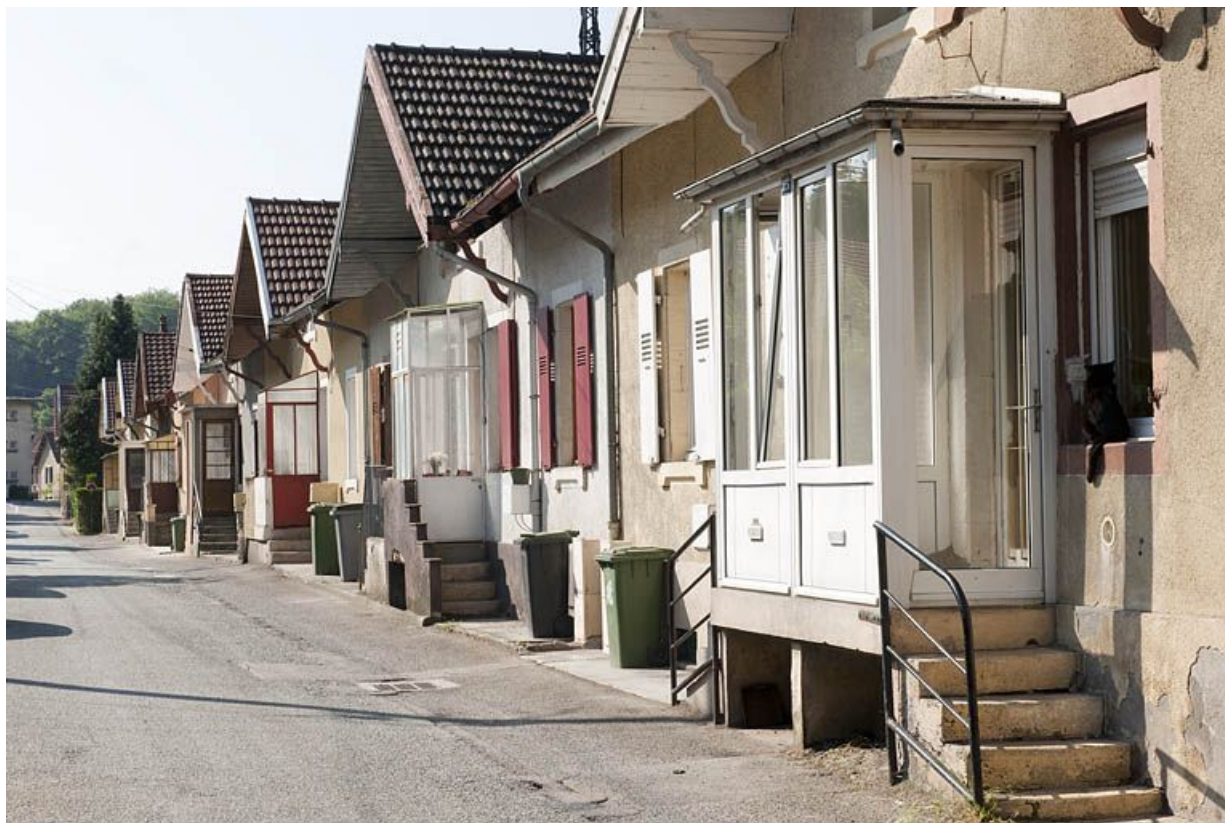
Vue d'ensemble depuis le nord des logements dits "casernes".
