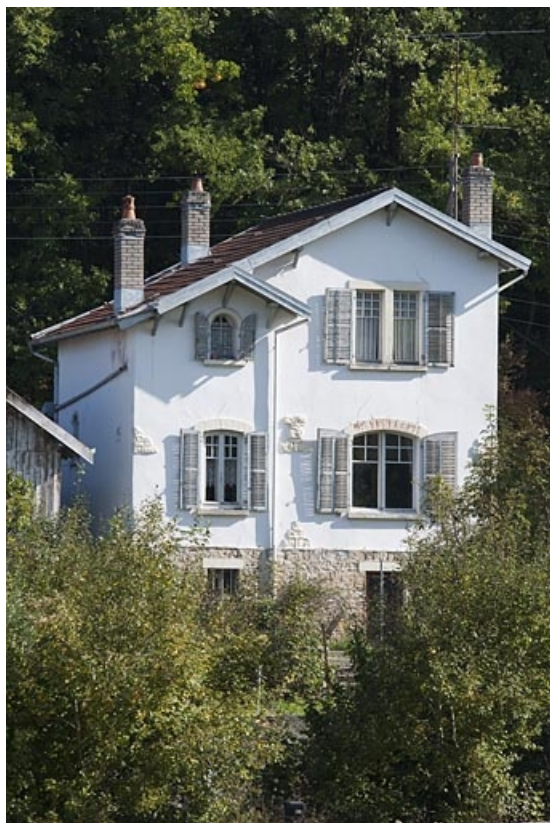
Pignon d'une maison individuelle.
