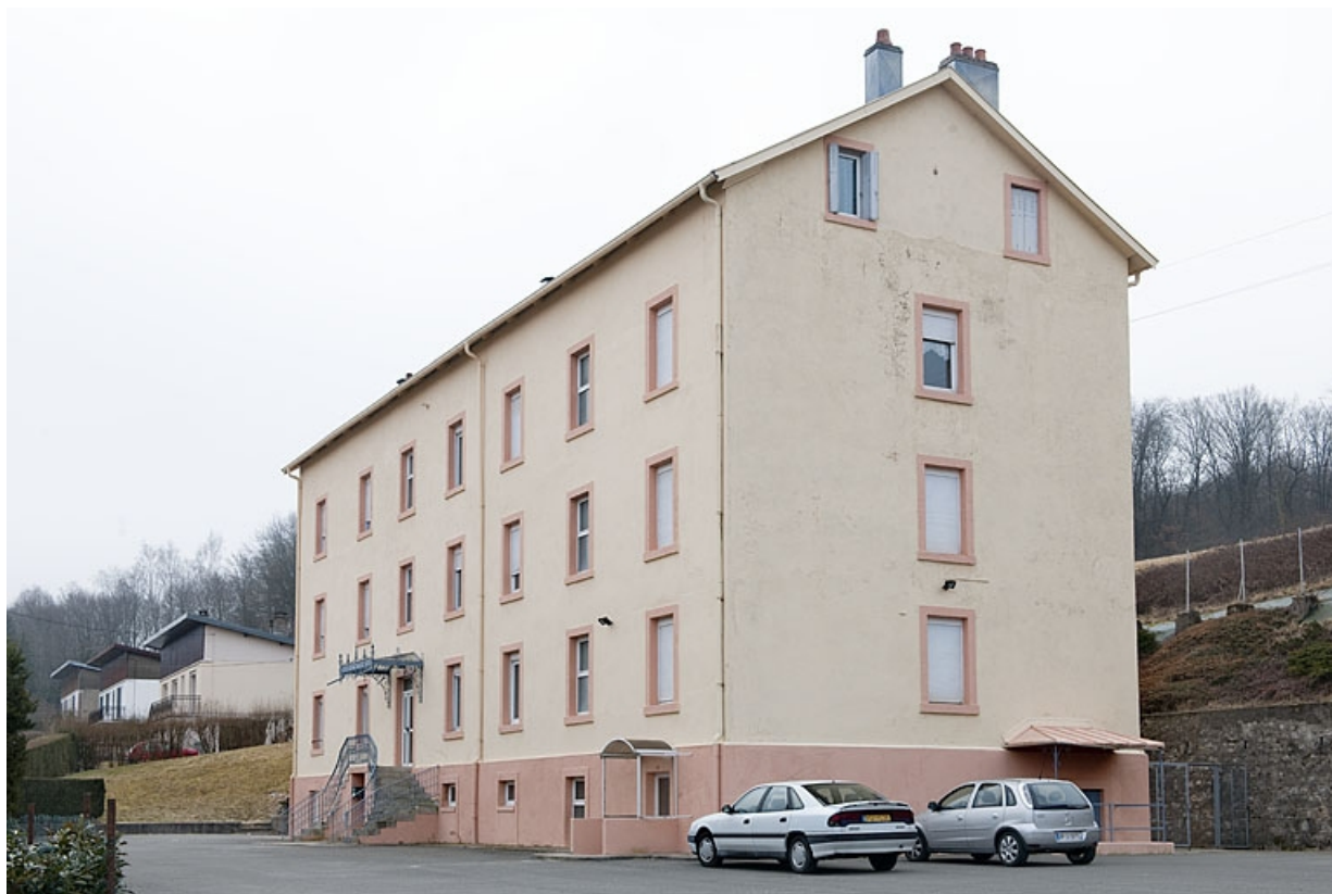
Vue d'ensemble depuis le nord-ouest. 25, Fesches-le-Châtel
