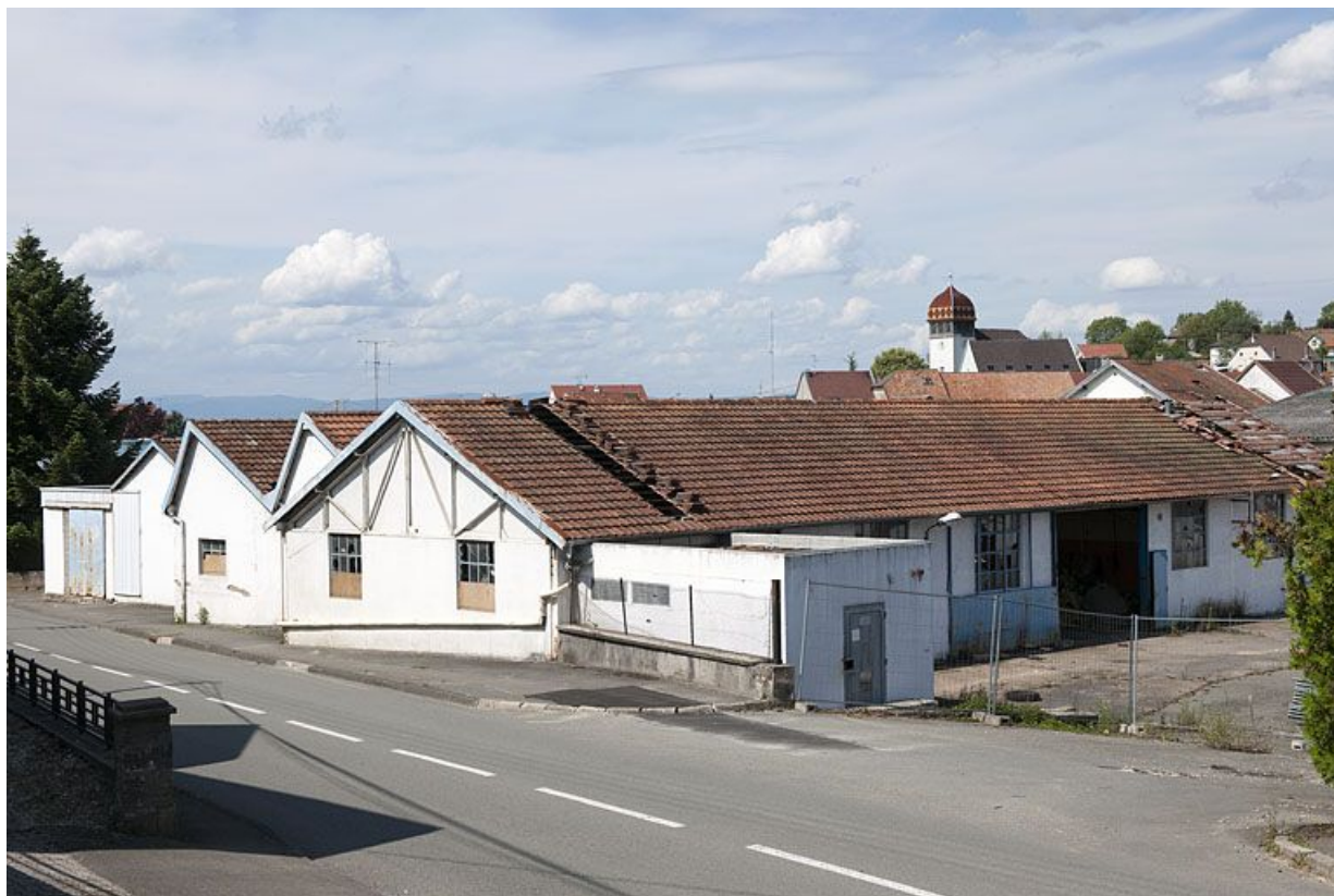
Ateliers de fabrication nord. 25, Étupes, 7 rue Emile Beley
