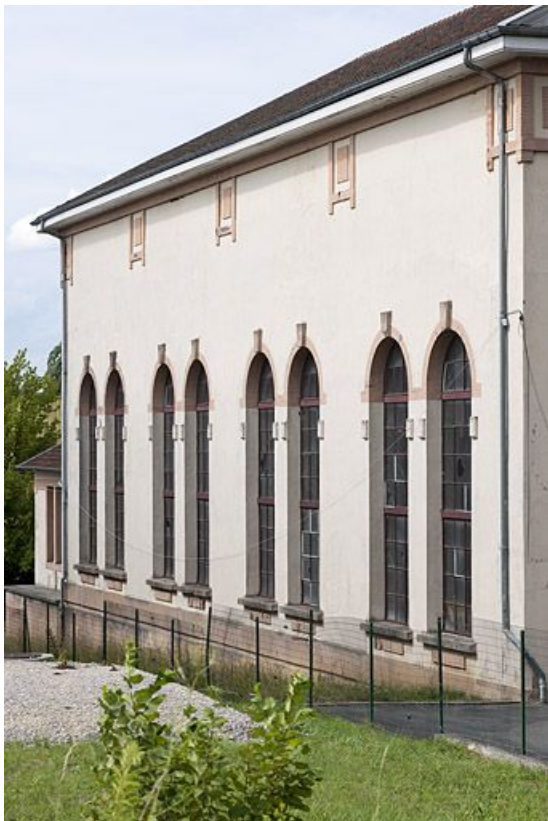
Façade ouest de la salle des machines. 25, Étupes avenue du général de Gaulle
