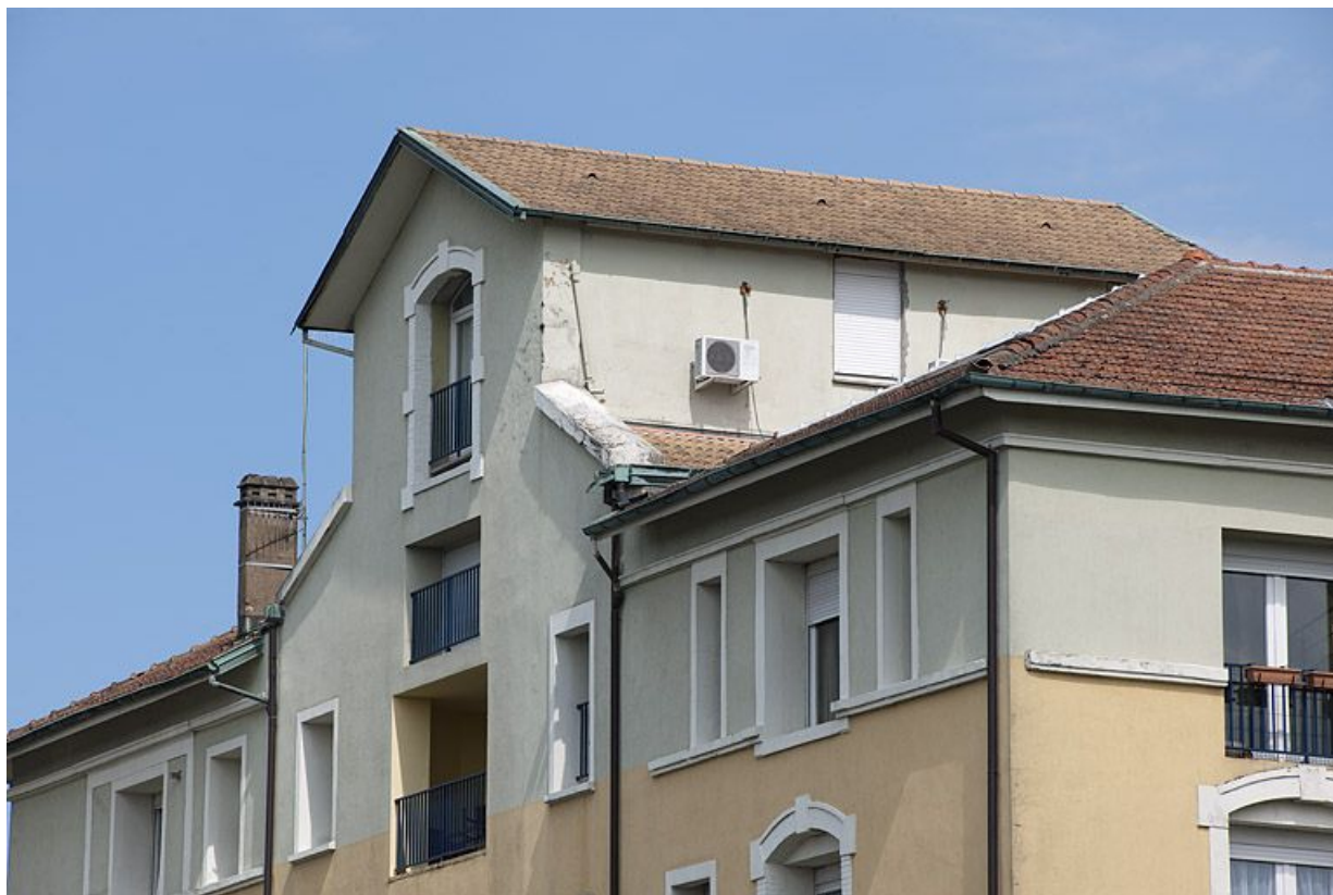
Partie supérieure de la façade postérieure. 25, Étupes avenue du général de Gaulle
