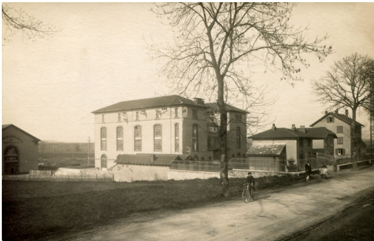
Sous-station électrique du Refrain. Photogr., s.n., s.d. [début du 20e siècle]. 25, Étupes avenue du général de Gaulle
