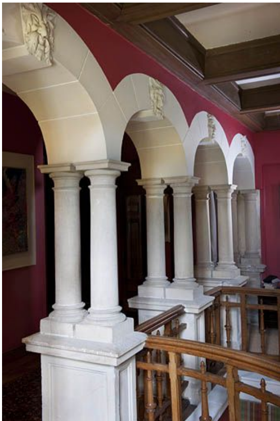
Colonnnettes jumelées au premier étage.
