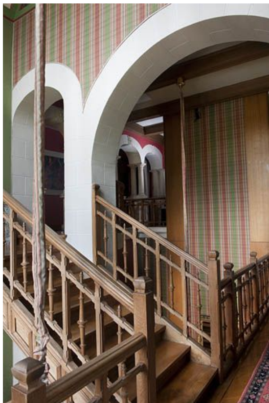
Entresol. Accès au premier étage.
