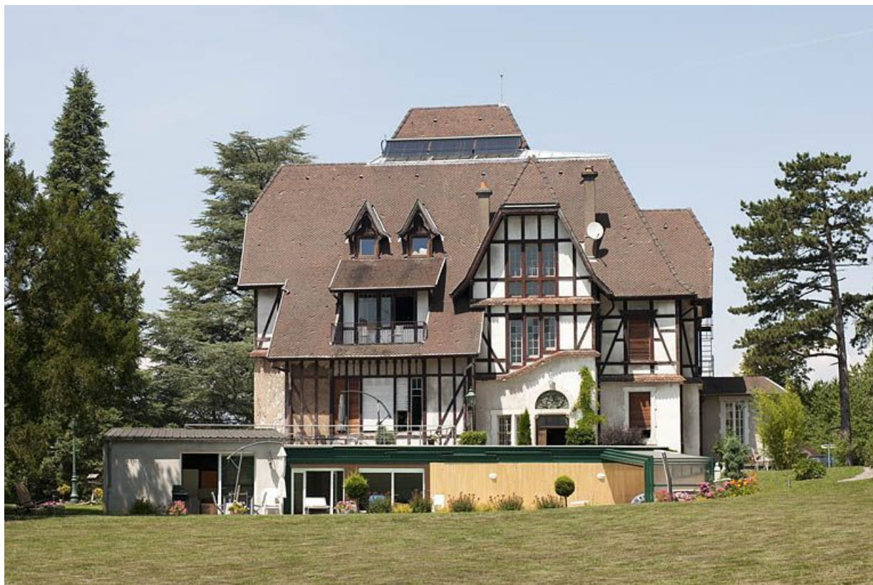
Façade sud depuis le parc. 25, Exincourt rue sur le Mont
