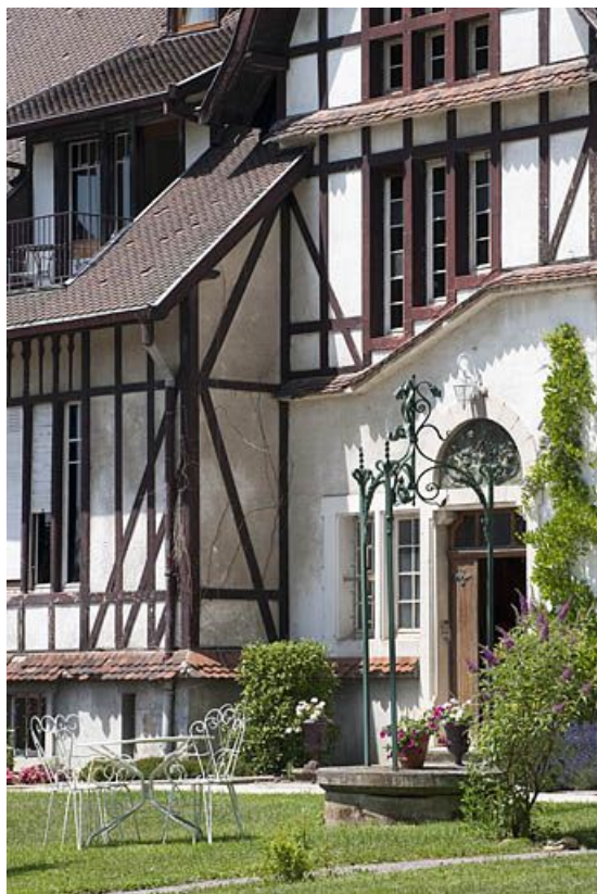
Façade sud vue de trois quarts.
