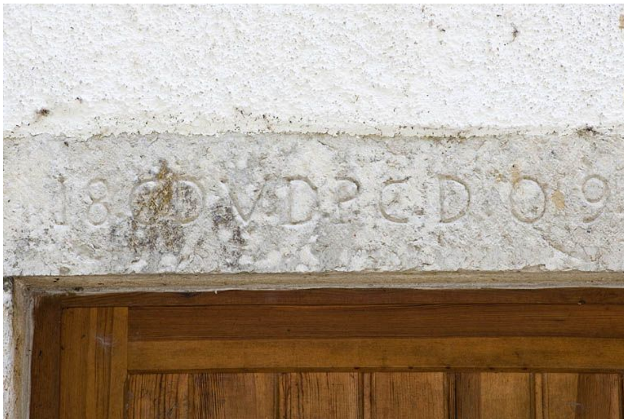
Façade nord du moulin. Linteau gravé.
