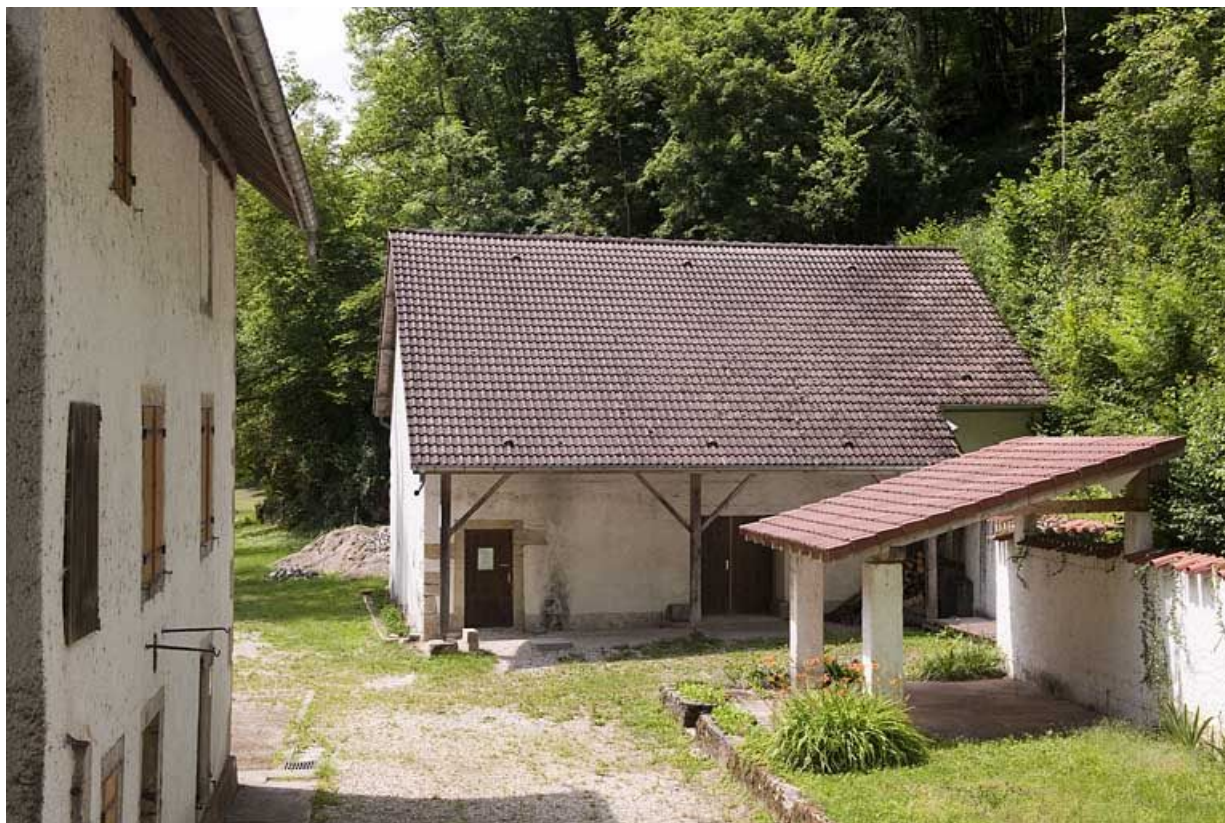
Façade nord du moulin et dépendance agricole.
