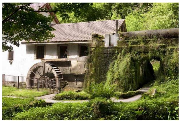
La conduite d'amenée et la roue hydraulique.
