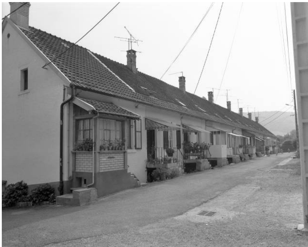
Logement ouvrier. Façade postérieure en 1981.
