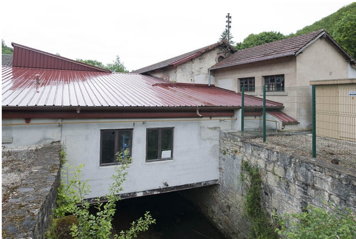
Bâtiment sur l'ancien bief de dérivation.
