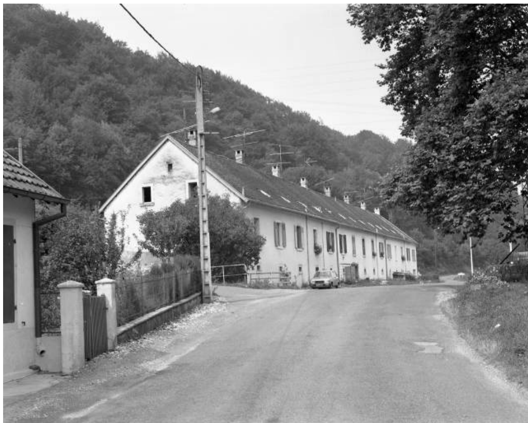
Logement ouvrier. Façade antérieure vue de trois quarts en 1981.
