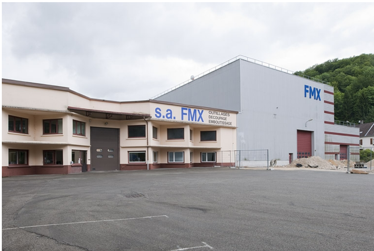
Façade nord des ateliers de fabrication.
