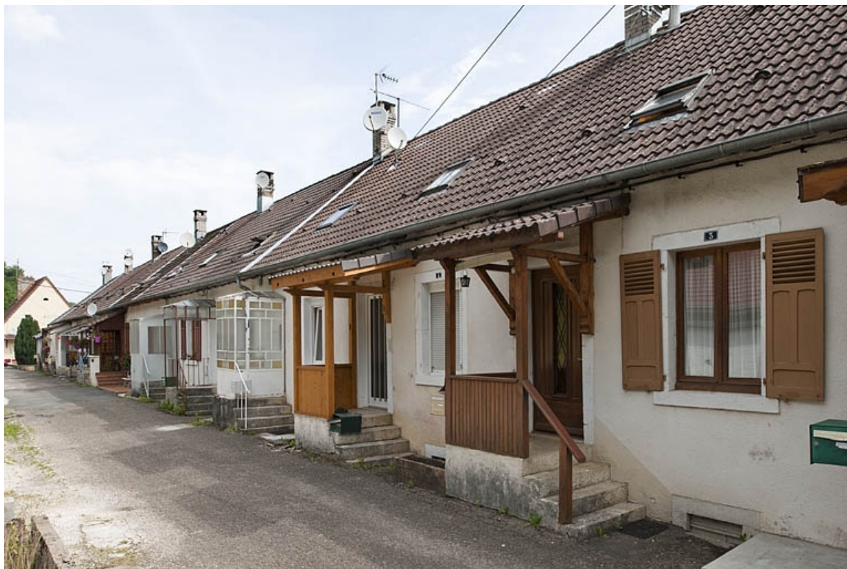
Logement d'ouvriers. Façade antérieure vue de trois quarts droite. 25, Meslières, 44 Grande Rue
