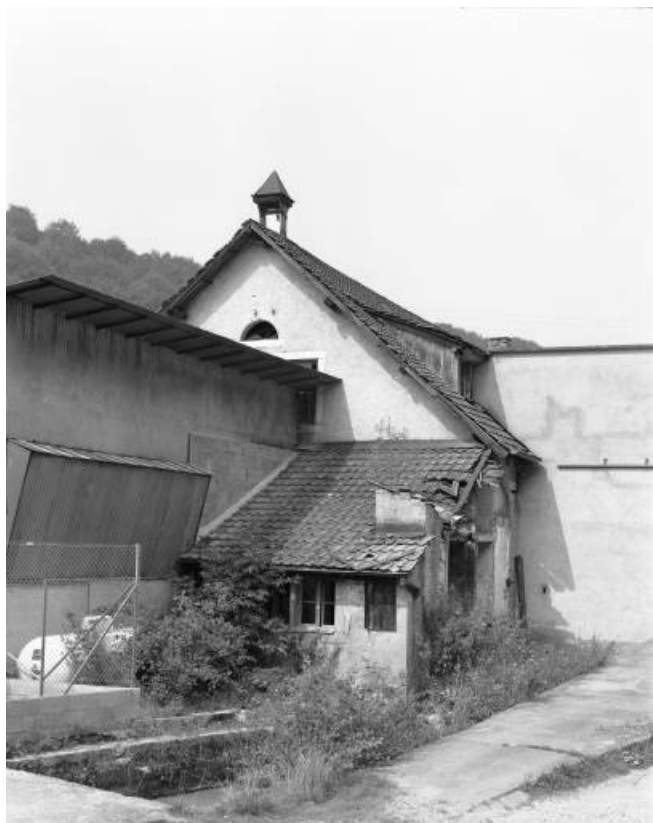
Pignon d'un atelier de fabrication en 1981. 25, Meslières, 44 Grande Rue
