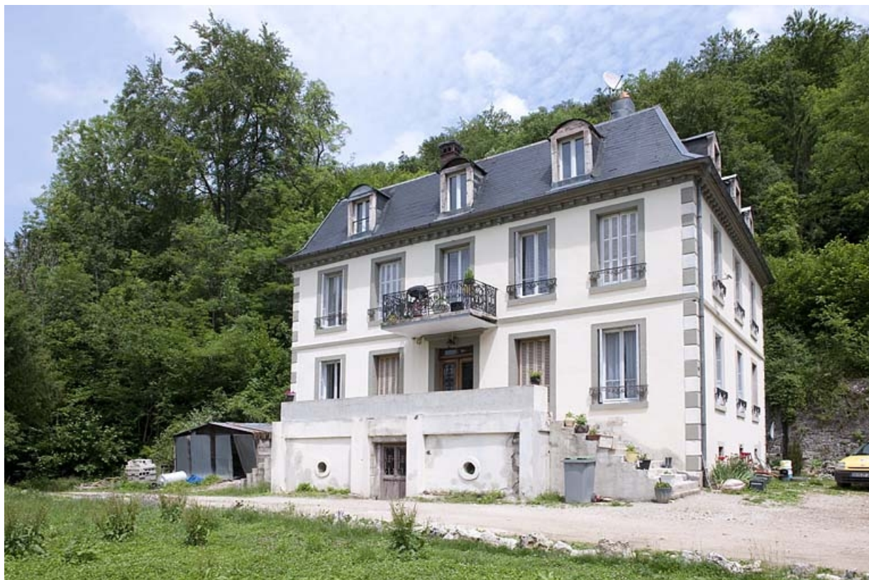
Logement patronal Juillard. 25, Meslières, 44 Grande Rue
