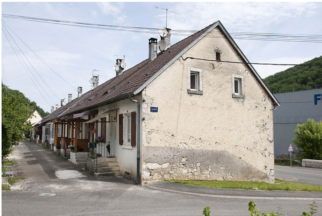
Logement d'ouvriers. Vue de trois quarts.
