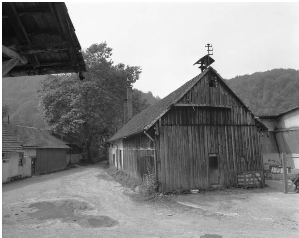
Pignon de l'atelier de menuiserie en 1981.
