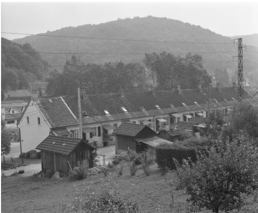
Logement ouvrier. Vue de trois quarts arrière en 1981.
