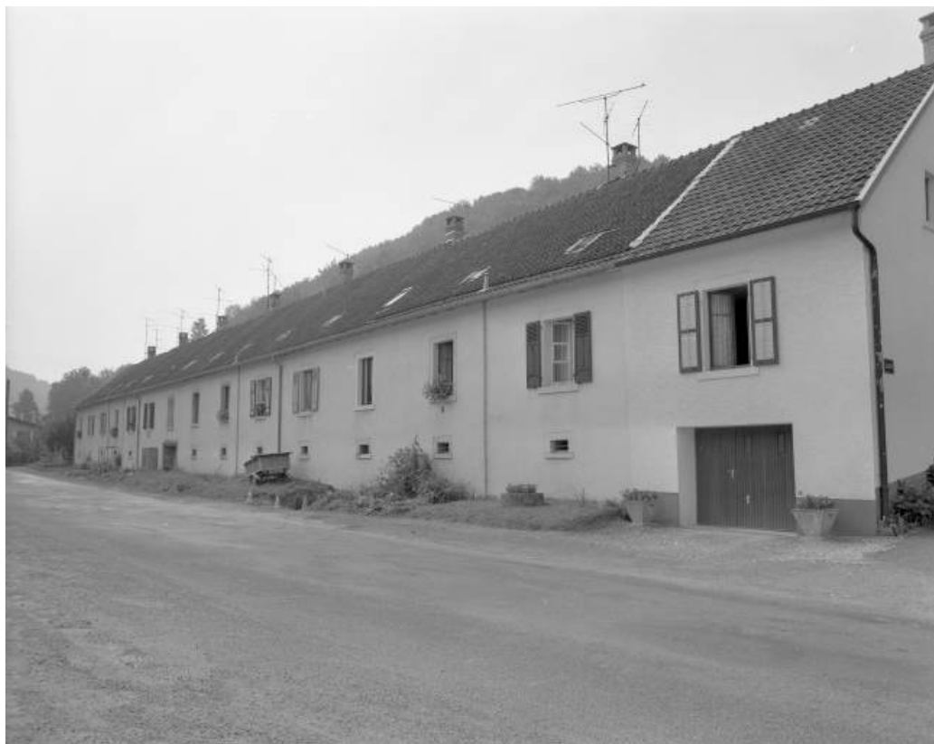
Logement ouvrier. Détail de la façade antérieure en 1981.
