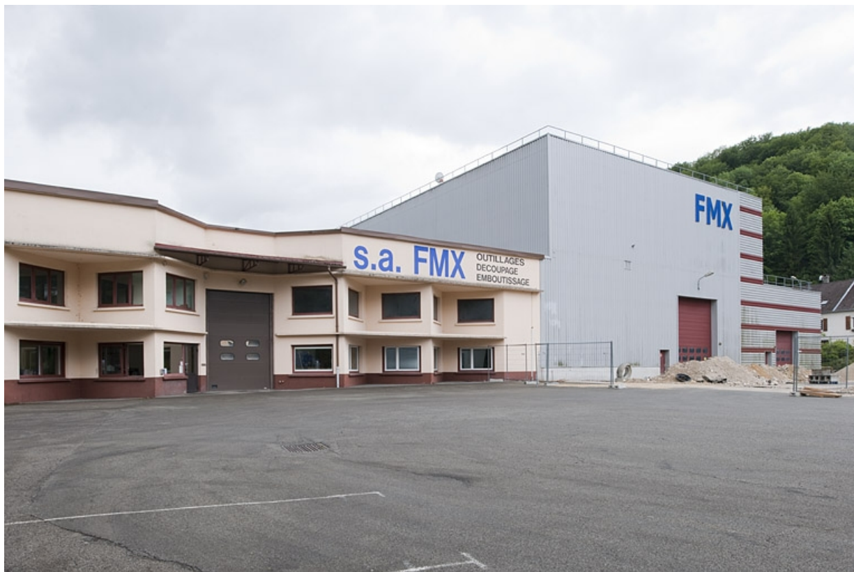
Façade nord des ateliers de fabrication.
