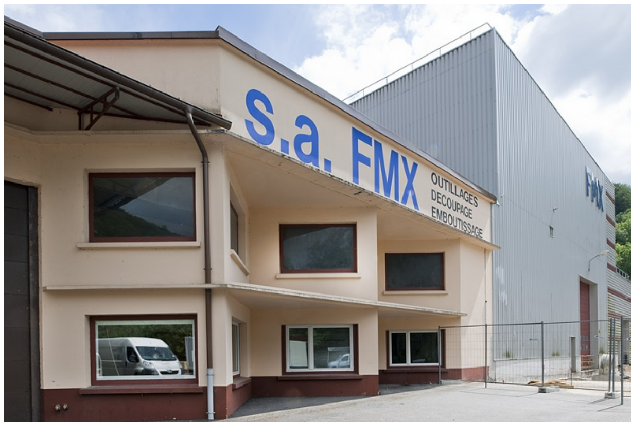
Façade nord : le nouvel atelier des presses. 25, Meslières, 44 Grande Rue
