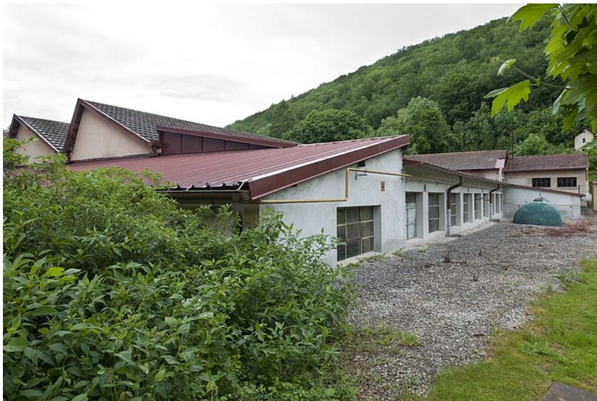
Façade postérieure de l'atelier de fabrication. 25, Meslières, 44 Grande Rue
