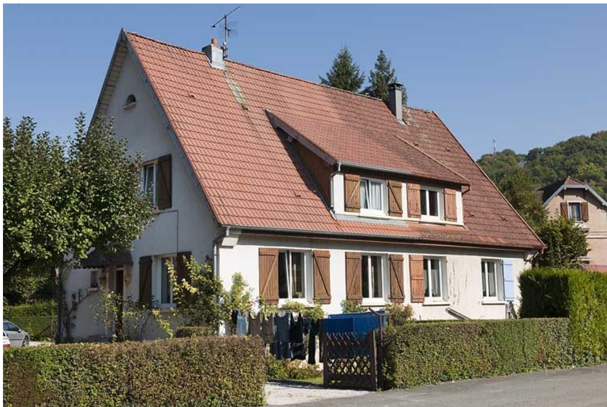
Maison jumelée. Vue de trois quarts gauche. 25, Hérimoncourt, 4 à 14 rue des Tilleuls
