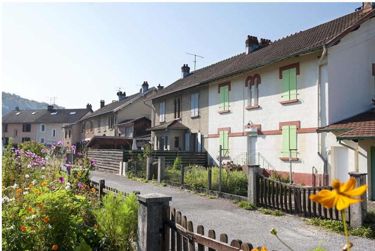
Vue d'ensemble depuis le nord-ouest. 25, Hérimoncourt, 1 à 15 rue du Centre
