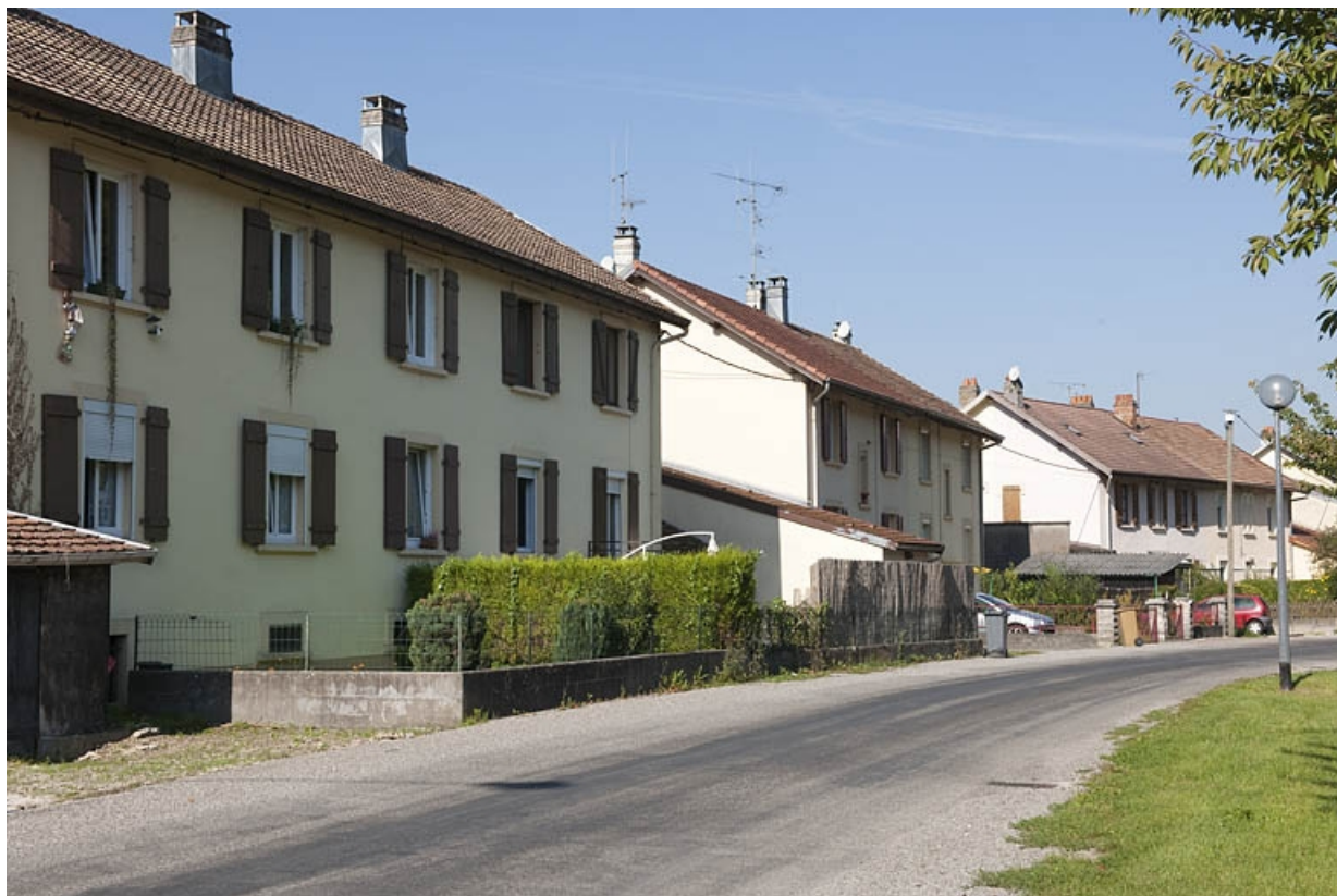
Vue d'ensemble depuis la rue du canal.
