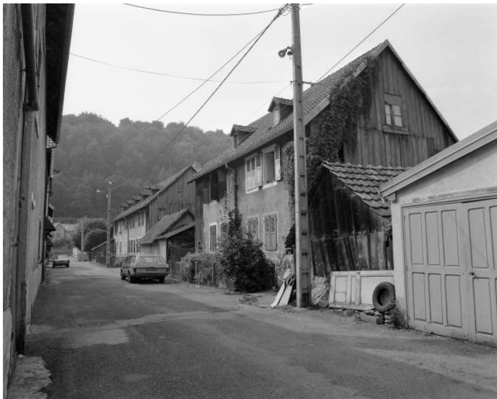
Logements ouvriers rue du Préau en 1981, aujourd'hui détruits.
