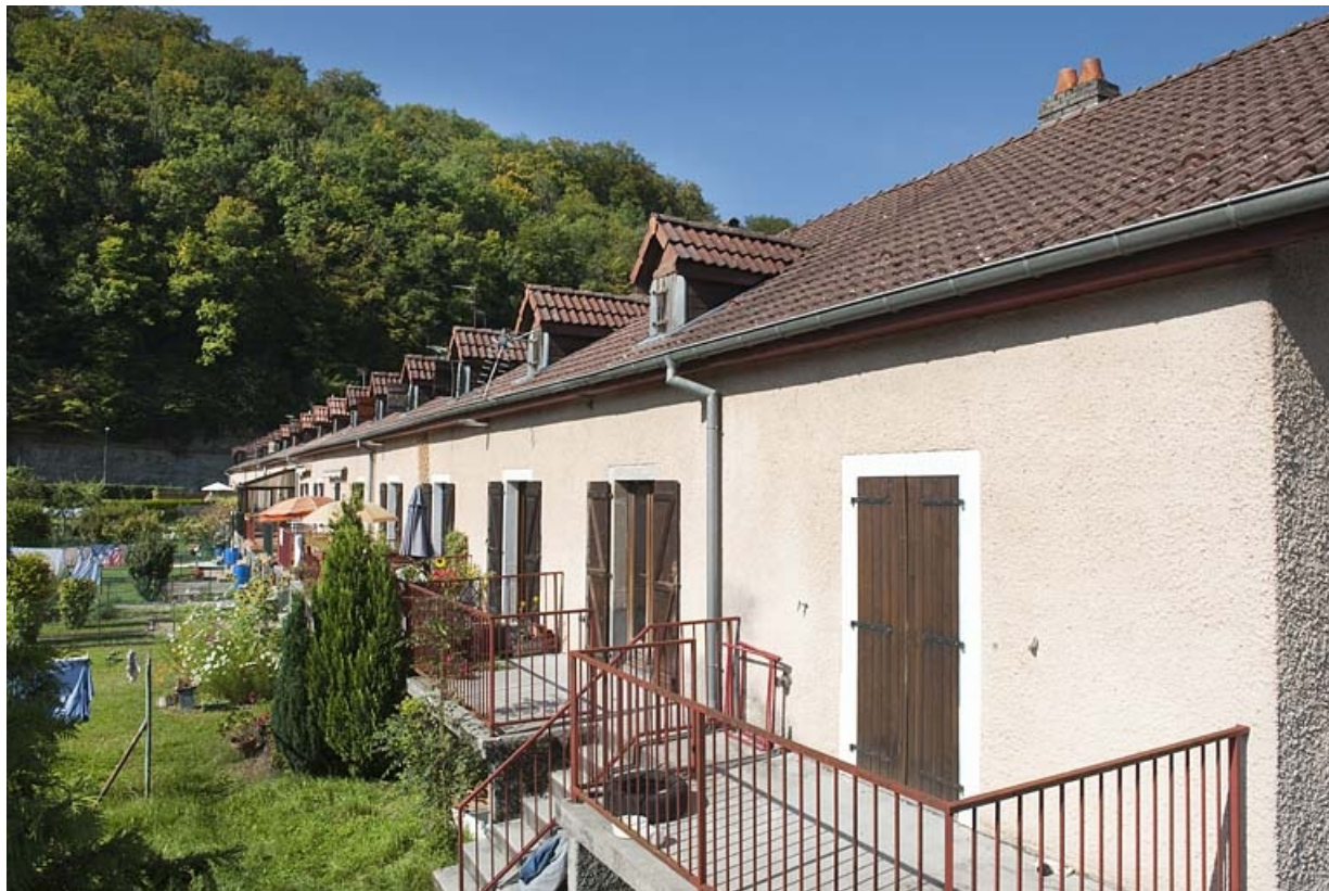
Caserne F. Vue rapprochée de la façade postérieure.
