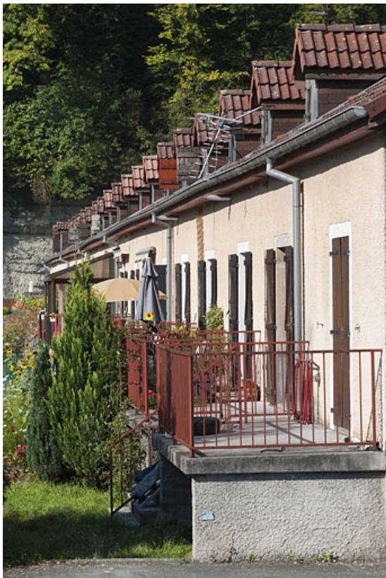
Caserne F. Façade postérieure vue de trois quarts. 25, Hérimoncourt rue Adèle Prud'hon
