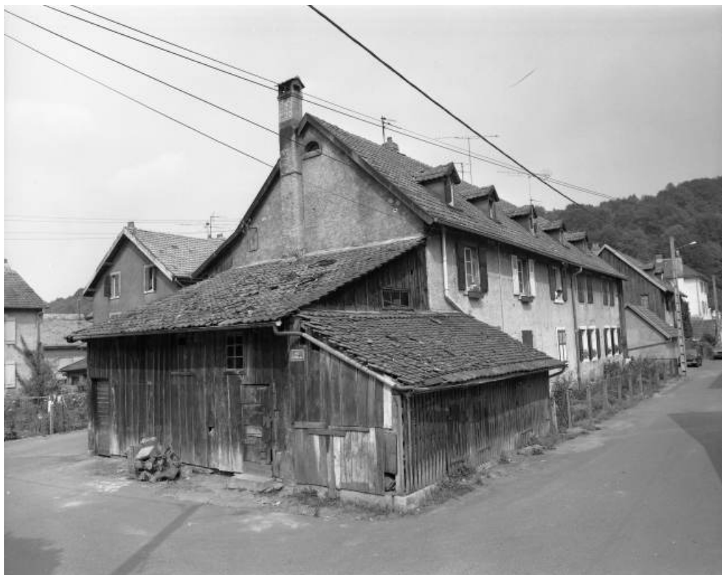
Caserne (15 logements) 4 rue de la Promenade en 1981, aujourd'hui détruite. 25, Hérimoncourt rue Adèle Prud'hon
