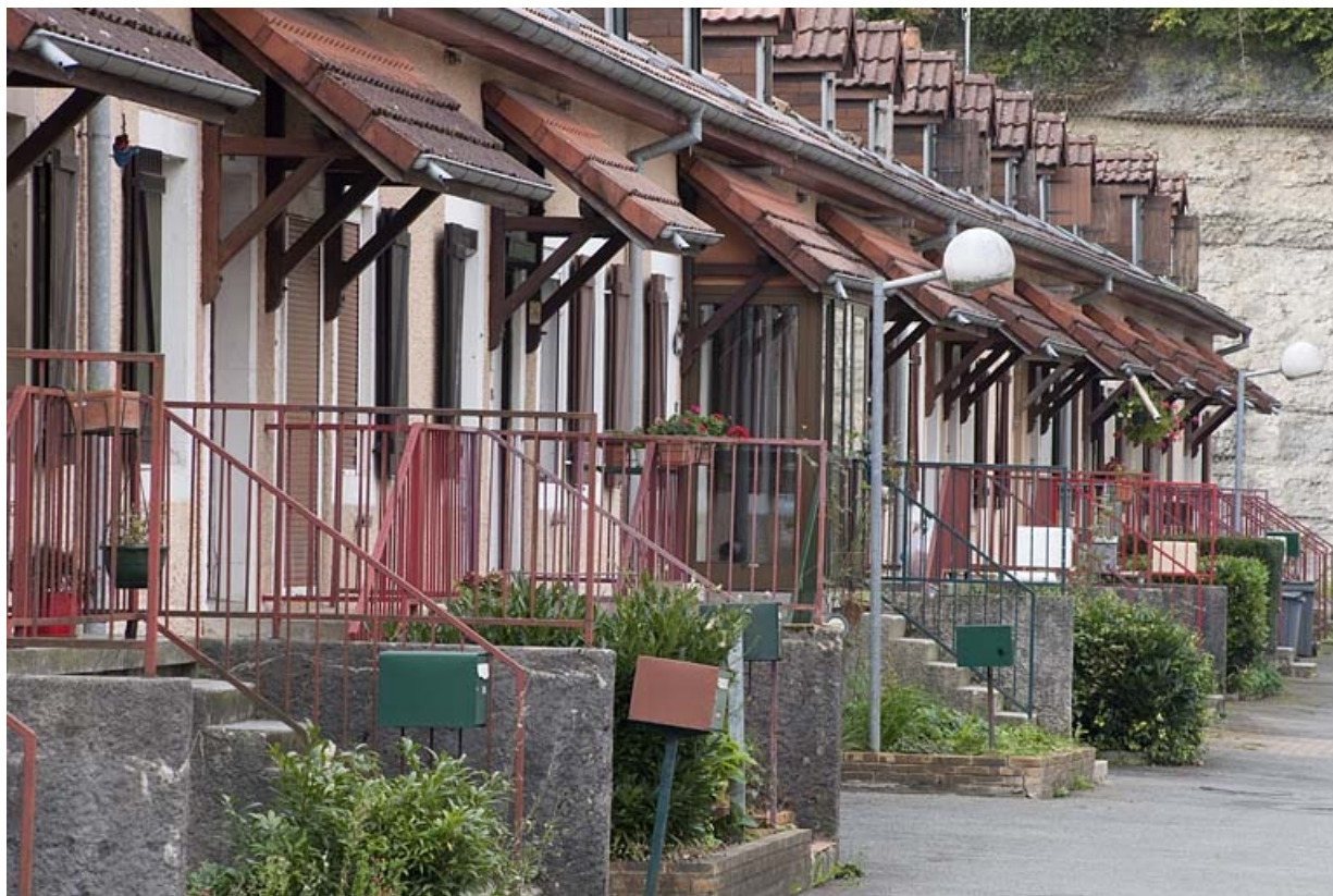
Caserne F. Vue rapprochée de la façade antérieure depuis le nord-est. 25, Hérimoncourt rue Adèle Prud'hon
