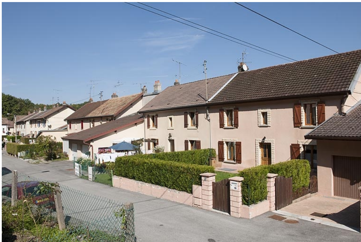
Vue d'ensemble rue de la Promenade.
