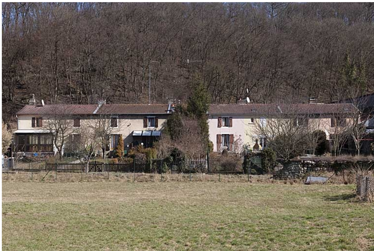
Logement sud (caserne B) depuis l'ouest. 25, Morteau, 2 rue du Docteur Léon Sauze
