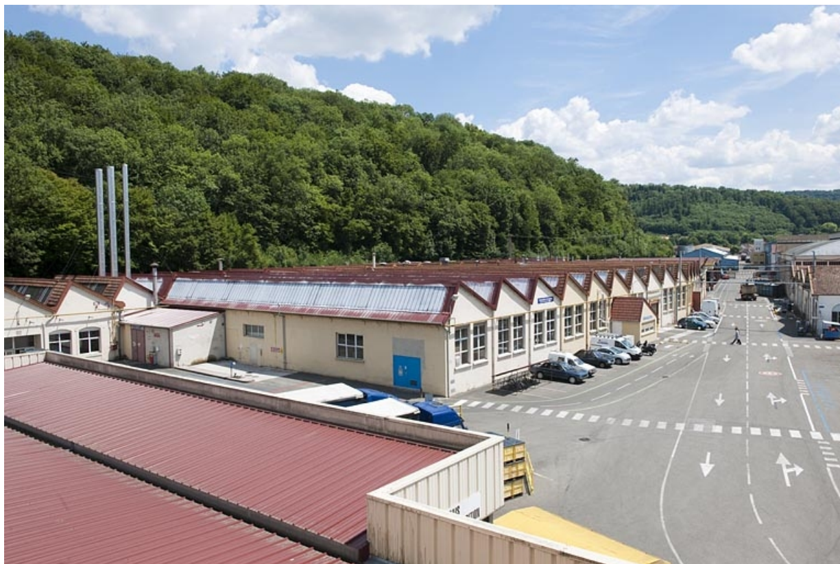
Vue plongeante sur l'atelier de rénovation des moteurs.
