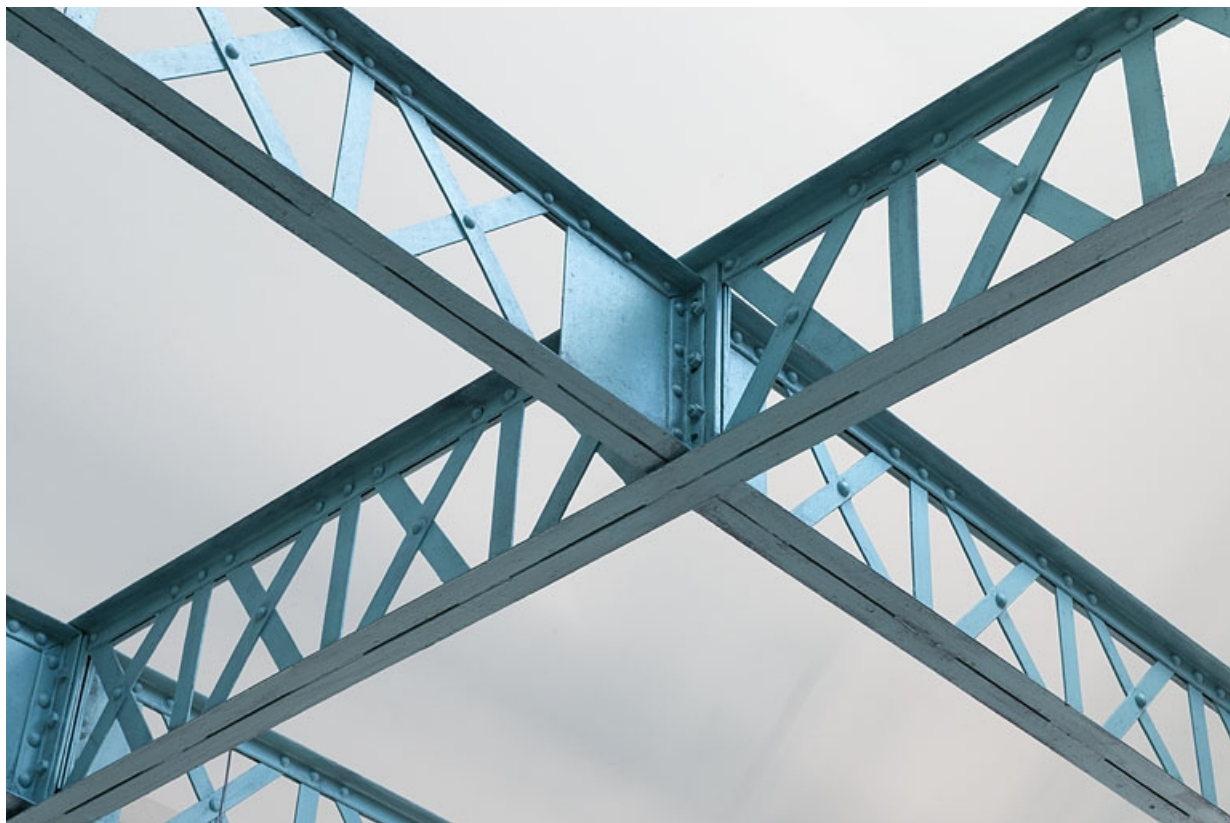
Centre d'archives. Poutrelles à treillis de la charpente.
