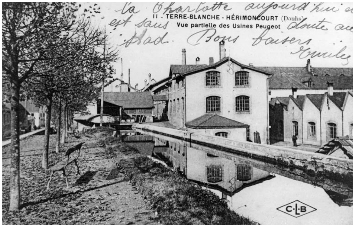
Terre-Blanche - Hérimoncourt (Doubs). Vue partielle des Usines Peugeot.
