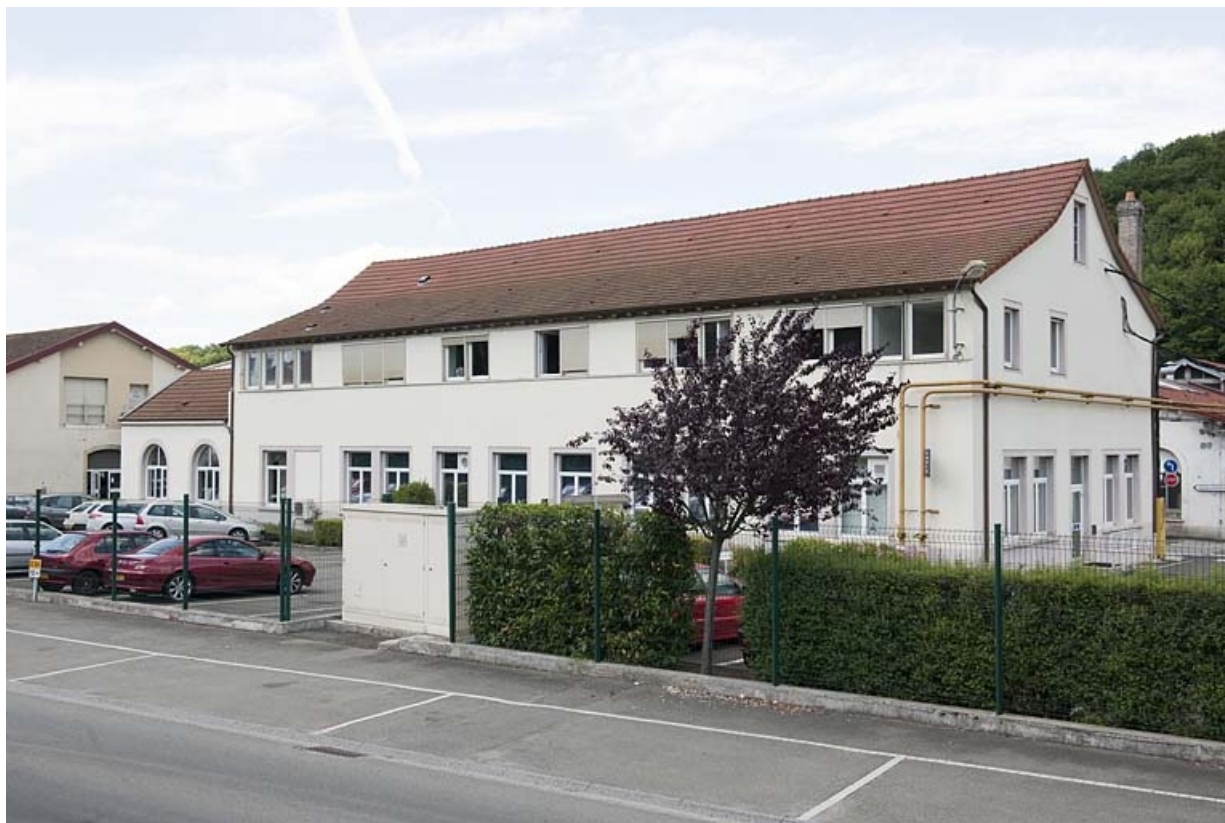
Façade ouest du bureau d'études.
