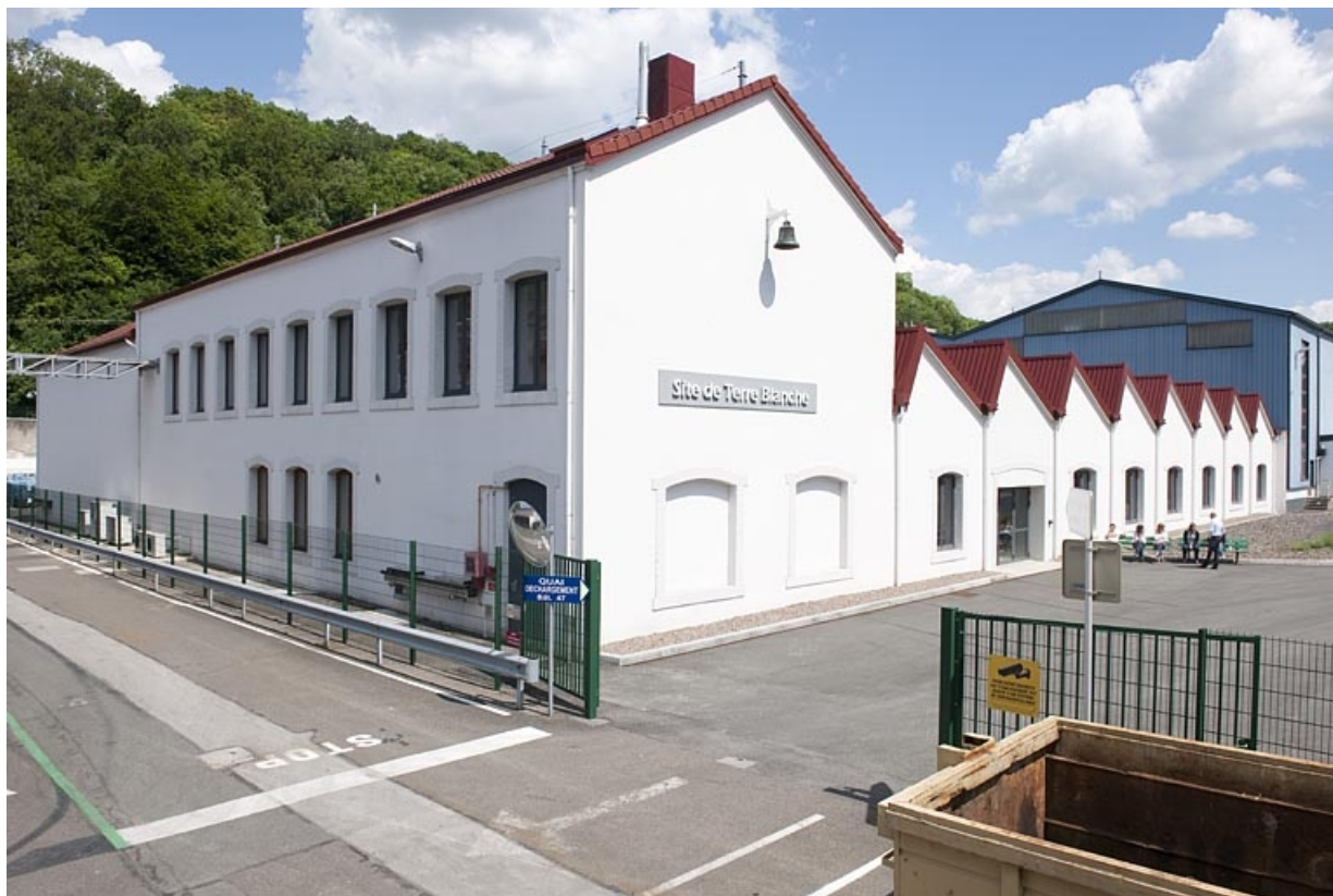
Bâtiment de bureaux (?) et centre d'archives. 25, Hérimoncourt, 34 rue du Commandant Rolland
