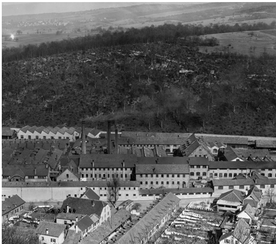
Vue plongeante partielle depuis l'ouest.
