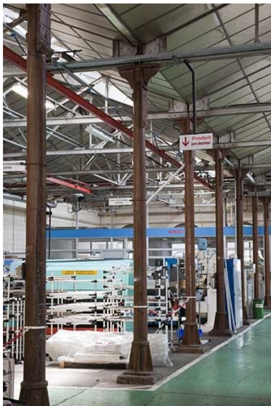
Atelier de fabrication (aujourd'hui de maintenance). 25, Hérimoncourt, 34 rue du Commandant Rolland
