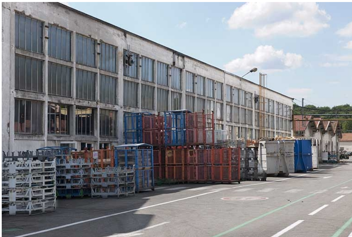
Atelier de fabrication (actuellement magasin industriel). Façade est. 25, Hérimoncourt, 34 rue du Commandant Rolland
