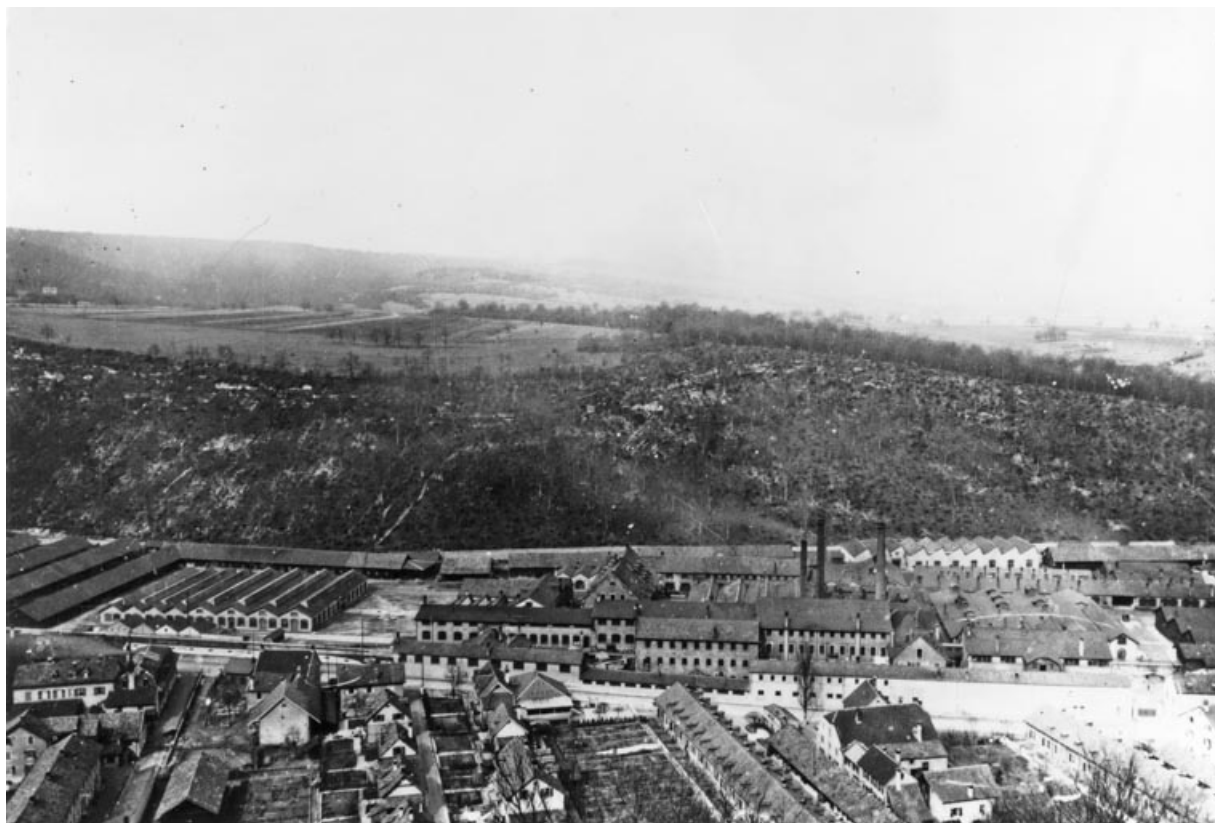
Vue aérienne depuis l'ouest.
