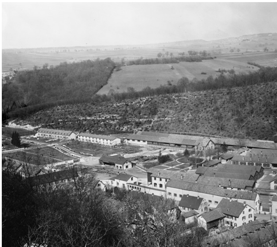
Extrémité nord de l'usine.
