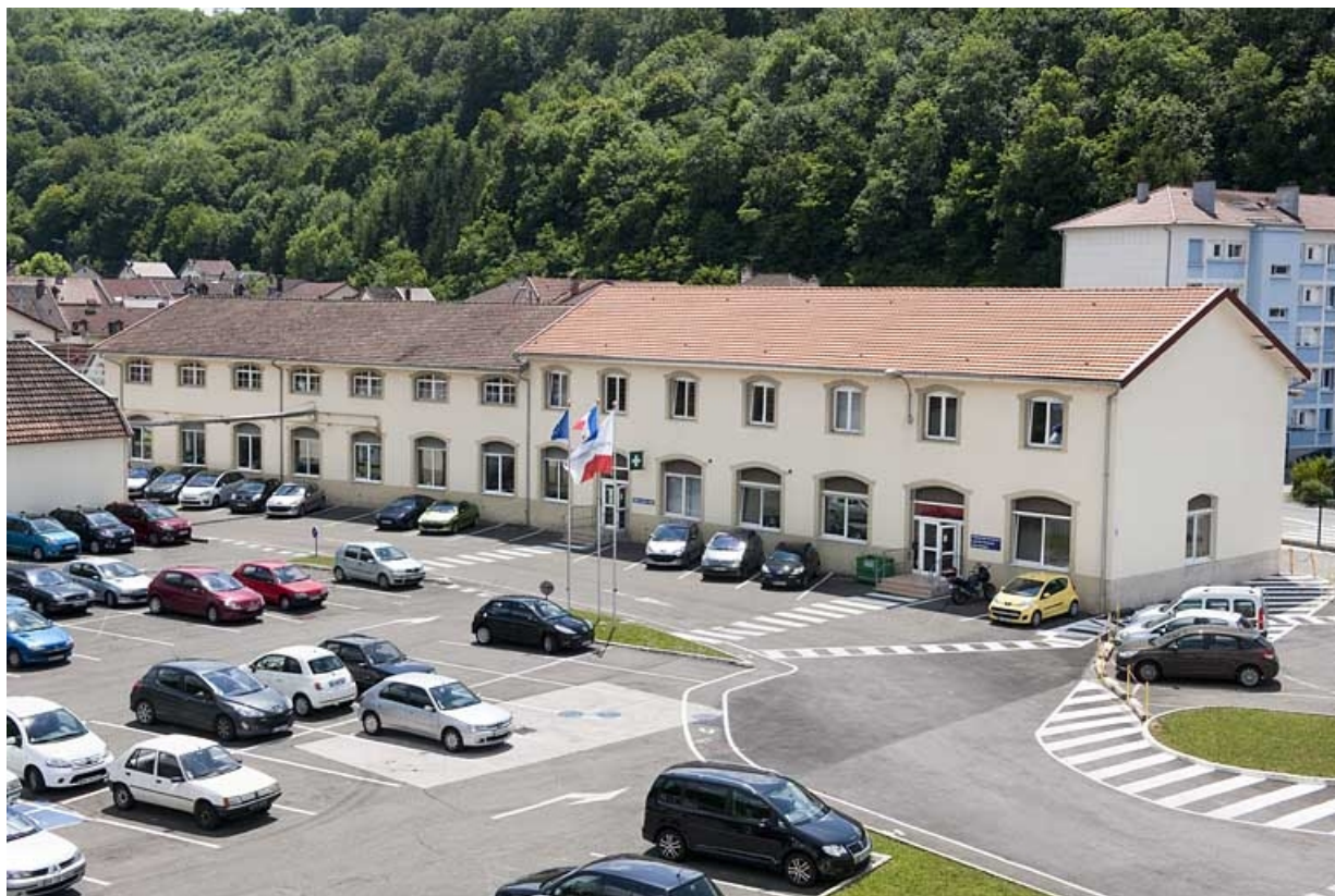
Bâtiment des bureaux depuis le nord-est.
