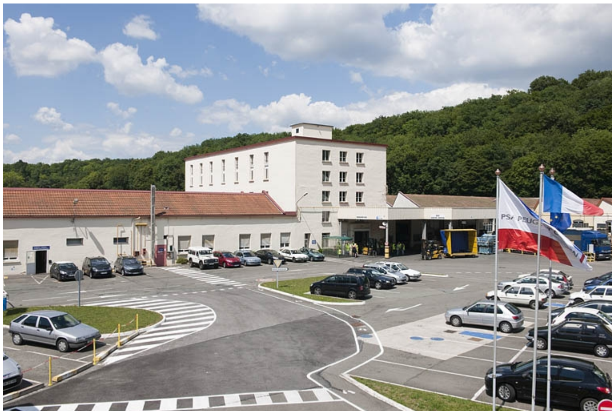
Atelier de rénovation boîtes de vitesse et entrepôt industriel.
