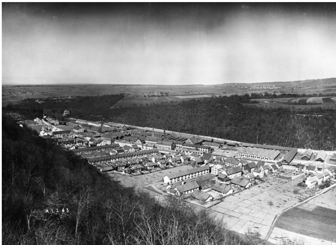
Vue générale depuis le sud.
