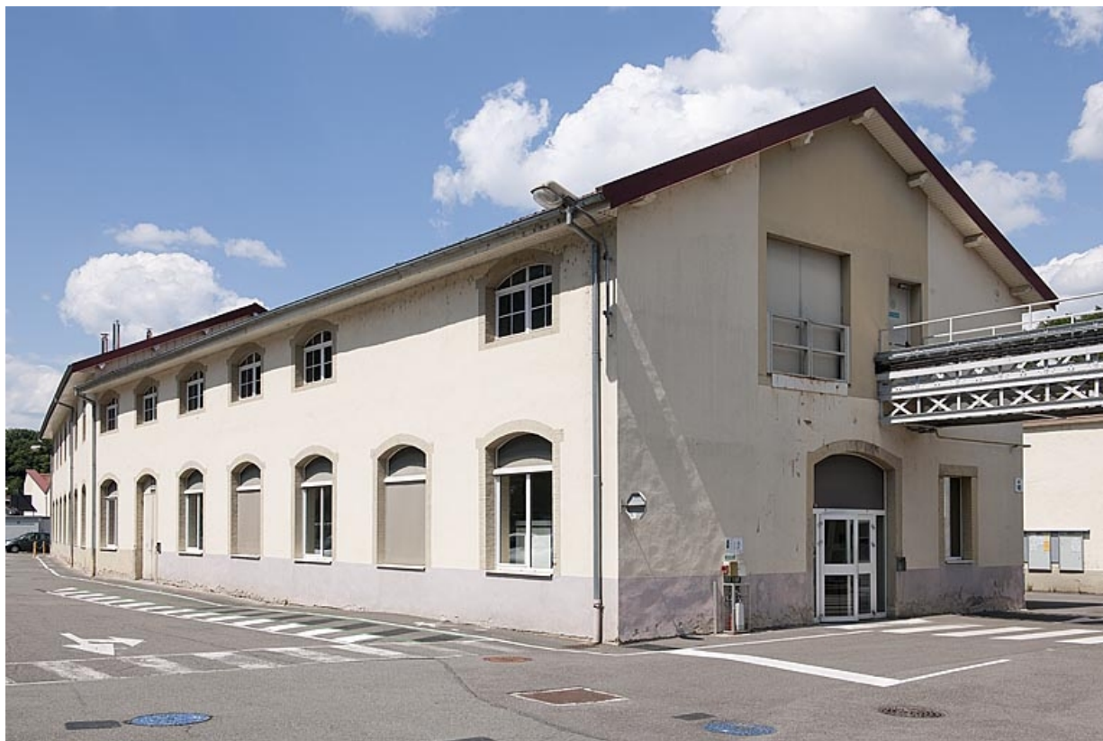
Bâtiment des bureaux vu de trois quarts arrière. 25, Hérimoncourt, 34 rue du Commandant Rolland
