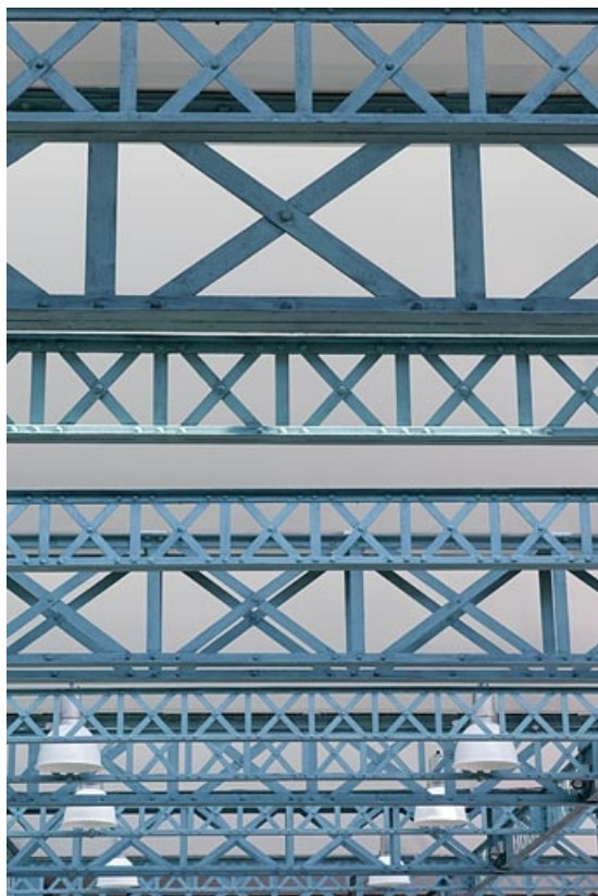
Centre d'archives. Détail des poutrelles de la charpente.
