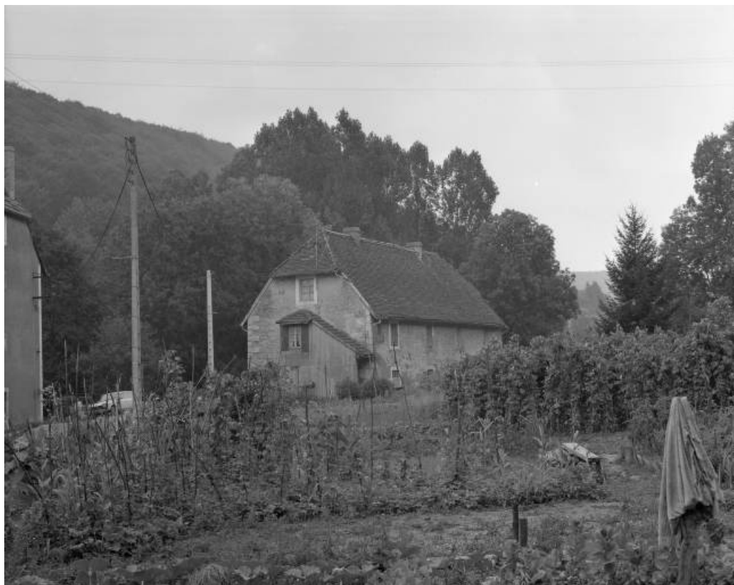
Logement ouvrier depuis le nord en 1981.
