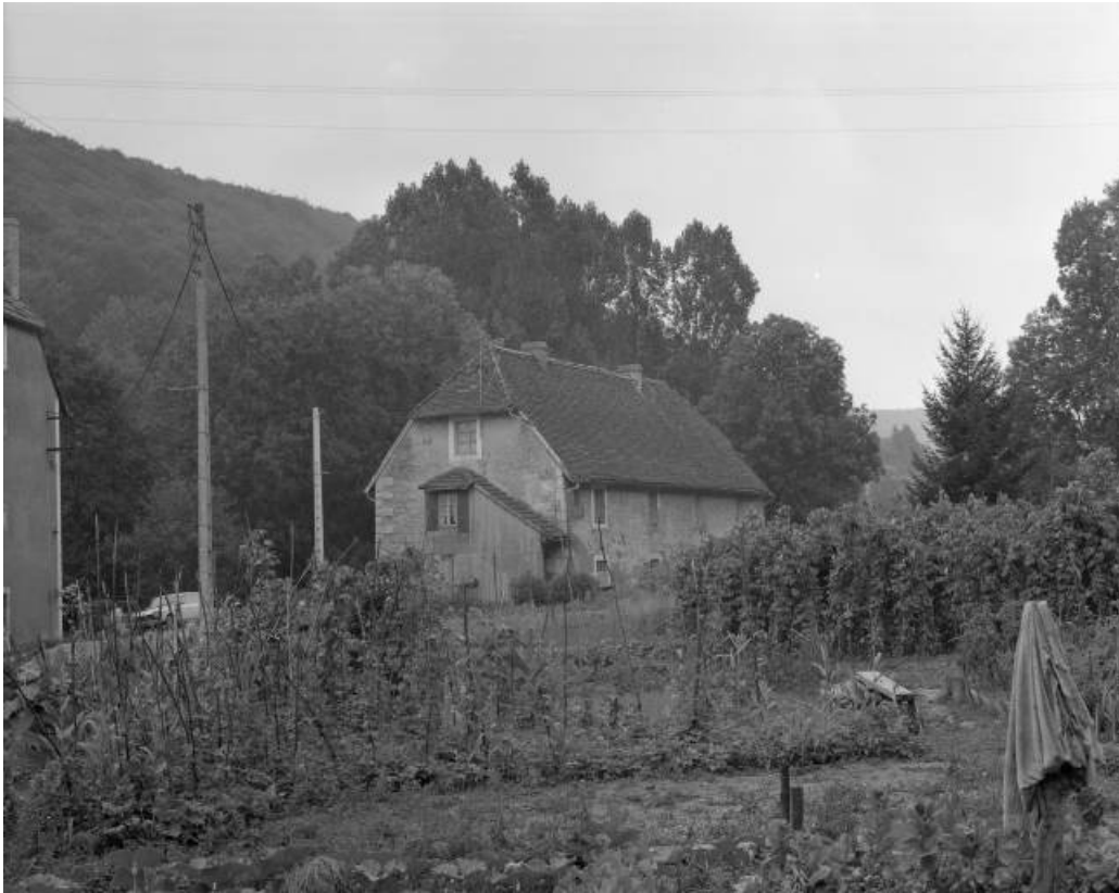
Logement ouvrier depuis le nord en 1981.
