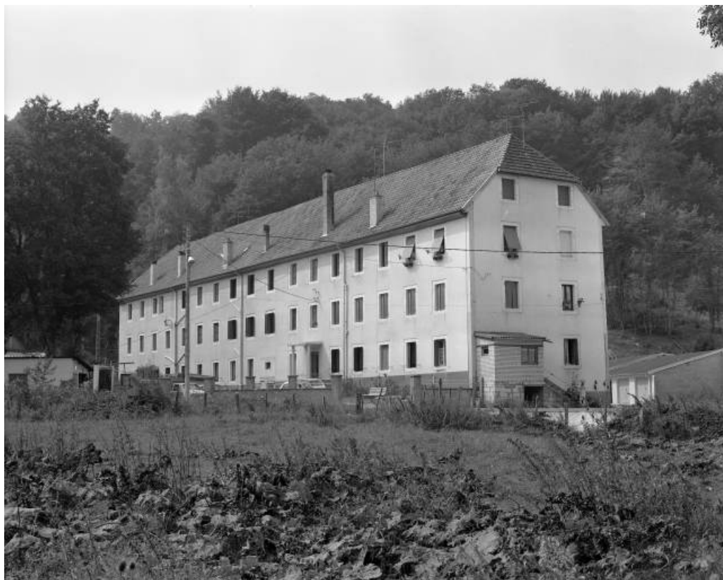
Vue d'ensemble depuis le sud-est en 1981.
