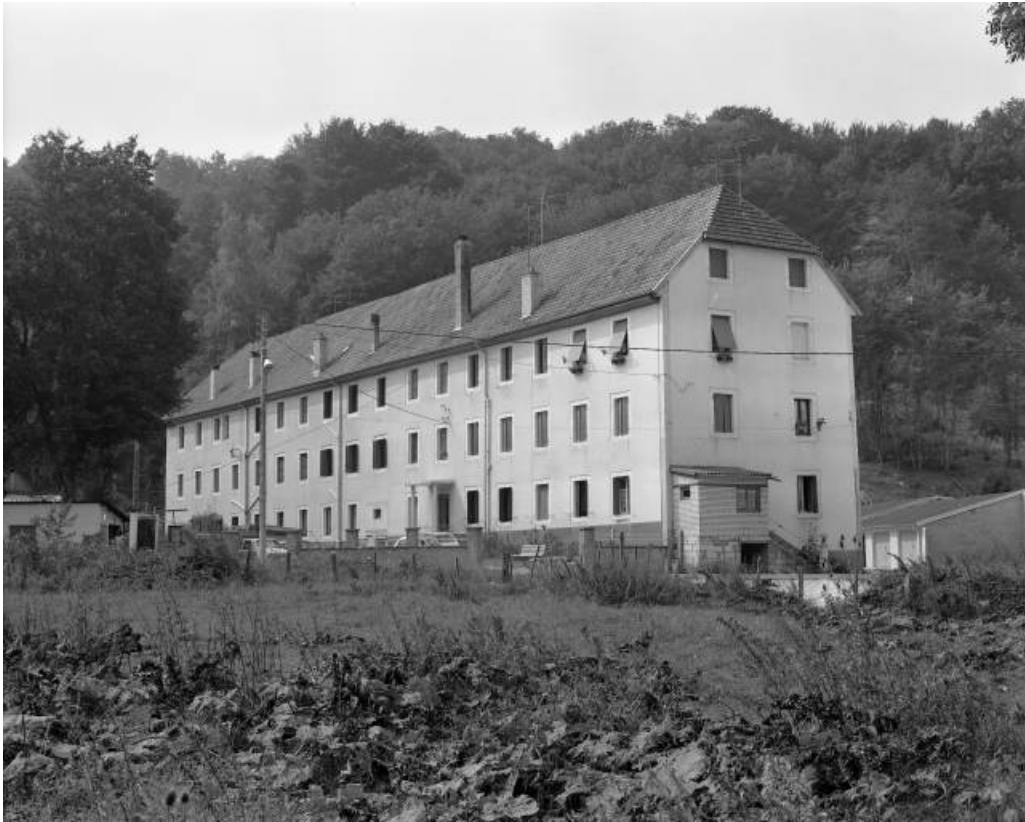
Vue d'ensemble depuis le sud-est en 1981.
