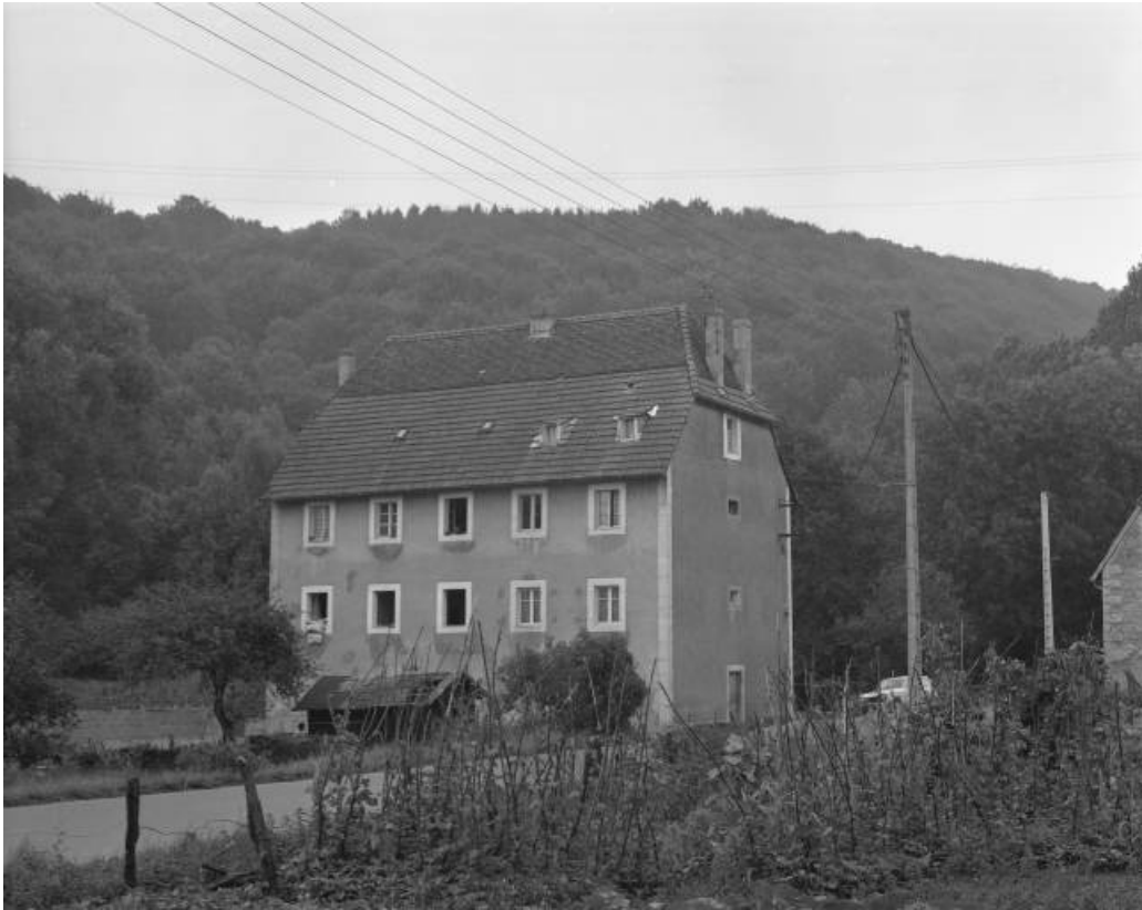
Logement ouvrier vu de trois quarts en 1981.
