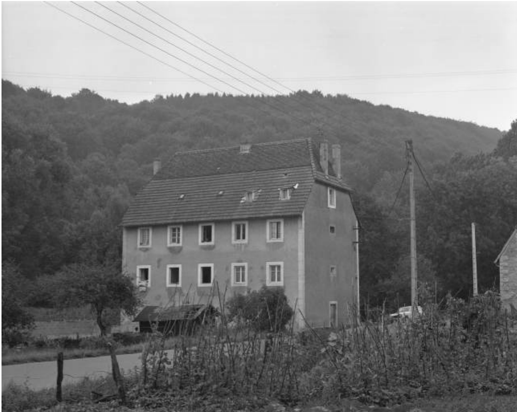
Logement ouvrier vu de trois quarts en 1981.
