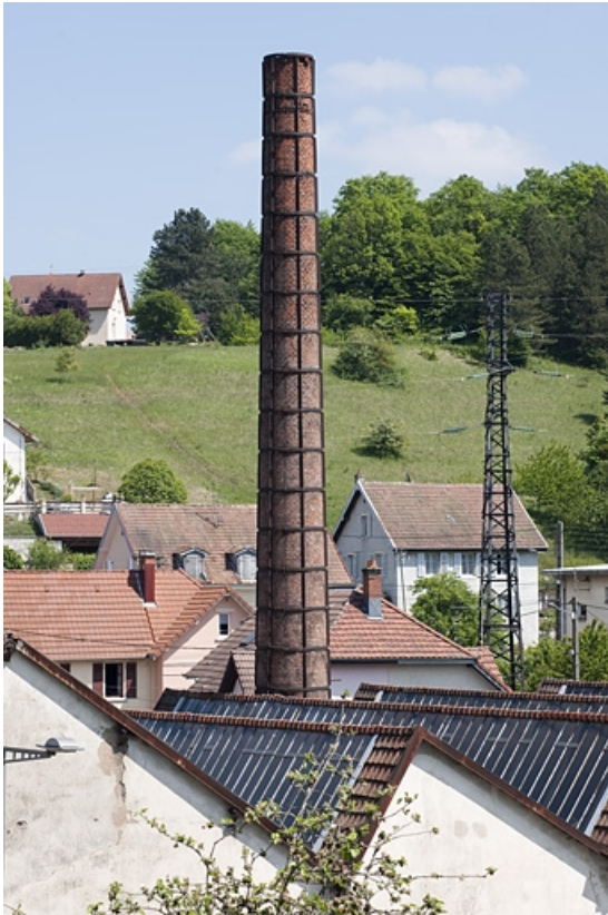
Sheds et cheminée de l'atelier de laitonnerie.
