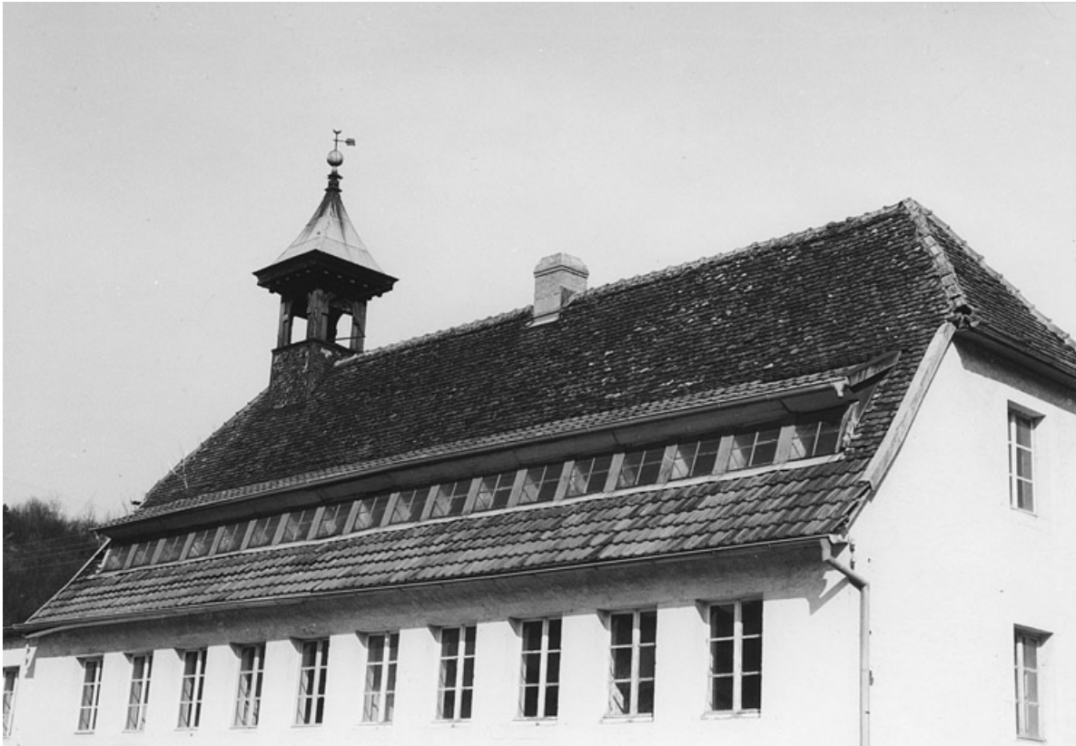
Toiture de l'atelier de fabrication est en 1980.
