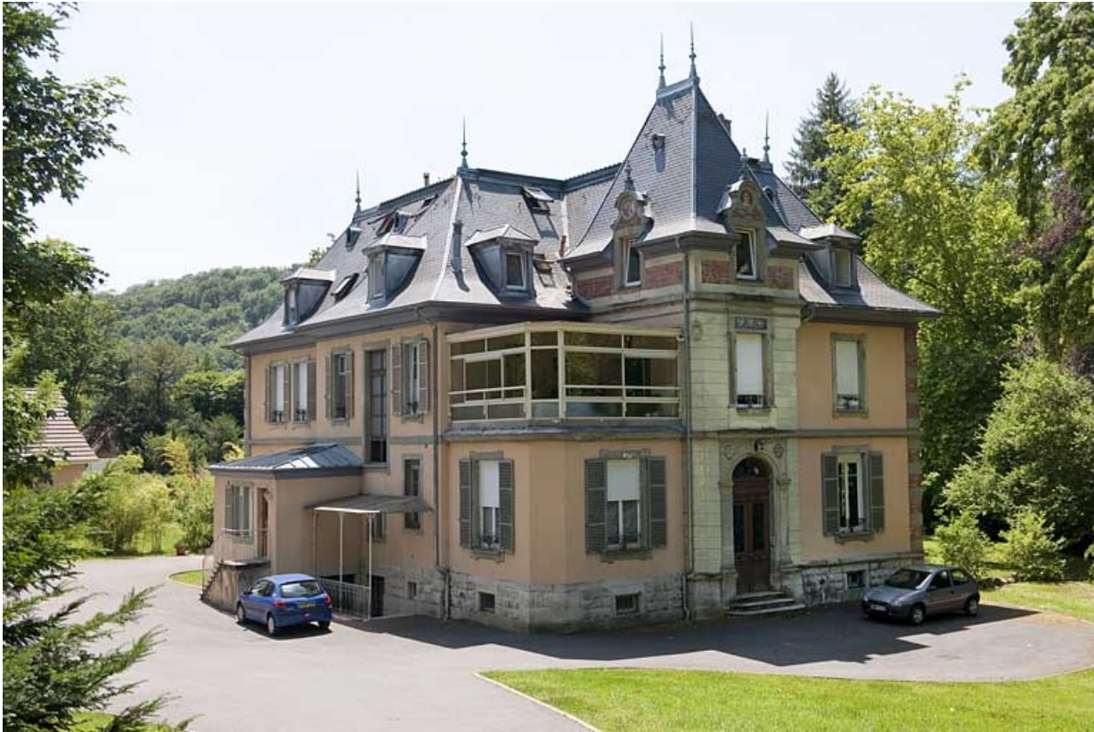
Logement patronal Paul Japy. Vue depuis le nord-est.
