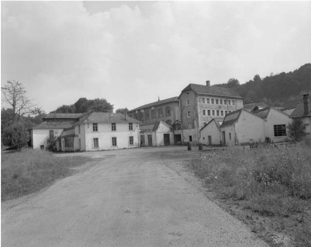
Vue de trois quarts arrière des ateliers en 1981.
