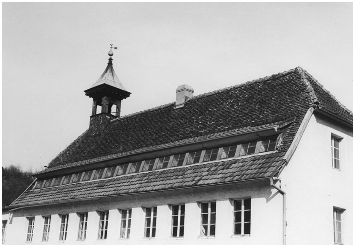
Toiture de l'atelier de fabrication est en 1980.
