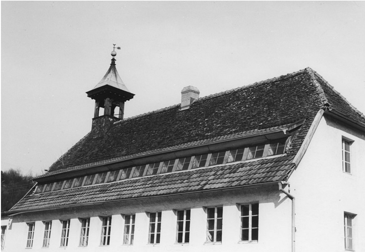
Toiture de l'atelier de fabrication est en 1980.
