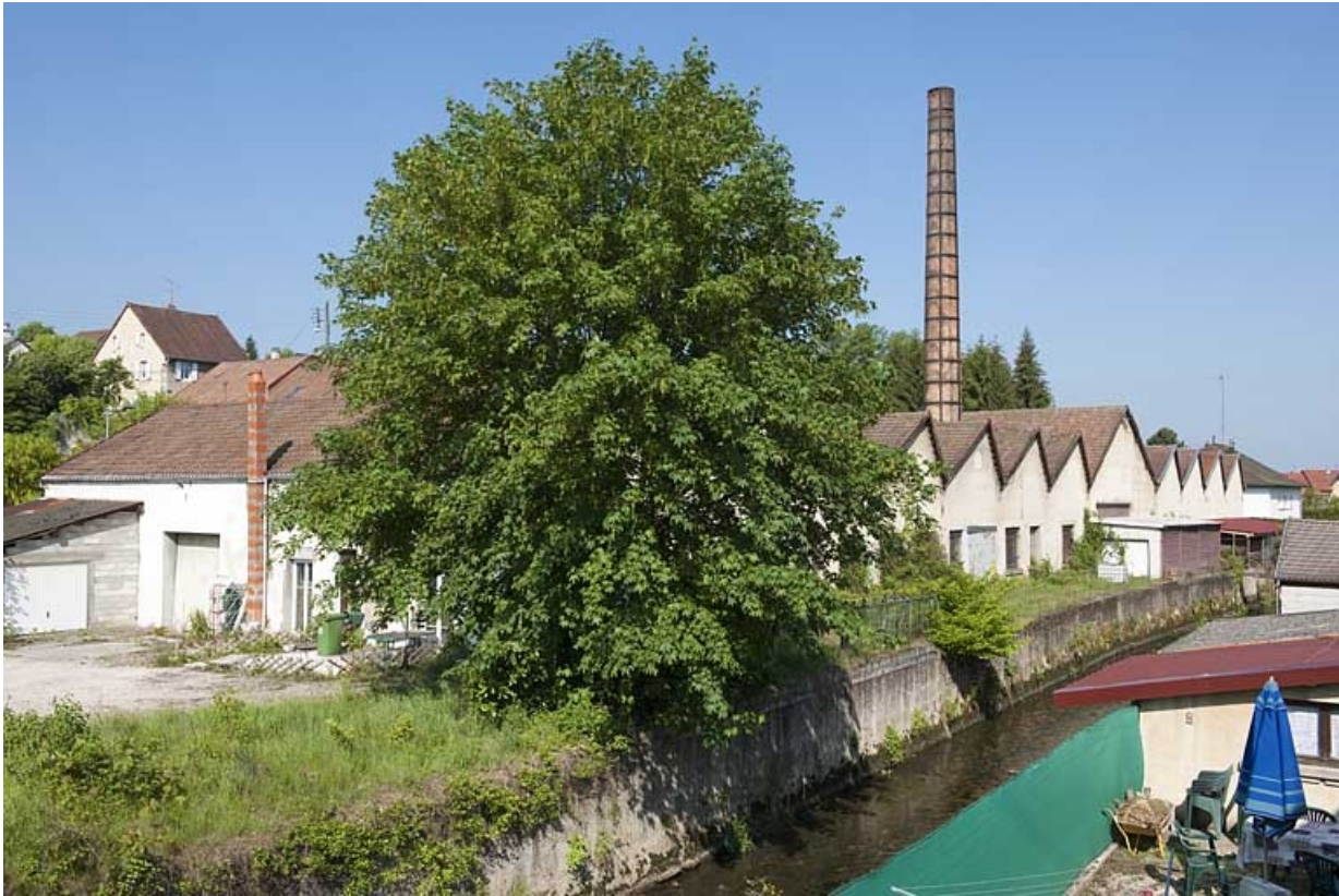
Atelier de laitonnerie. Vue depuis le sud-est.
