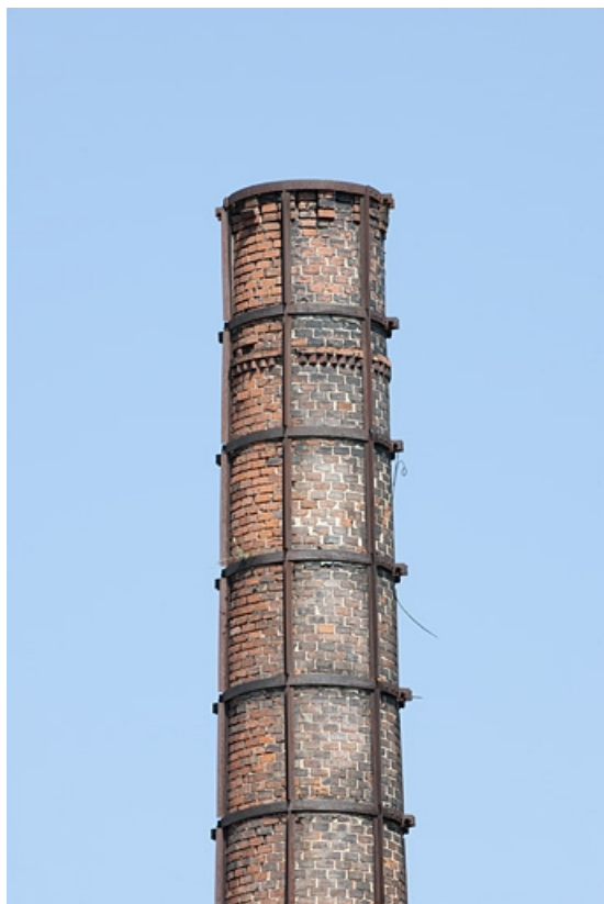
Atelier de laitonnerie. Partie supérieure de la cheminée.
