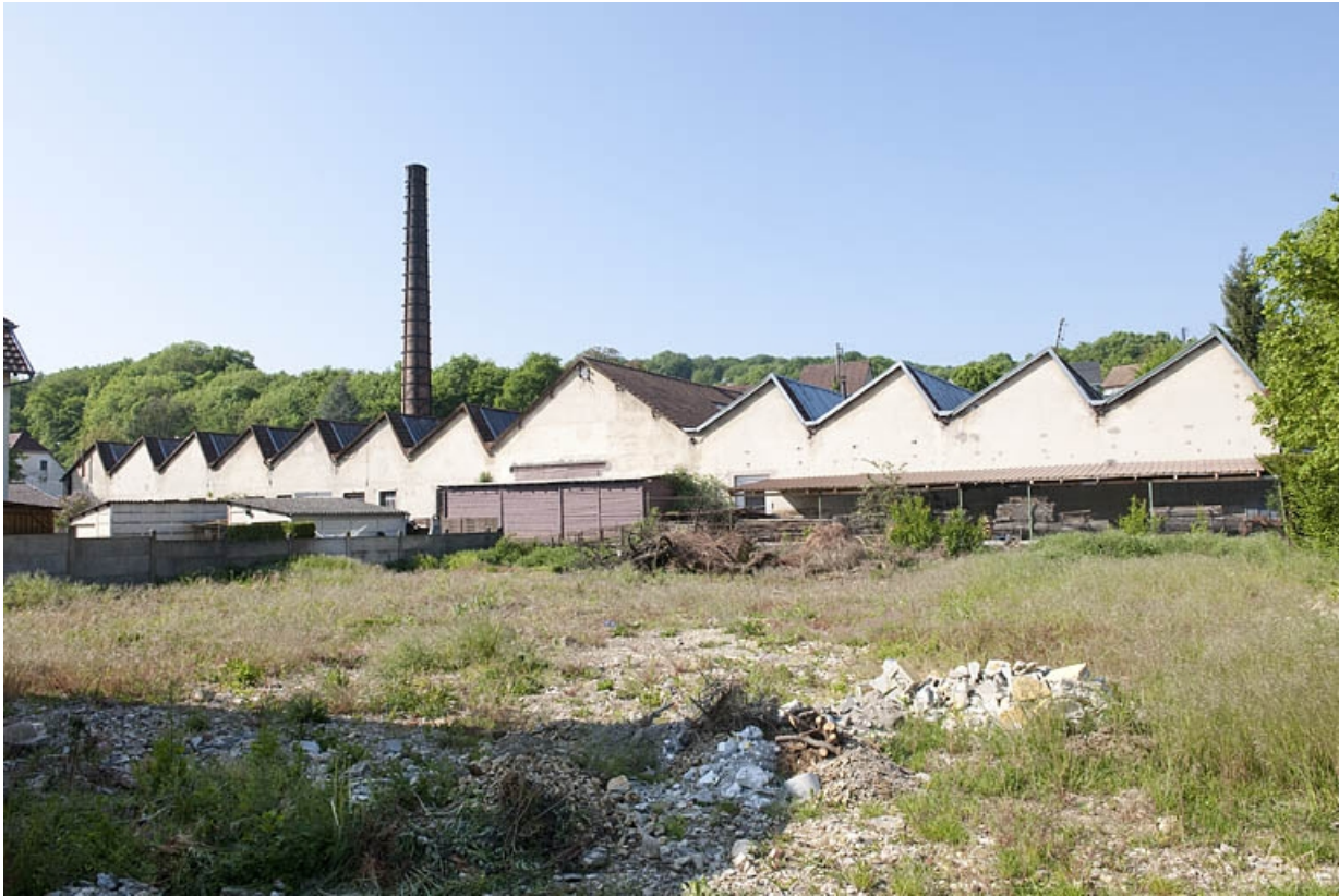
Atelier de laitonnerie. Façade ouest.
