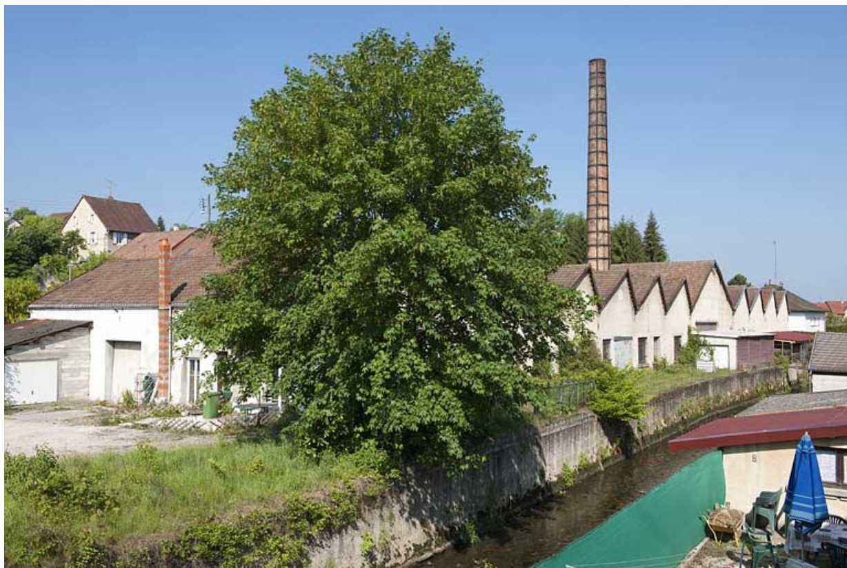
Atelier de laitonnerie. Vue depuis le sud-est.
