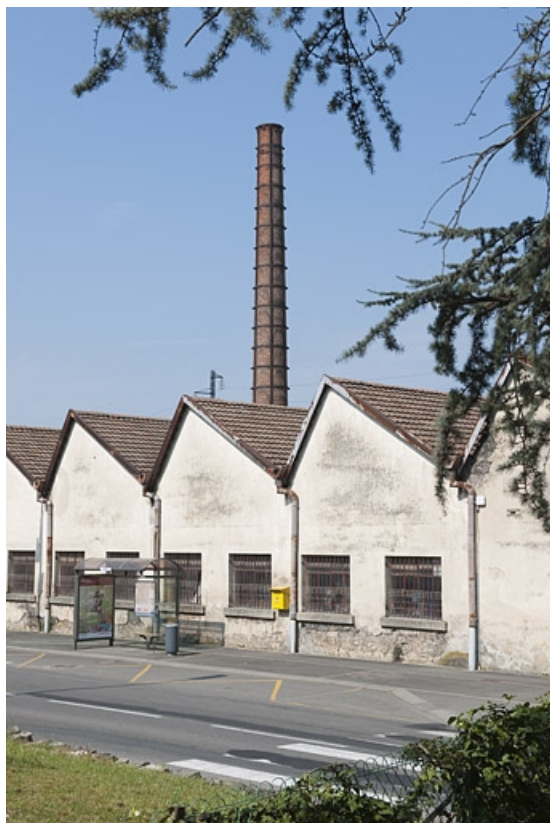
Vue rapprochée de l'atelier de laitonnerie.
