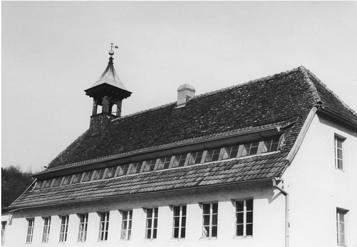
Toiture de l'atelier de fabrication est en 1980.
