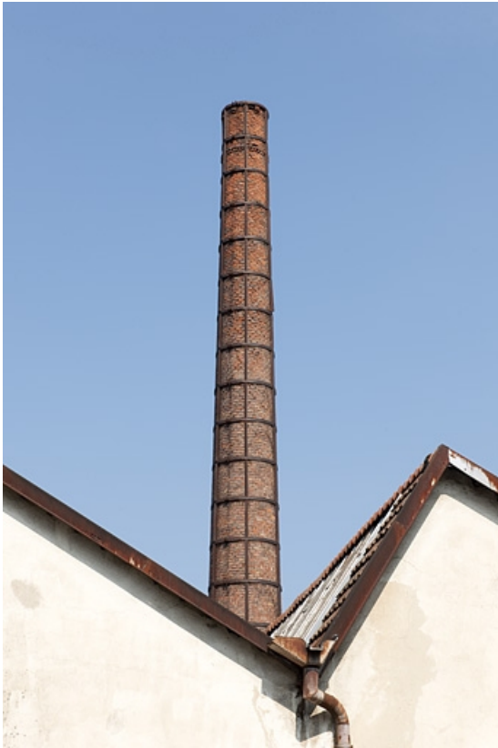
Sheds et cheminée de l'atelier de laitonnerie.
