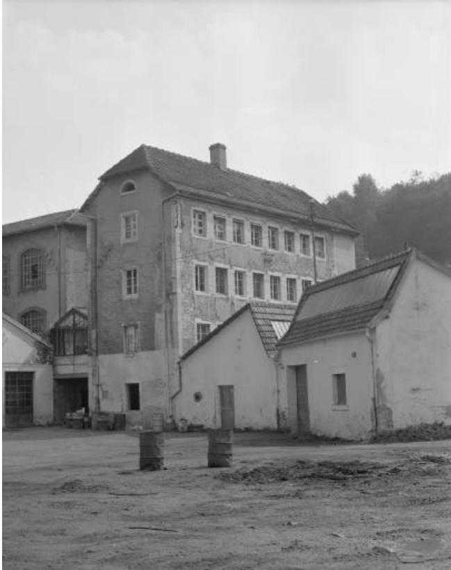
Élévation d'un ancien atelier en 1981.
