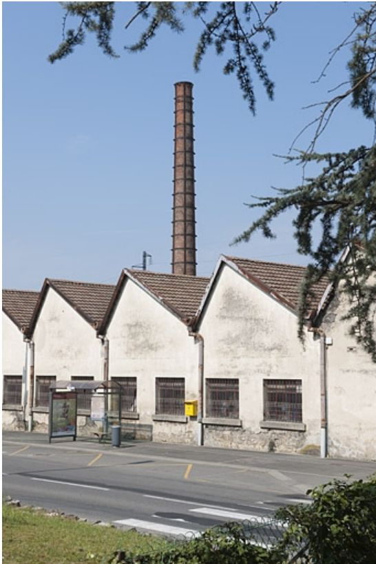
Vue rapprochée de l'atelier de laitonnerie.
