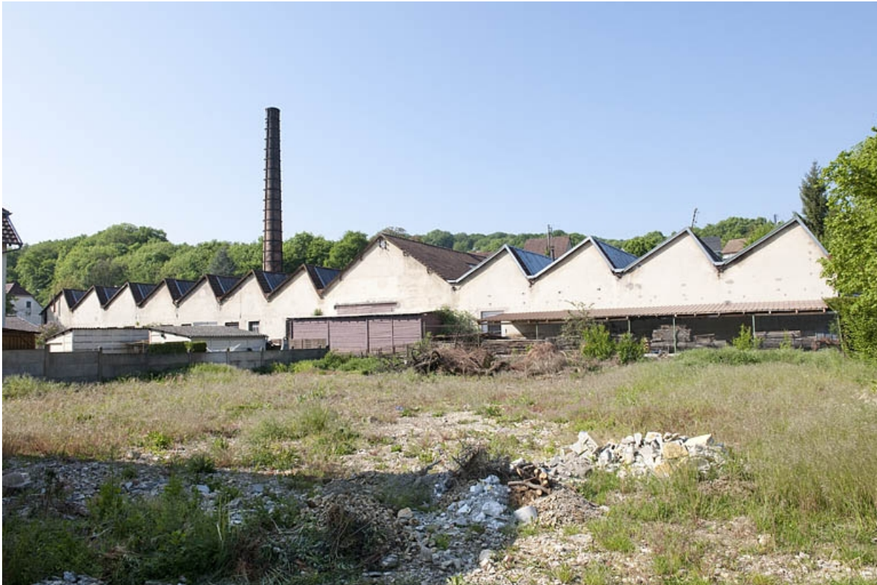
Atelier de laitonnerie. Façade ouest.
