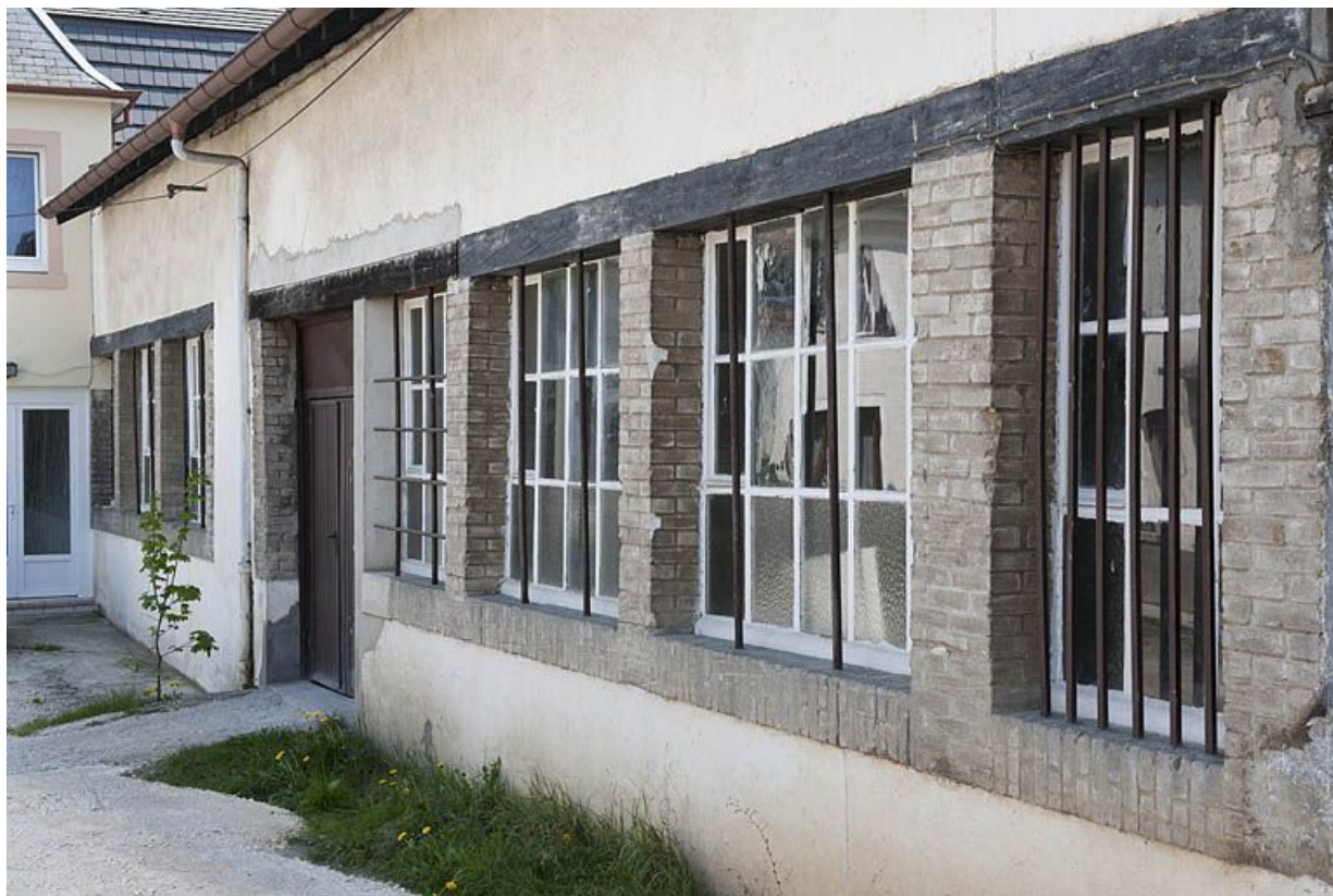
Mur nord de l'atelier de fabrication.
