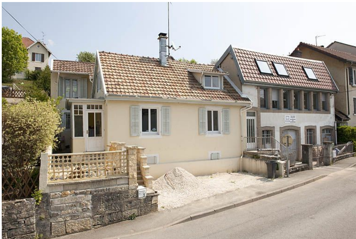
Logement et atelier depuis le nord-ouest.
