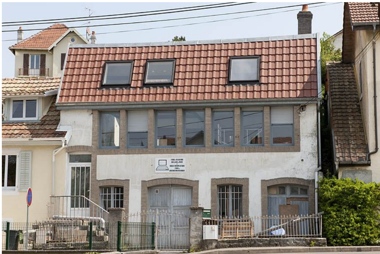
Façade ouest de l'atelier de fabrication.
