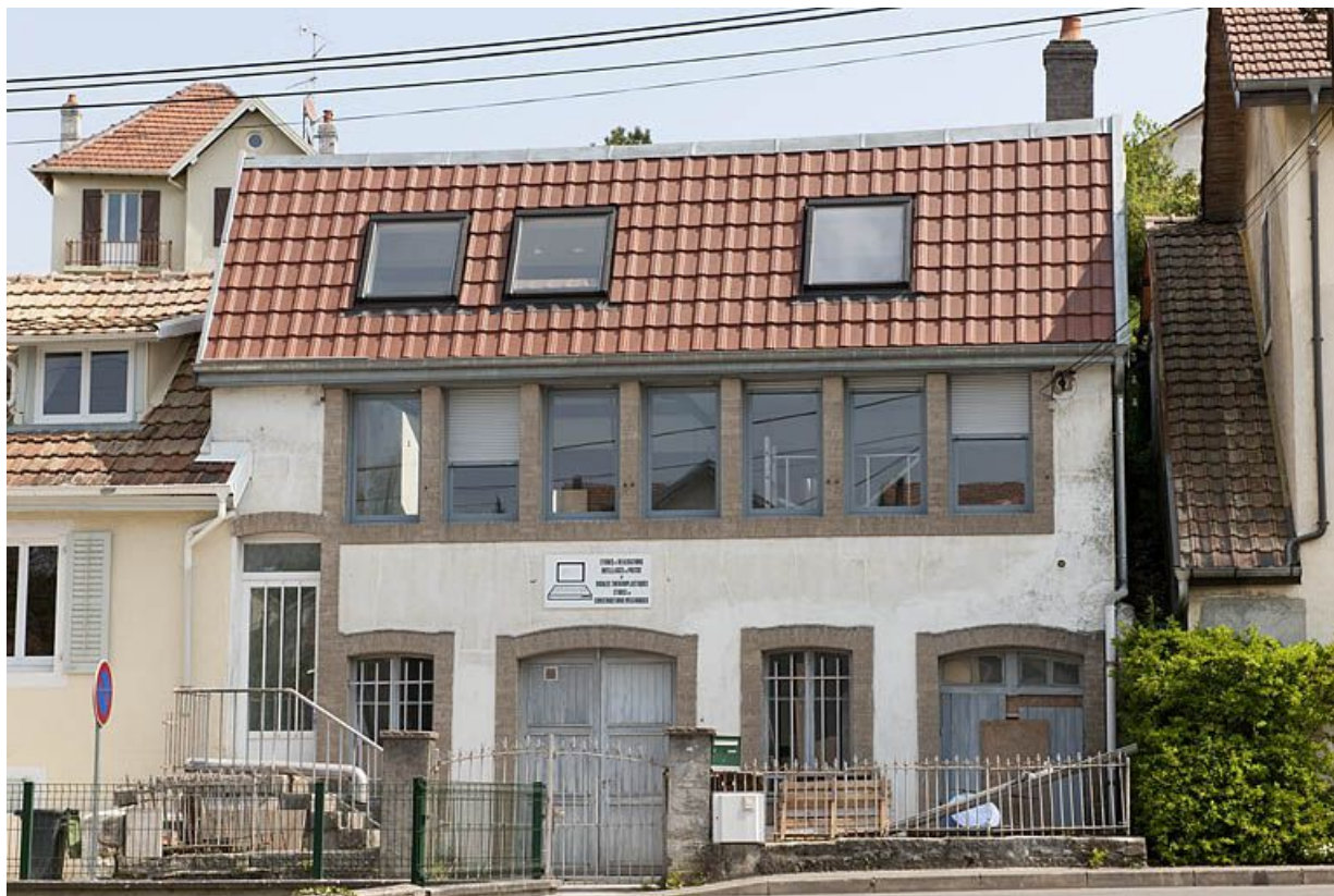
Façade ouest de l'atelier de fabrication.
