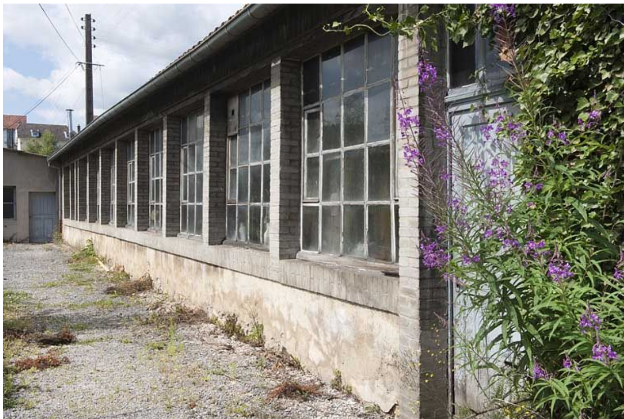
Façade est de l'atelier de décolletage primitif.
