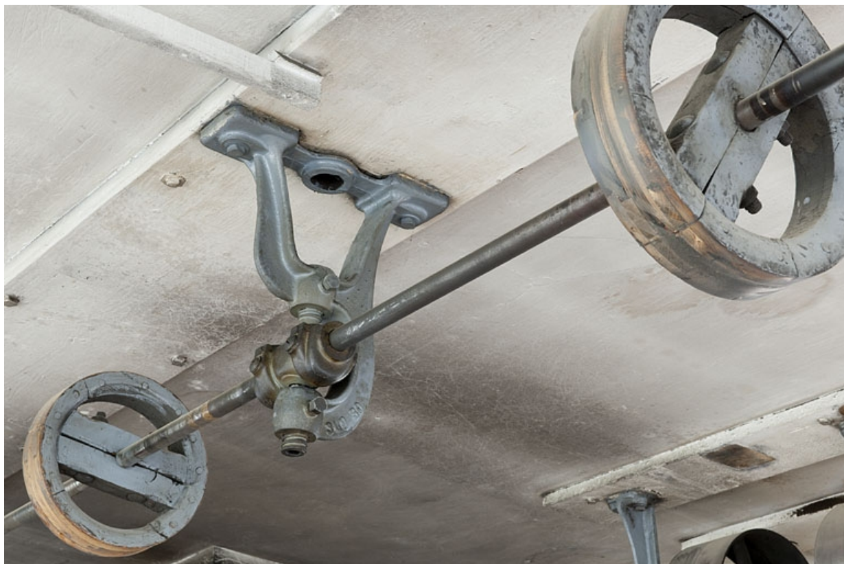
Intérieur de l'atelier. Transmission horizontale : console, axe et poulies.
