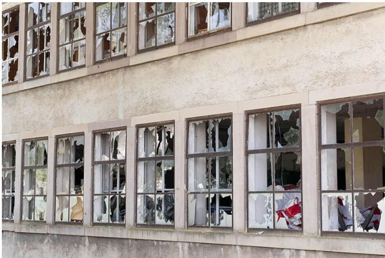
Détail des baies de la façade postérieure.
