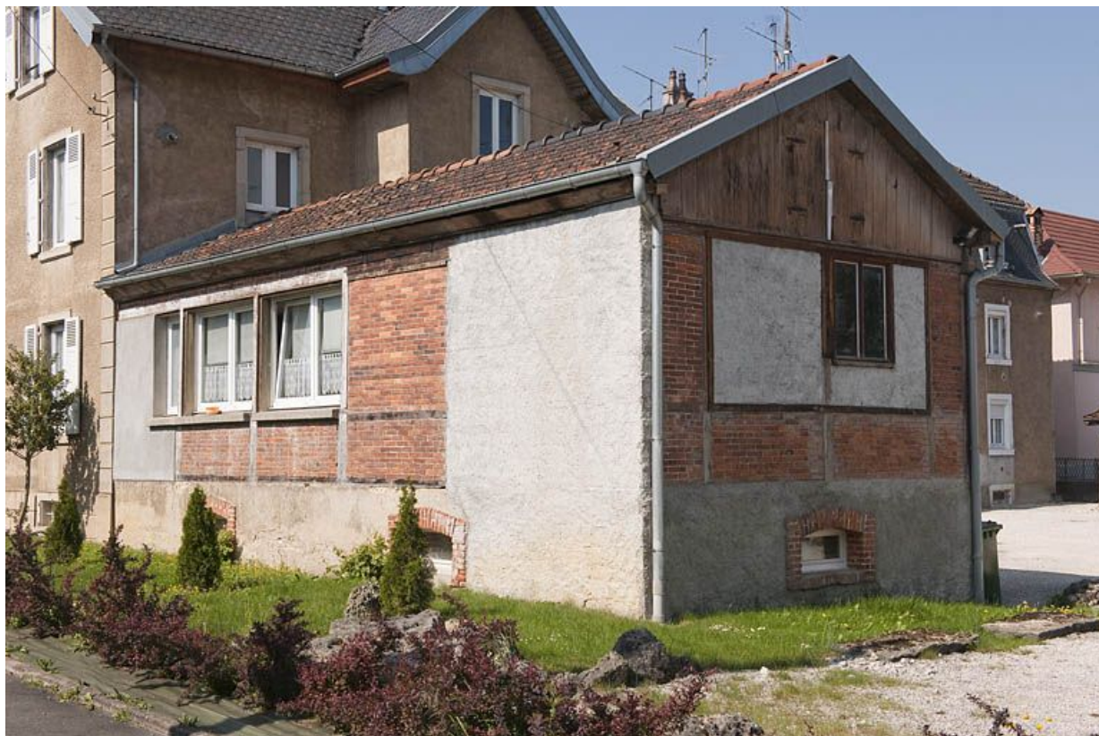
Atelier d'horlogerie adossé à la façade postérieure du logement patronal.
