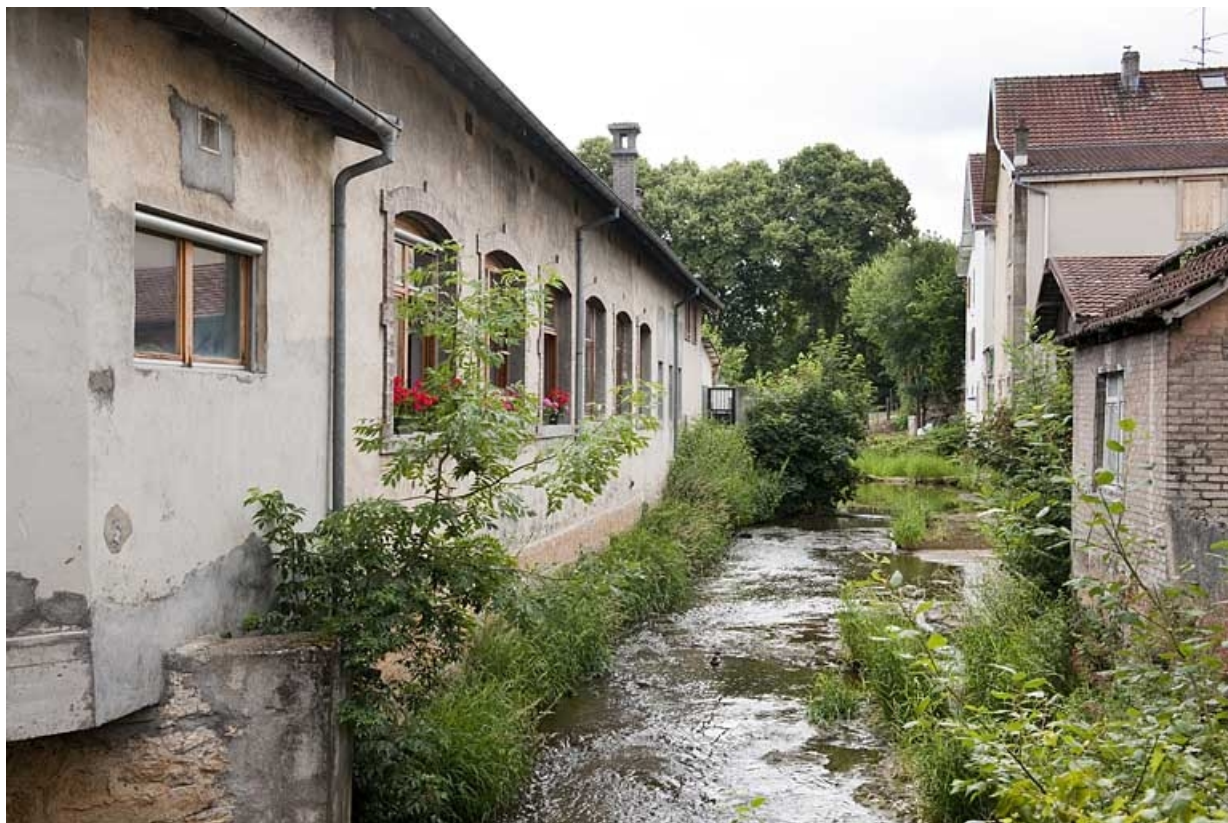
Vue sur l'amont du Gland depuis le passage couvert.
