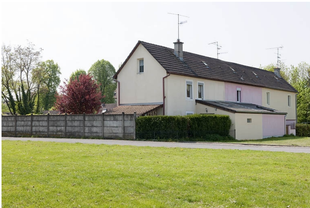
Bâtiment des magasins, remises et logements. Vue de trois quarts arrière.
