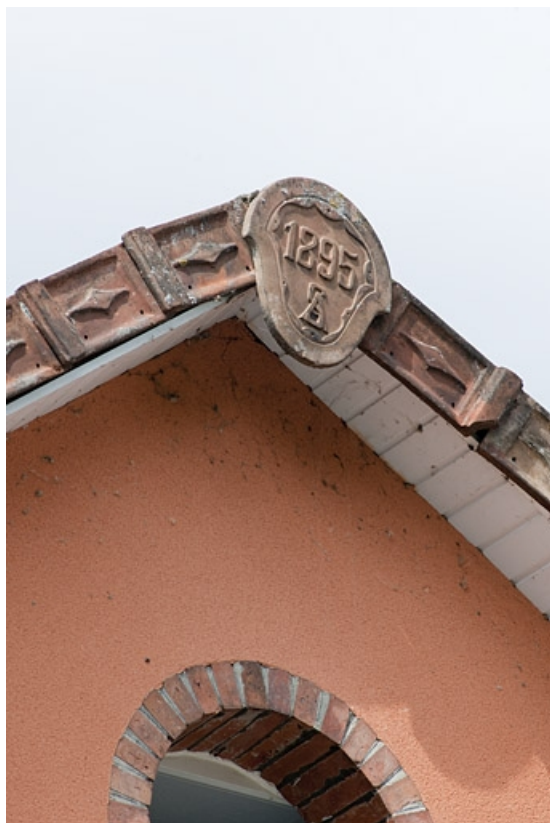
Pignon nord du bâtiment originel. Faîte du toit.
