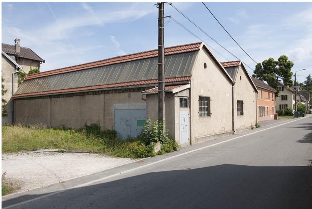
Atelier de fabrication. Extension occidentale. 25, Seloncourt rue des Vignottes
