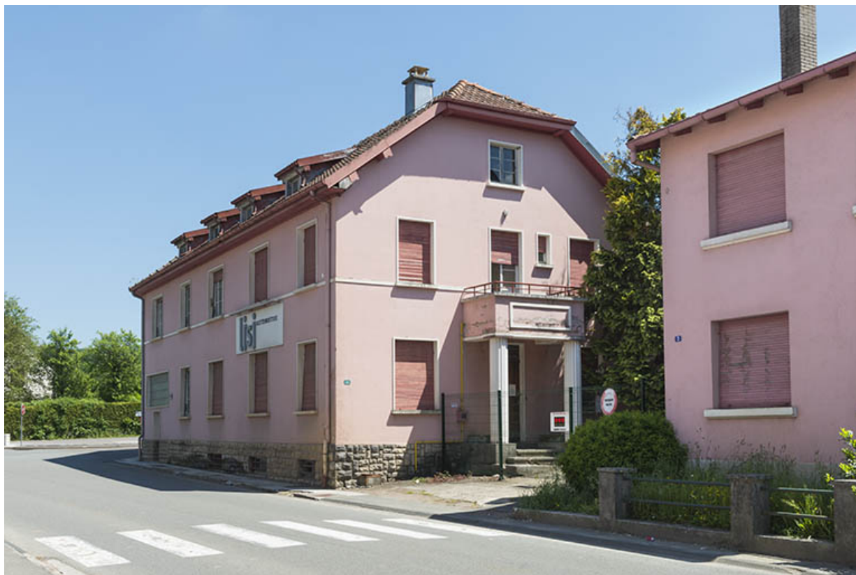
Bâtiment administratif désaffecté. Vue de trois quarts droit.
