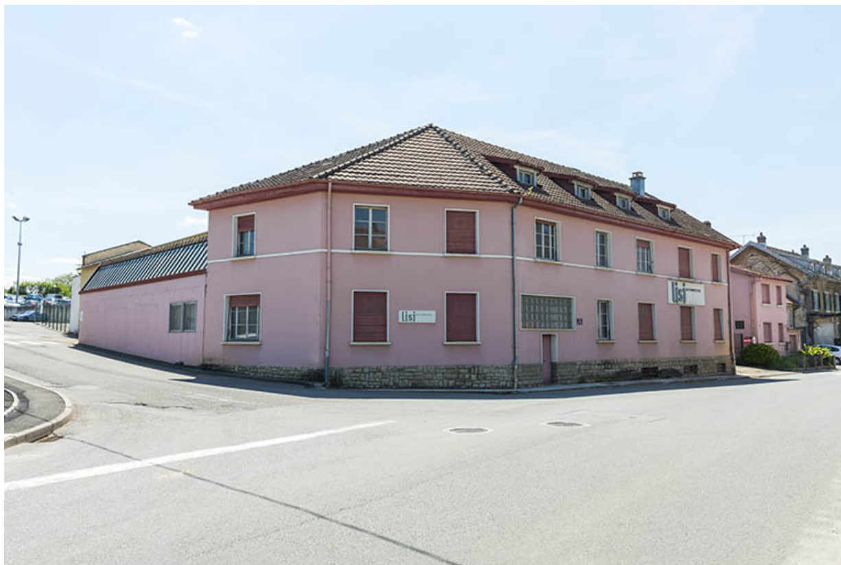
Bâtiment originel de la société Beley (actuellement bâtiment administratif désaffecté). 25, Dasle, 1 rue Centrale
