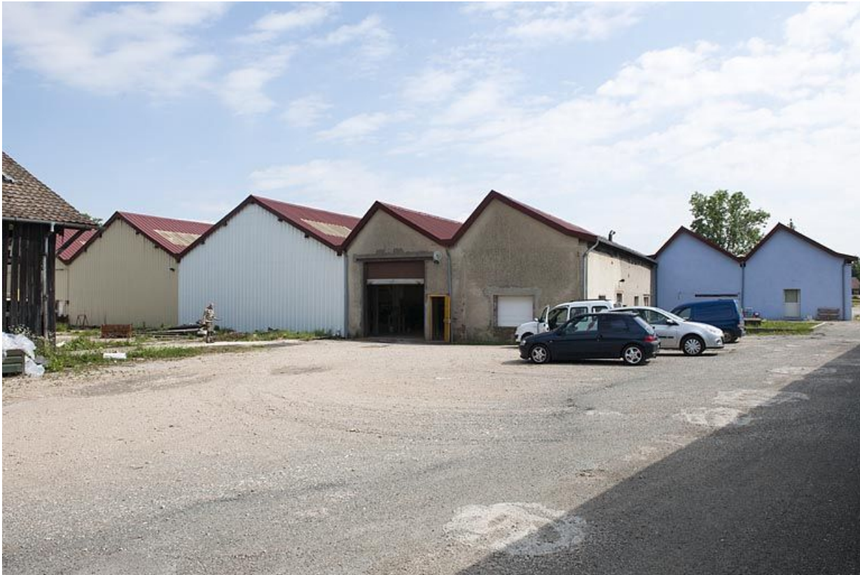
Pignons sud de l'atelier de fabrication.
