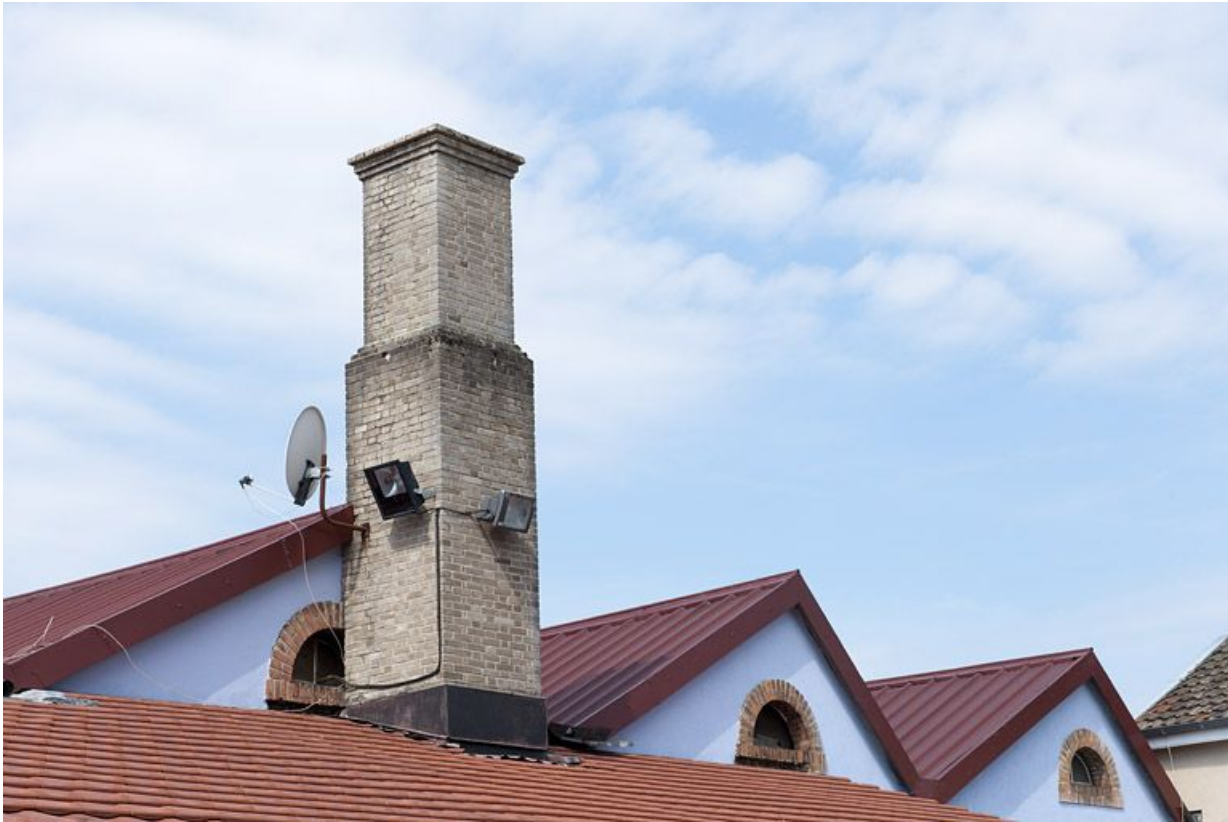
Détail de la cheminée de l'ancienne chaufferie.
