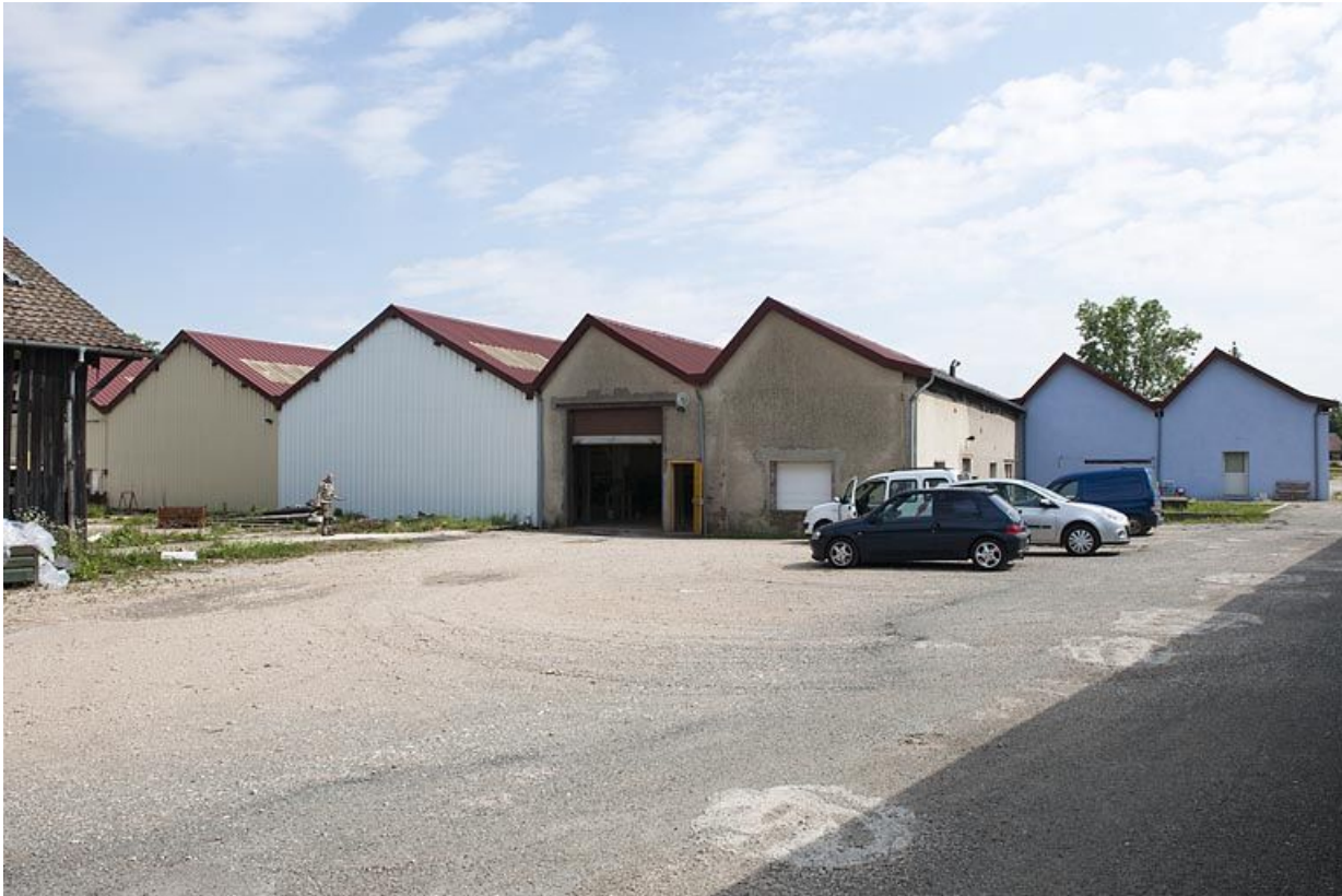
Pignons sud de l'atelier de fabrication.
