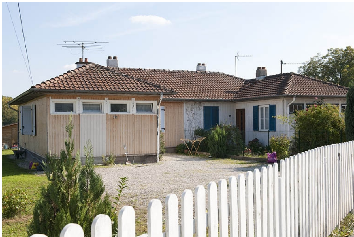
Maison jumelée située aux n°12-14.
