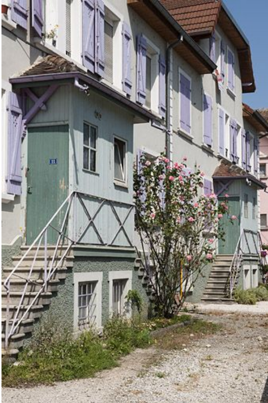
Détail de la façade antérieure de l'immeuble sud.
