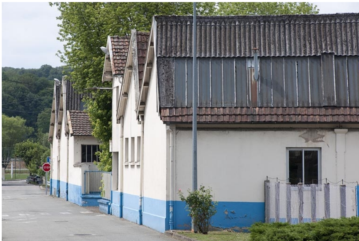
Alignement des bâtiments sur la rue du Stade. 25, Arbouans, 2 rue du Stade
