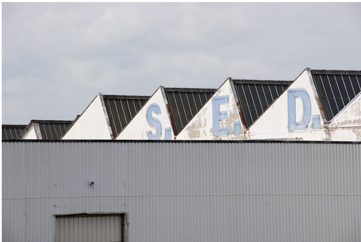
Atelier de fabrication. Détail des pignons des sheds.
