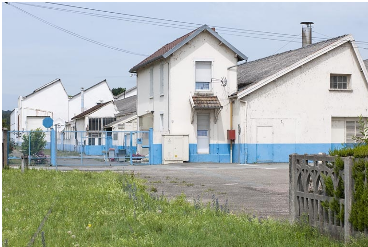
Bâtiments sud et conciergerie depuis le sud-est.
