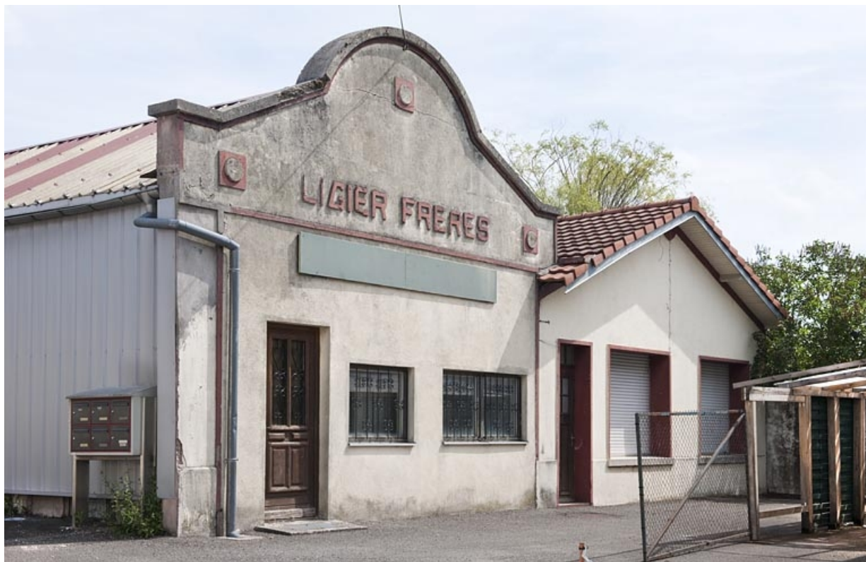
Pignon de l'atelier de fabrication originel.
