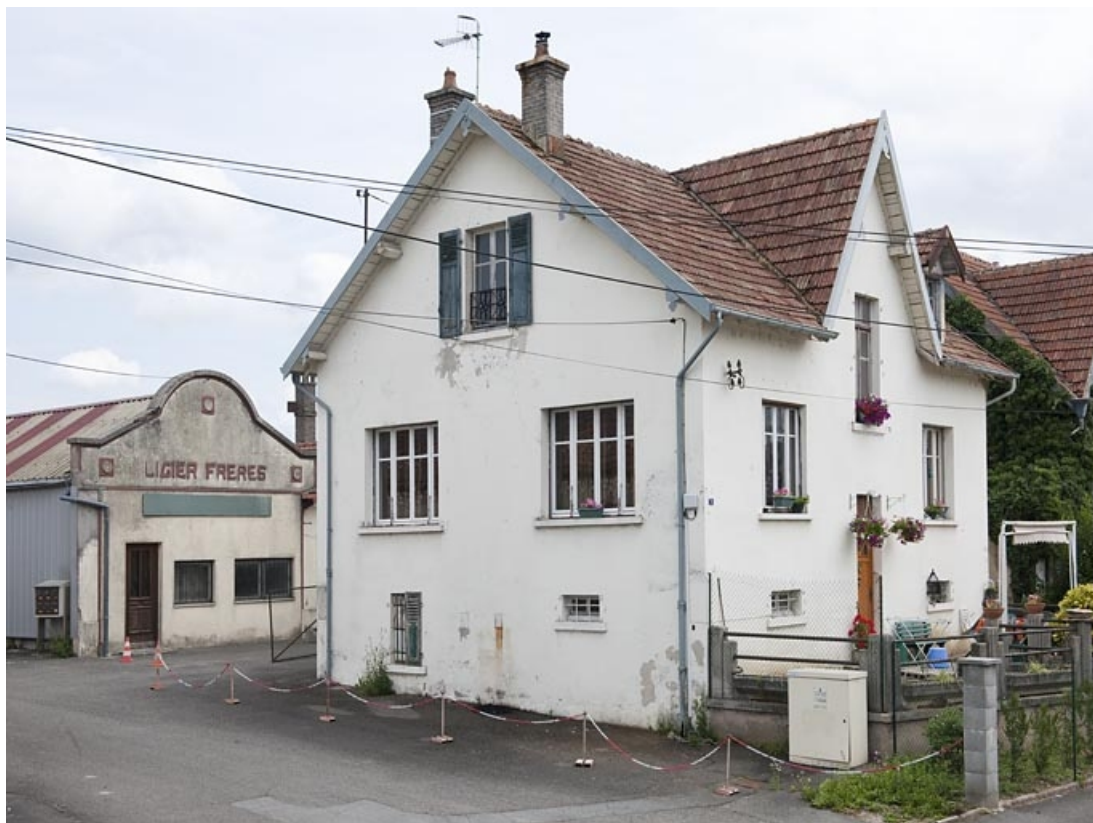
Atelier de fabrication et logement depuis la rue. 25, Audincourt, 9 rue des Cantons
