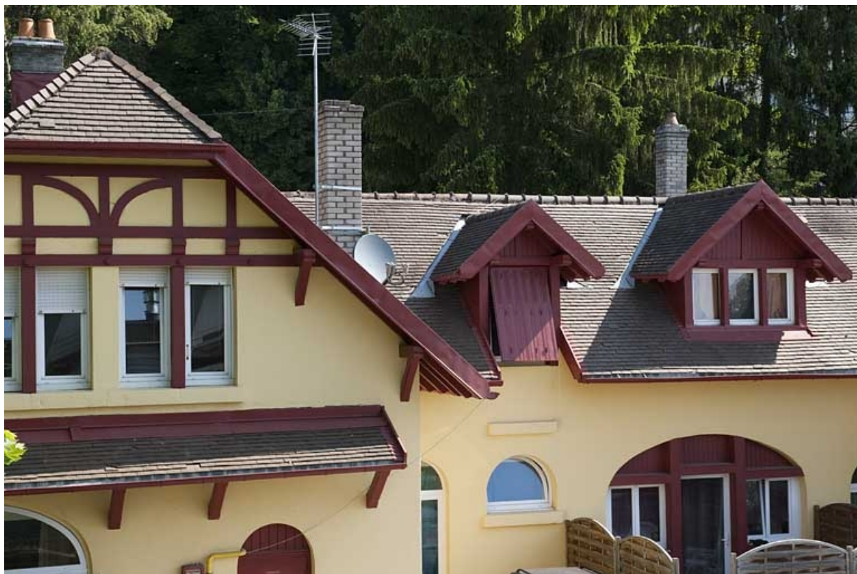
Bâtiment des communs. Détail de la façade sud.
