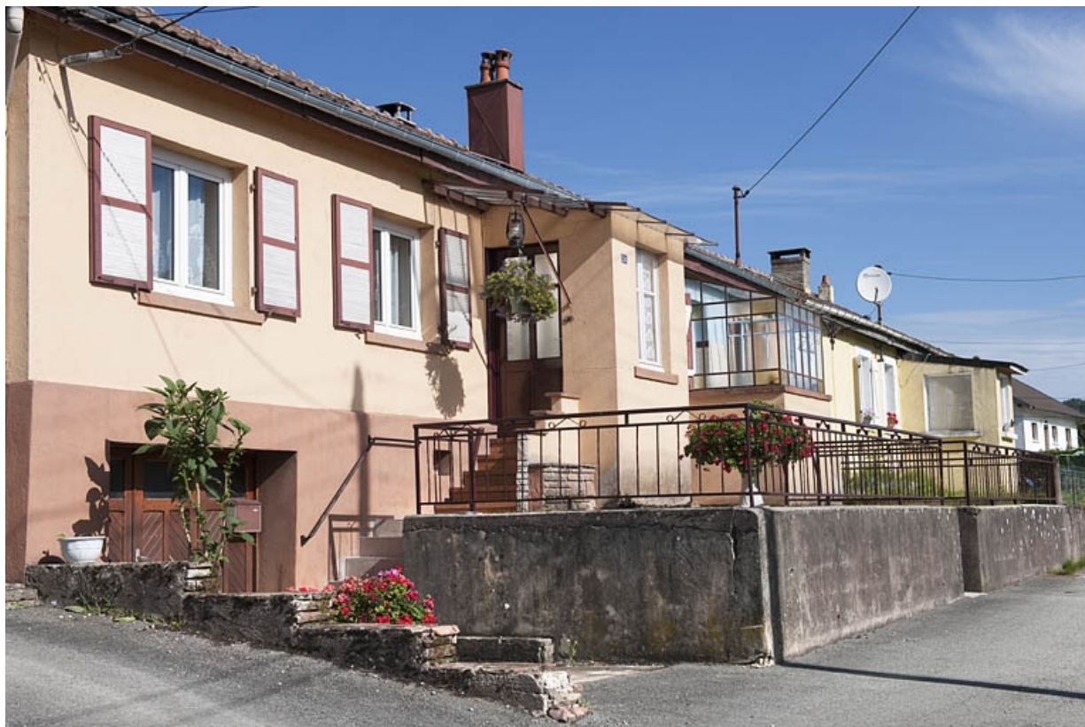
Habitation ouvrière en rez-de-chaussée. Vue de trois quarts gauche. 25, Bart rue du Mont-Bart
