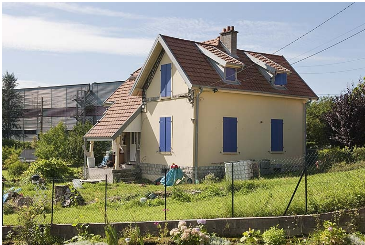
Maison jumelée. Vue de trois quarts arrière. 25, Bart rue du Mont-Bart
