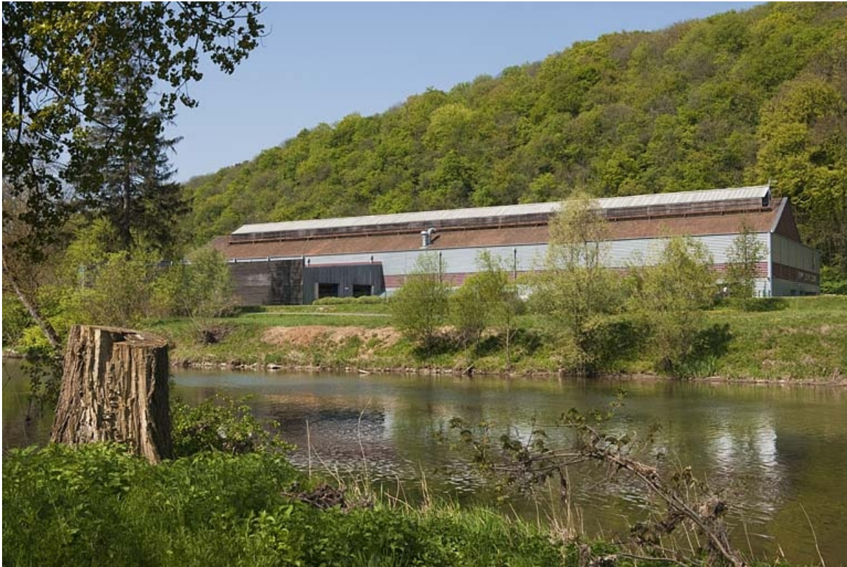
Vue d'ensemble depuis la rive gauche de l'Allan.
