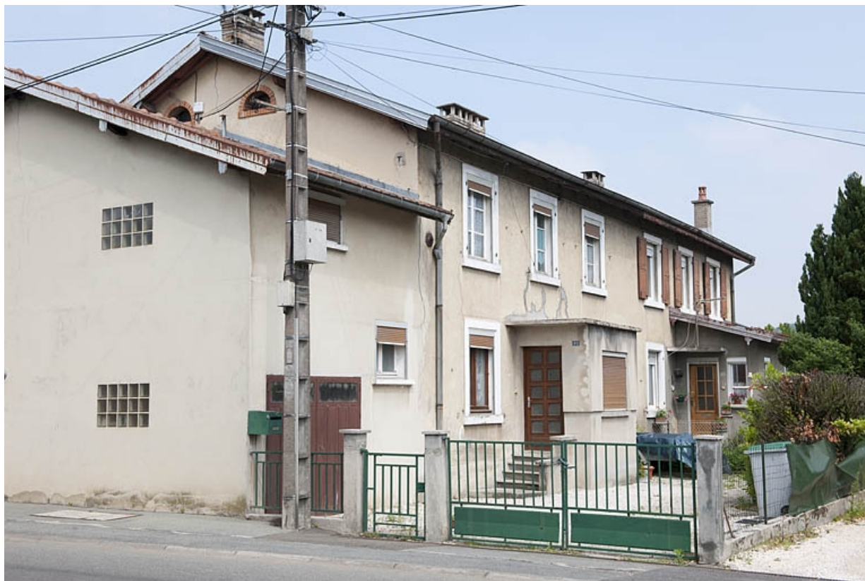
Cité ouvrière. Façade est d'une habitation.
