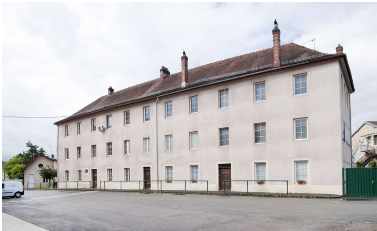
Bâtiment administratif et logement patronal. Façade antérieure.
