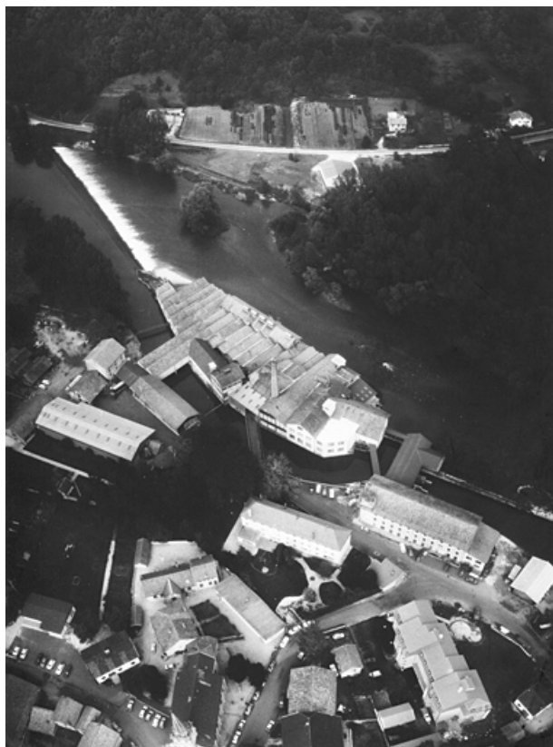
Vue aérienne depuis l'ouest.
