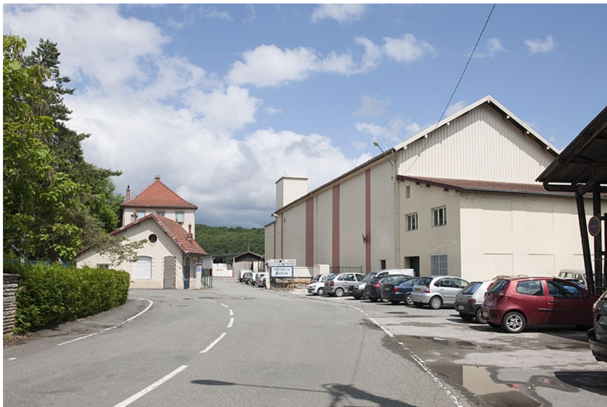
Vue d'ensemble de l'entrée de la papeterie.
