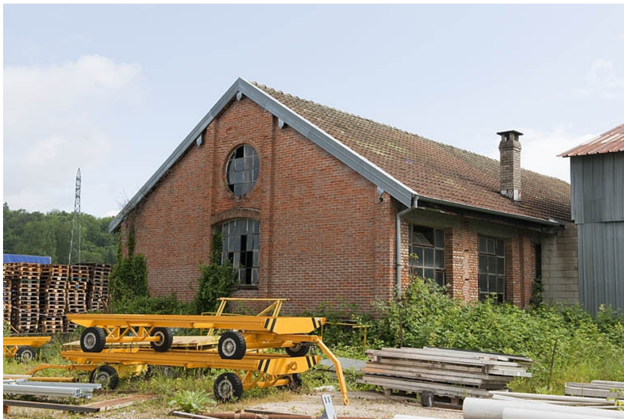
Entrepôt industriel vu de trois quarts arrière. 25, Mandeure, 14 rue de la Papeterie
