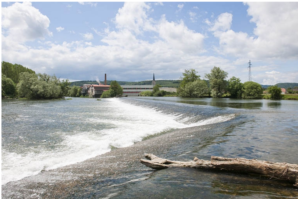
Vue d'ensemble depuis la tête du barrage, rive gauche.
