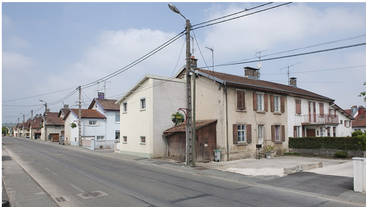
Cité ouvrière. Vue d'ensemble depuis la route départementale.
