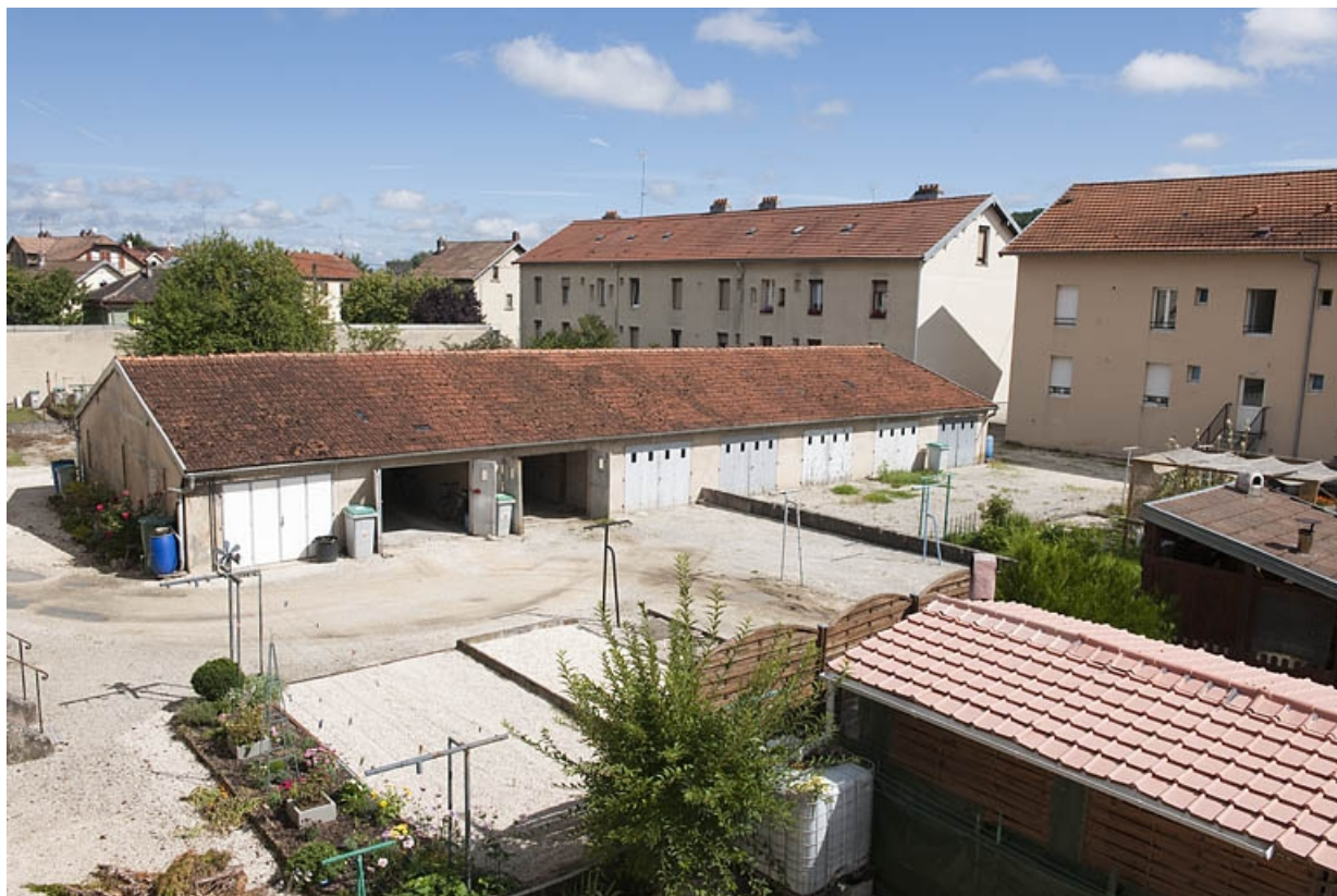
Façades postérieures des habitations sur les jardins et garages.
